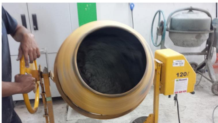
Foto 1 – Mistura do concreto em betoneira de 120 litros
