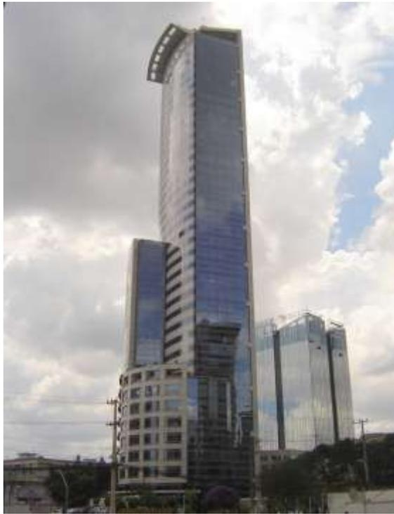
**Figura 2.7** – Edifício e-Tower em São Paulo, recorde mundial de resistência na utilização de concreto de alto desempenho colorido (fck médio de 125 MPa). (HELENE et al., 2002)
