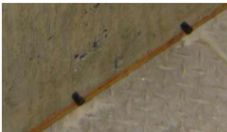
Figura 5. 36 - Tampões de borracha vedando drenos no prisma.
