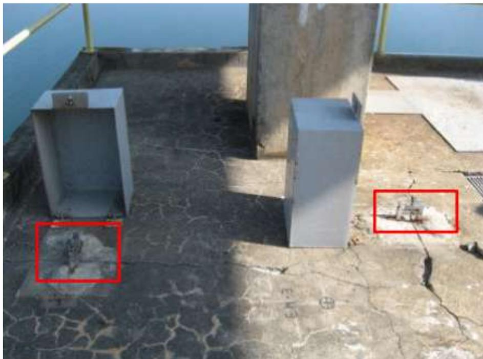
**Figura 3. 15 - Medidores triortogonais instalados para monitoramento de fissuras superficiais. (SALLES, 2010)**
