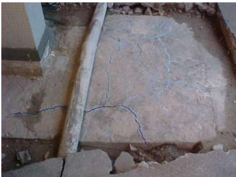
**Figura 4. 2 - Exemplo de bloco de fundação com fissuração formando grandes placas.
