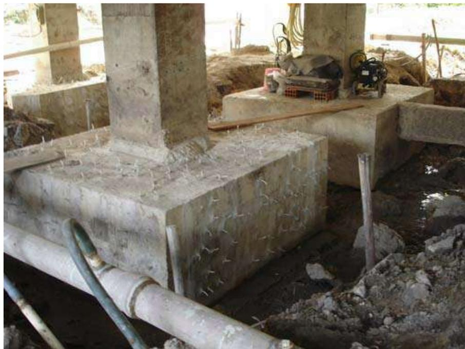
**Figura 3. 16 – Escavação para acesso aos blocos de fundação de edifício em Recife.
