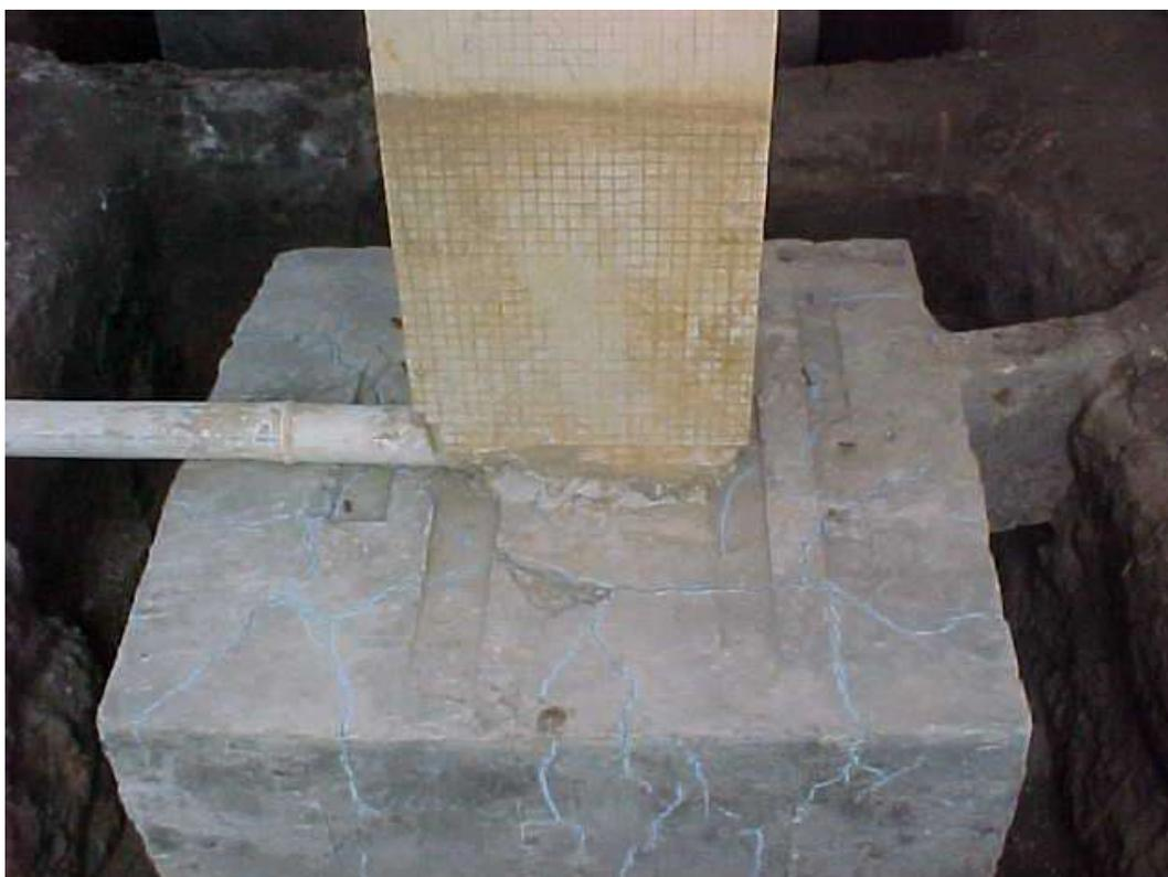
Figura 1. 4 – Bloco de fundação com quadro fissuratório (ANDRADE, 2006).
