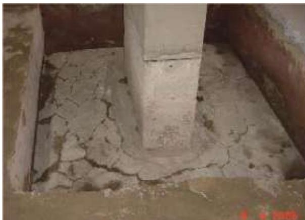
**Figura 6. 9 - Bloco de fundação de edifício com RAA. (ANDRADE, 2006)**
