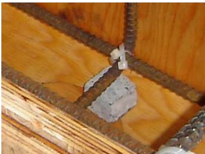
Figura 5. 35 - Espaçador posicionado no fôrma.
