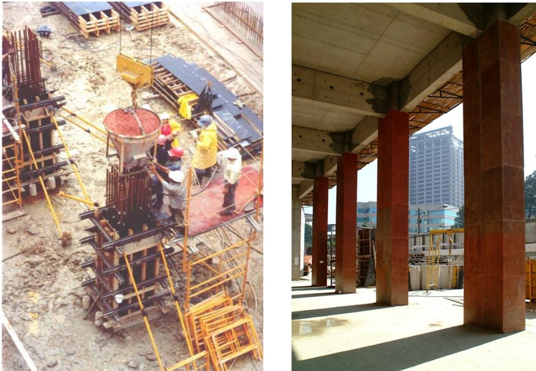
**Figura 54** – Pilares de concreto armado colorido de alta resistência do edifício e-Tower em fase de construção e concluídos (acervo do Prof. Paulo Helene).
