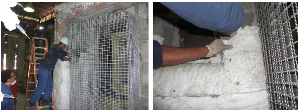
**Figura 95** – Detalhe da instalação da manta em fibra cerâmica na parte interna da alvenaria.
