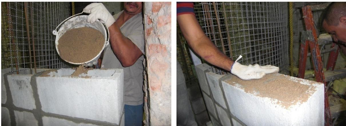
**Figura 92** – Detalhe do preenchimento com areia no interior dos blocos que não foram grauteados.
