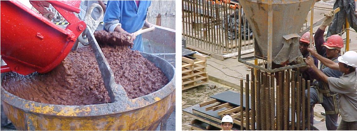
**Figura 57** – Atividades relacionadas ao lançamento do concreto colorido de alta resistência, com uso de caçambas usuais, na obra do edifício e-Tower, em 2002 (acervo do Prof. Paulo Helene).
