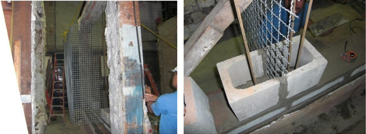
**Figura 90** – Detalhe do posicionamento da gaiola em tela de aço galvanizado.
