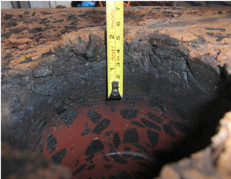
**Figura 110** – Detalhe da alteração de cor promovida pela reação química de redução do óxido de ferro ( $\text{Fe}_2\text{O}_3$ ) nos primeiros 55 milímetros de profundidade do pilar (região do centro da face exposta ao fogo do elemento).
