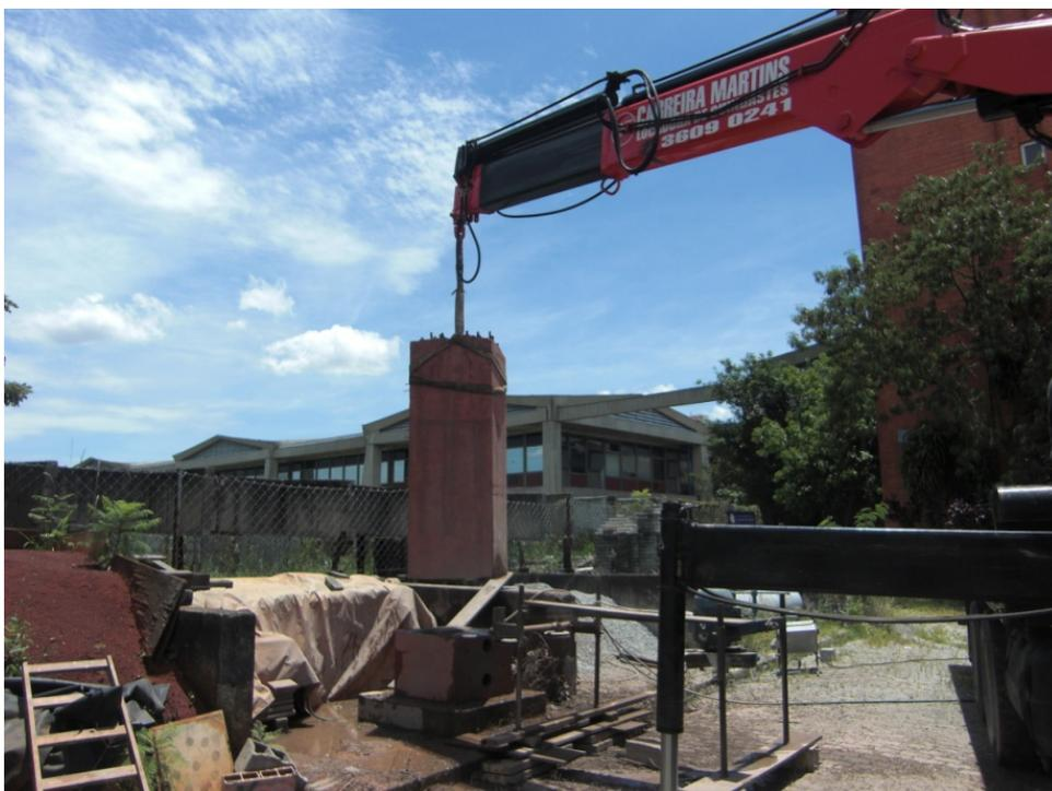
**Figura 80** – Procedimento de içamento do pilar protótipo (já cortado na altura de 200cm).
