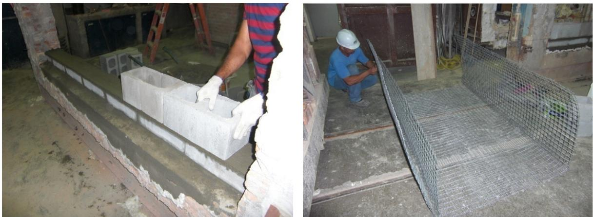
**Figura 89** – Detalhe da execução da alvenaria e da gaiola em tela de aço galvanizado.
