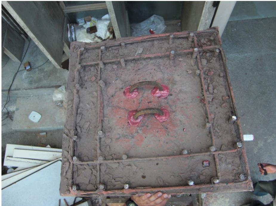
**Figura 77** – Detalhe dos ganchos de aço ancorados quimicamente para posterior içamento do pilar, com massa estimada de 2,5t.
