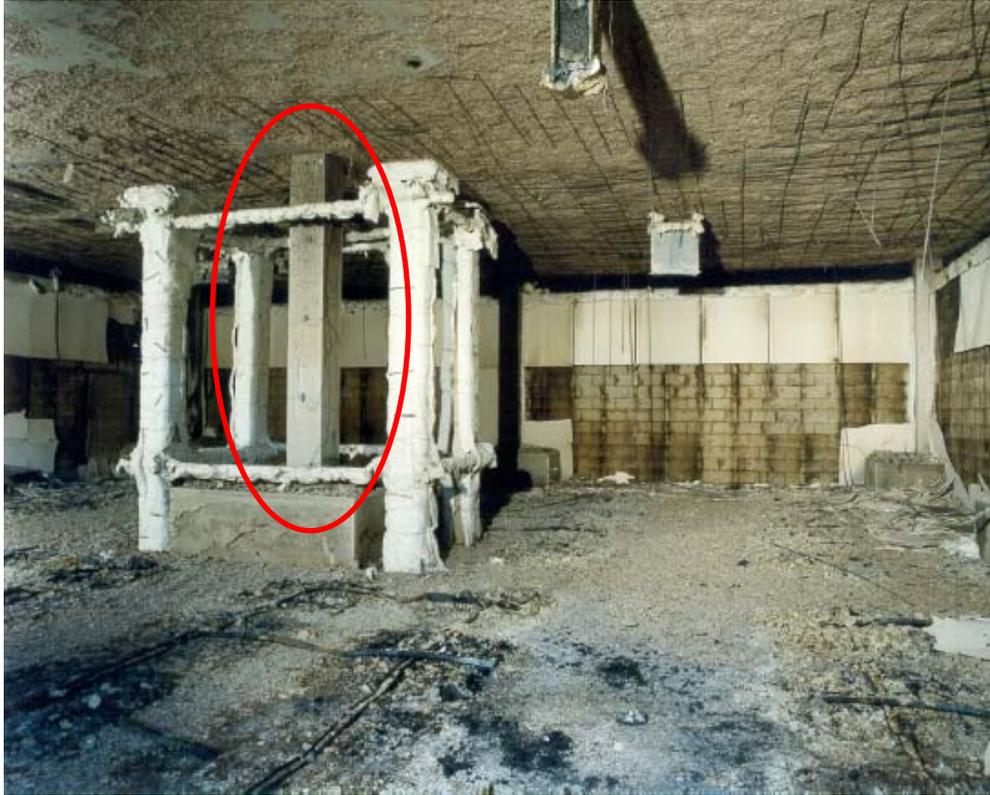
**Figura 39** – Detalhe da extensão e da severidade da ocorrência de *spalling* nas lajes após a simulação de incêndio. No destaque, observar as condições de integridade do pilar de concreto de alta resistência (Chana e Price, 2003).
