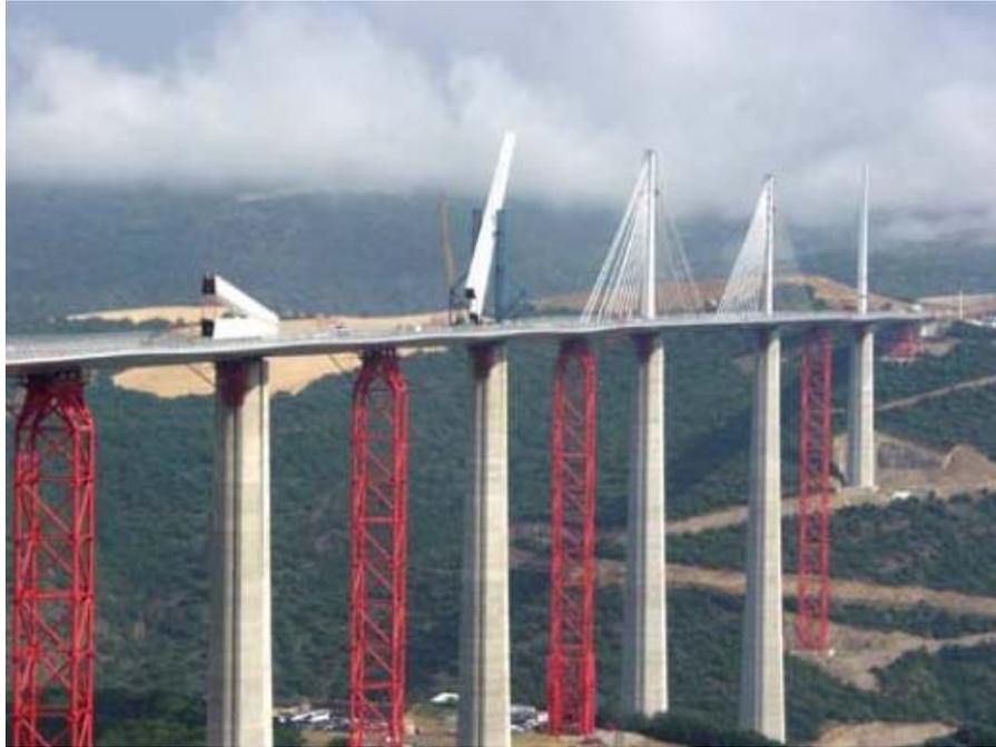
**Figura 1** – Viaduto de *Millau*, durante a construção (VIADUC DE MILLAU, 2010).
