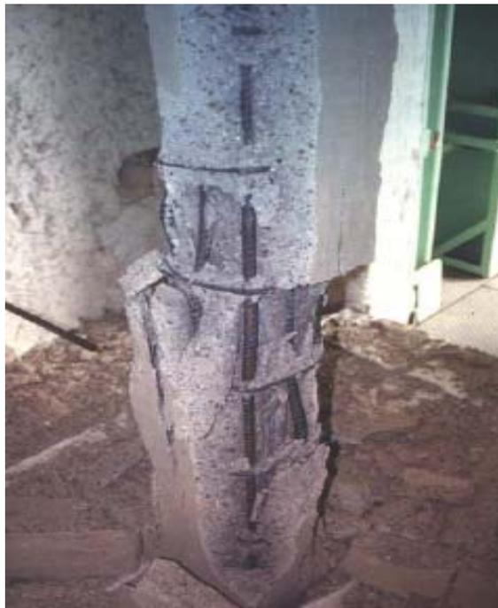
**Figura 8** – Exemplo de *spalling* explosivo ocorrido em pilar de concreto de alta resistência  $f_{ck} = 83\text{MPa}$  (Kodur, 2005).
