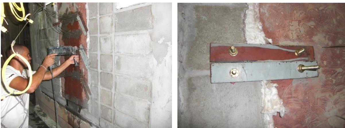
**Figura 97** – Detalhe da fixação do pilar na alvenaria, através de chapas metálicas parafusadas.
