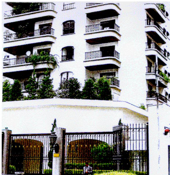
Figura III-21 Revestimento externo de argamassa com material reciclado, obra situada rua Conselheiro Brotero, 1263 - São Paulo. Concluída em 1987
