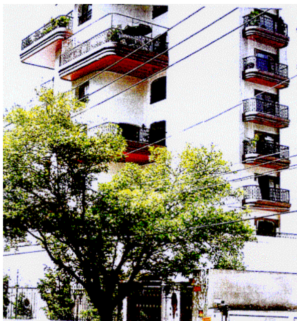
Figura III-22 Revestimento externo de argamassa com material reciclado, obra situada rua Gabriel dos Santos, 423 - São Paulo. Concluída em 1987
