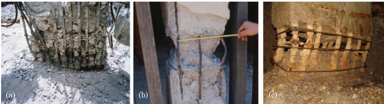
Figura 4. Esmagamento de concreto em pilar de obra: (a) e (c) devido à má execução (bicheiras) e (b) devido a erro de projeto (dimensionamento insuficiente). Na esmagadora maioria das vezes, a resistência à compressão efetiva do concreto na obra é inferior à do concreto medida no corpo de prova de referência. O corpo de prova de controle mede a resistência potencial do concreto na “boca da betoneira”, sob condições ideais de adensamento, cura e ensaio.
