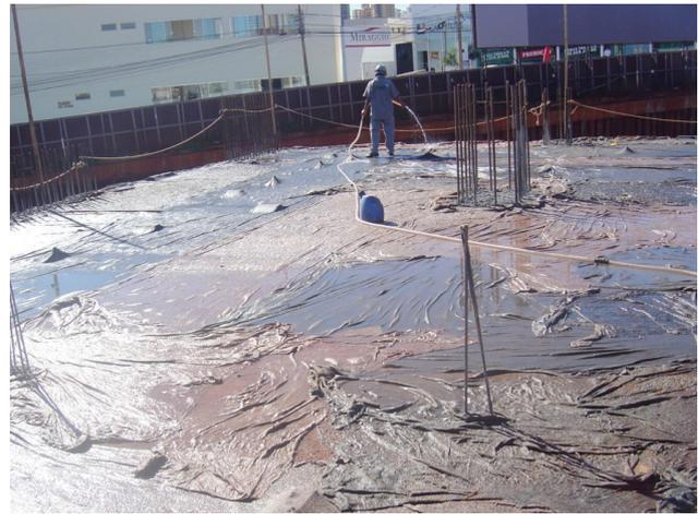
1.b Cura úmida com manta absorvente, permeável e saturada.
