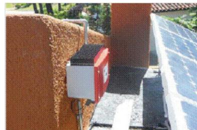
Colectores solares fotovoltaicos y contador de consumo de energía eléctrica de doble orientación
