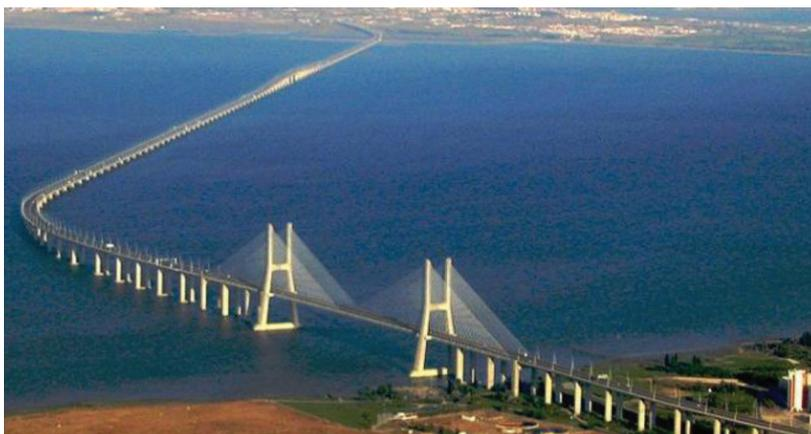
Figura 5. Ponte Vasco da Gama, projectada para uma Vida Útil Estrutural de 120 anos
