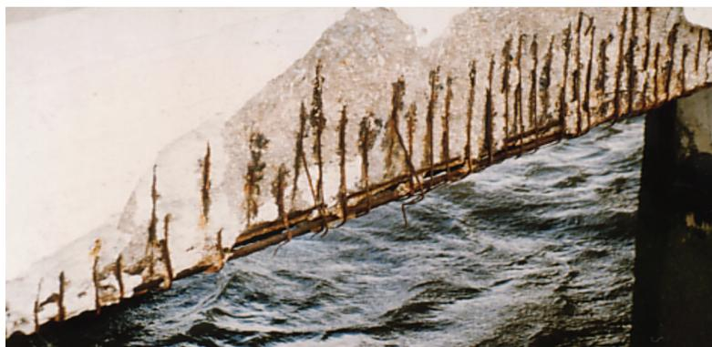
Figura 4. Deterioração de concreto armado (foto de Fernando Branco).
