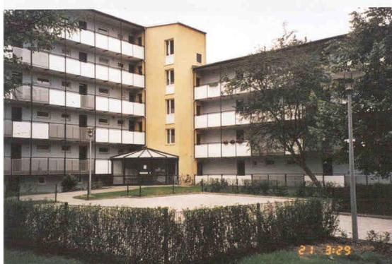
Figura 10 Vista de um condomínio com 460 unidades em Hamburgo. Trata-se de um exemplo de construção complexa executada com agregados reciclados há 50 anos. (KROPP – 2000)<sup>10</sup>
