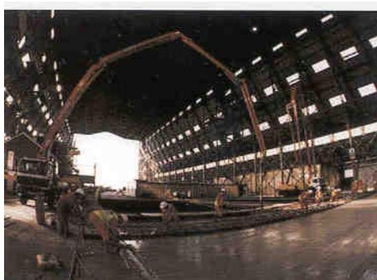
Figura 9 Piso de alta resistência do Laboratório de Cardinton BRE construído especialmente para analisar o efeito causado por substituição em massa de 20% de agregados reciclados de concreto e alvenaria de baixa qualidade. (COLLINS - 2000)<sup>9</sup>
