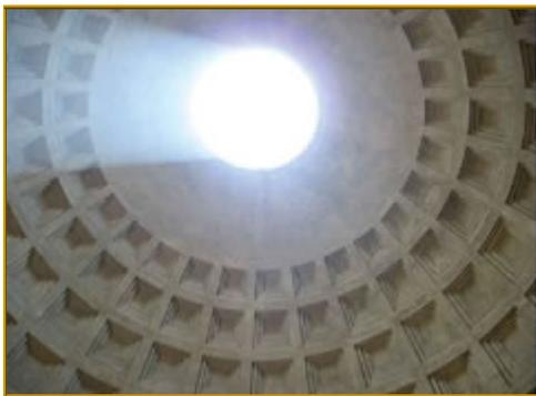
*En el concreto usado en el Panteón, en Roma, se trata de una mezcla de cal hidratada con arcilla puzolánica, abundante en la región de Pozzuoli, que se transformaba en un material durable pero de baja resistencia, comparada con las resistencias actuales.*
