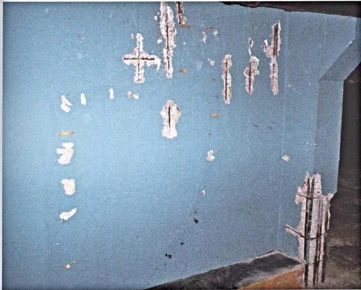
Cobrimento de armaduras insuficiente e corrosão de armaduras
