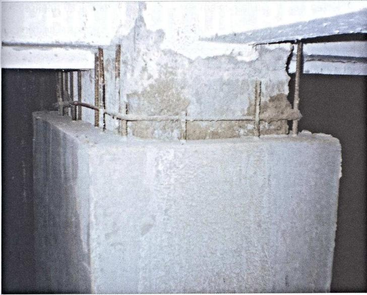
Detalhe da execução do reforço de um pilar
