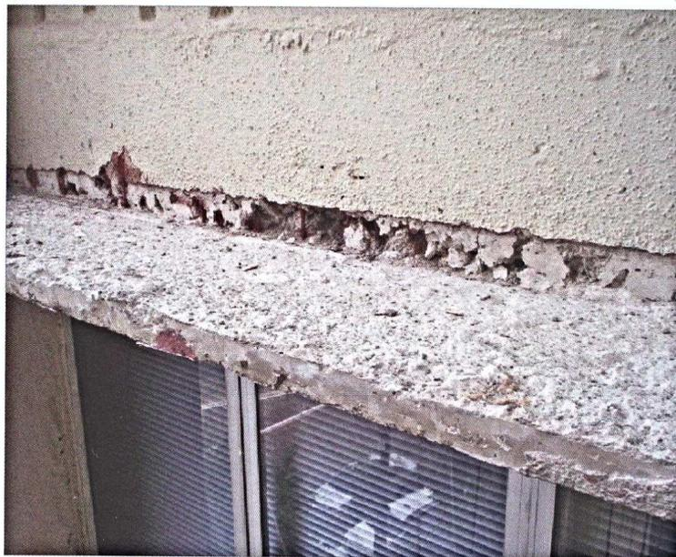
Ninhos de concretagem em elemento estrutural por falha de execução
