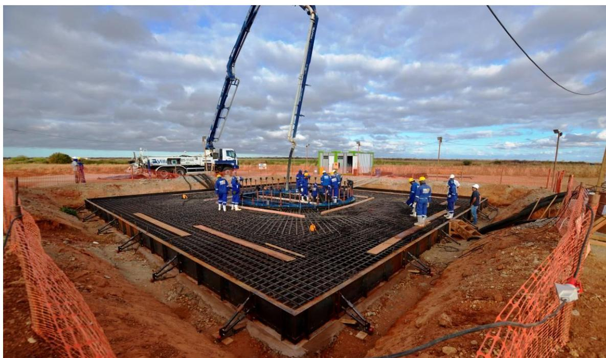
Figura 4. Vista do início da da concretagem de uma base
