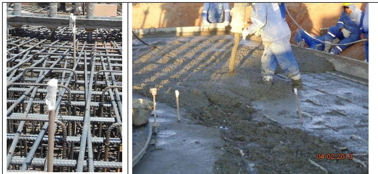
Figura 7. Termômetros instalados e concretagem da fundação
