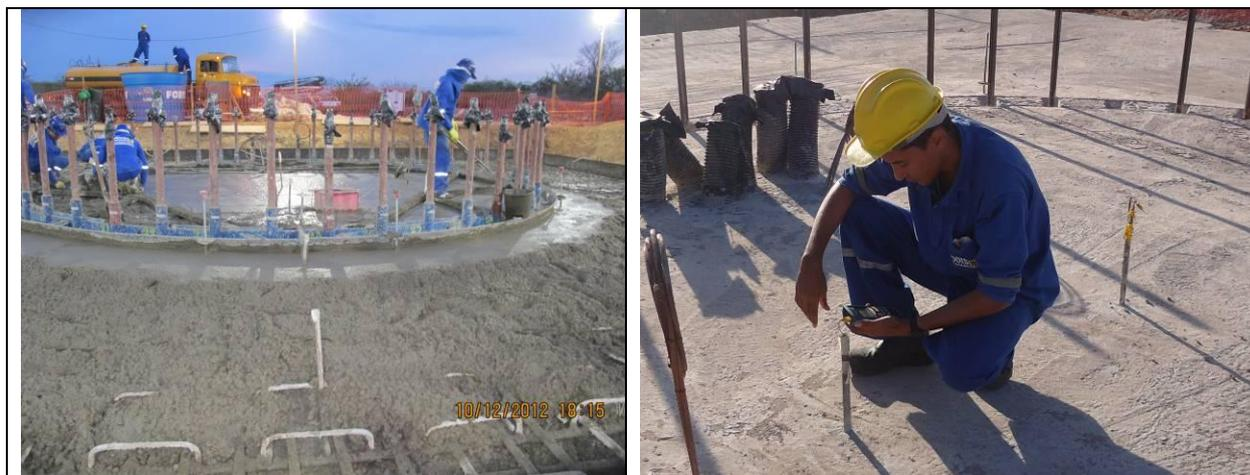
Figura 8. Concretagem da fundação e leitura nos termômetros
