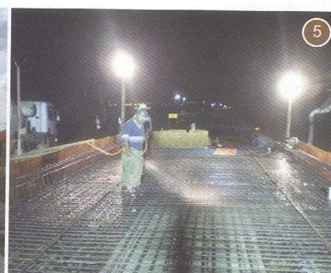
4. Cargamento con protección de acción solar. Cargamento de losa en un puente donde se colocó un techo para evitar la acción directa del sol.
