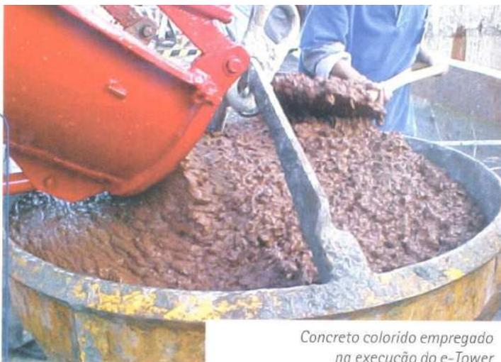
Concreto colorido empregado na execução do e-Tower
