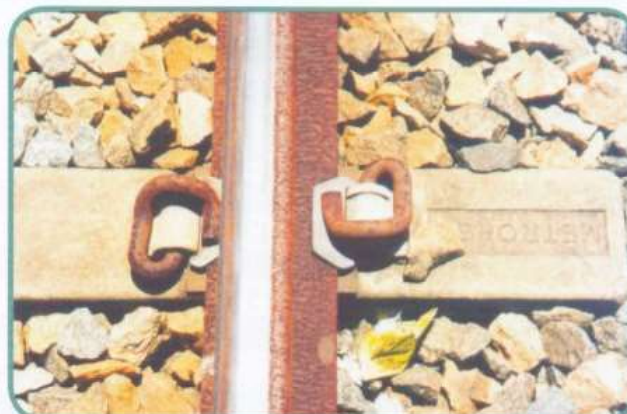
Fig 06 - Detalhe da parte superior dos dormentes
