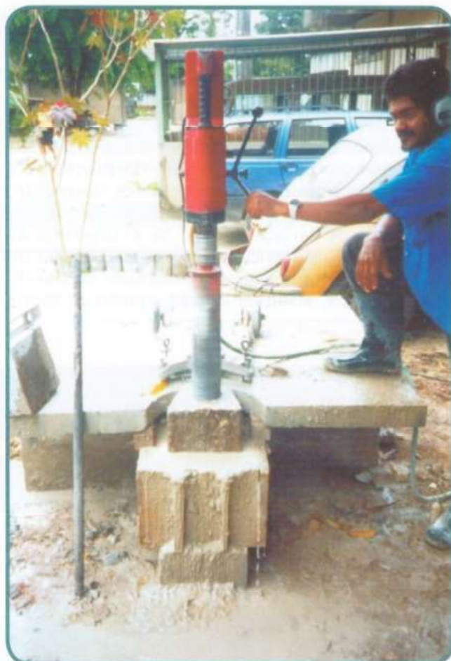
Figura 03 - Detalhe da extração dos testemunhos
