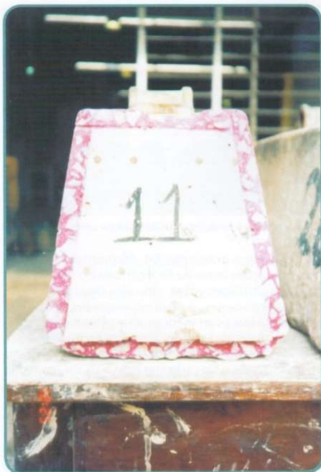
Fig. 10 - Cor vermelho carmim na superfície cortada do prisma A do dormente 11, indicando inexistência de carbonatação do concreto
