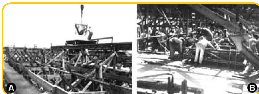
Figura 6 – Concretagem de uma embarcação construída durante a primeira guerra mundial (Eberhardt, 1995)
