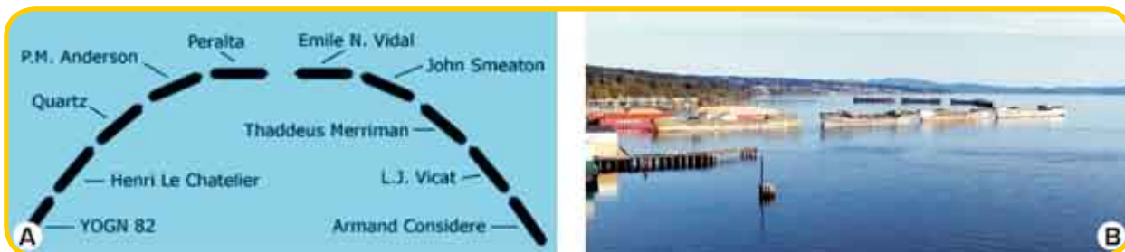
Figura 12. Corrente formada por navios de guerra como quebra mar em Powell River, Canadá. A fig. (a) ilustra a configuração dos navios pelos seus respectivos nomes.(www.concreteships.org)
