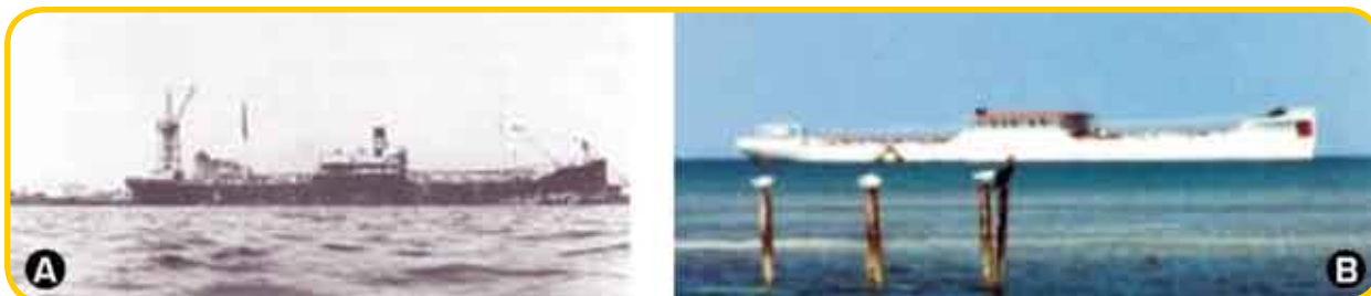
Figura 14 – Navios de concreto construídos na primeira guerra mundial: (a) navio SS Cuyamaca em San Diego, Julho 1920; (b) Navio SS San Pasqual, hoje um hotel em Cuba ( www.concreteships.org )
