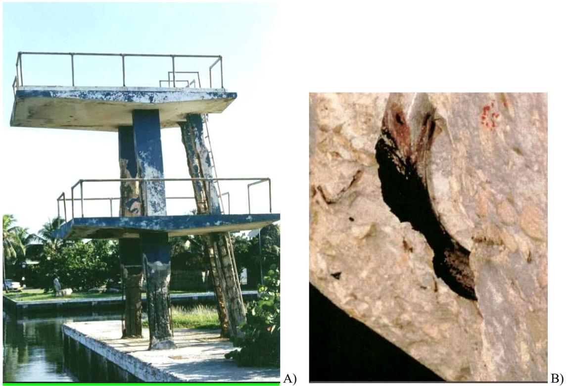
Figura 22. Fim da vida útil de serviço - Perda da capacidade resistente. A) Perda geral da capacidade resistente em pilares de obra litorânea (“Marina Hemingway” Havana, Cuba). B) Perda local da capacidade de carga de armadura de aço inoxidável<sup>47</sup> (Cais de Progreso, Yucatán, México. ARMINOX, 1999)
