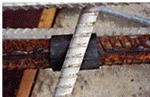
Separador plástico isolante entre barras de aço inoxidável e de aço carbono, armaduras de um mesmo componente estrutural. Pode se observar as barras de aço carbono prematuramente corroídas, possivelmente pela contaminação atmosférica sofrida antes da concretagem. (Foto da [www.stainless-rebar.org](http://www.stainless-rebar.org)).
