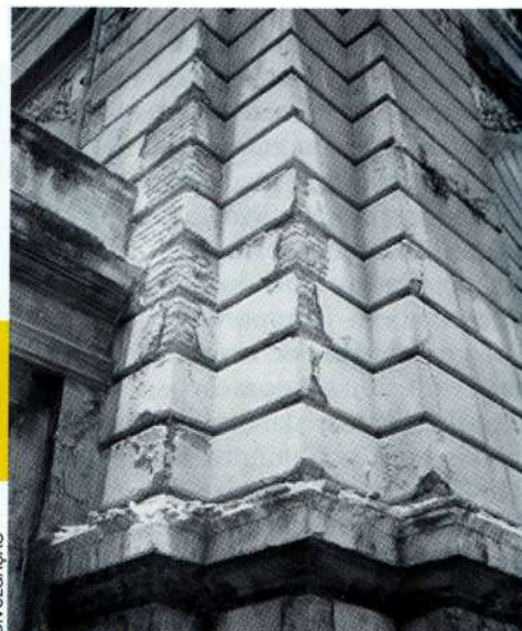
Foto 1 Vista parcial de zonas com descolamento do revestimento
