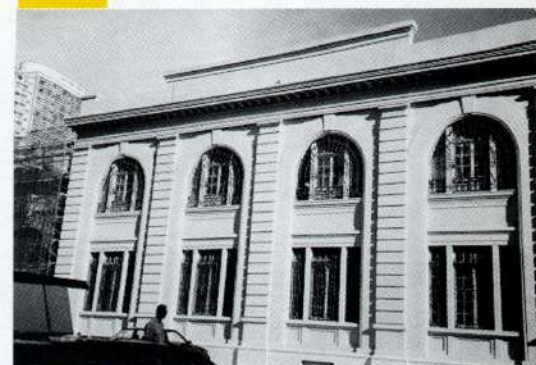
Foto 5 Vista parcial de uma fachada do prédio anexo, após conclusão dos serviços de recuperação
