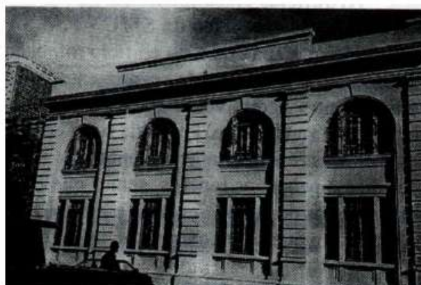
Foto 4-3 - Vista de uma fachada do prédio anexo, após a conclusão dos serviços.
