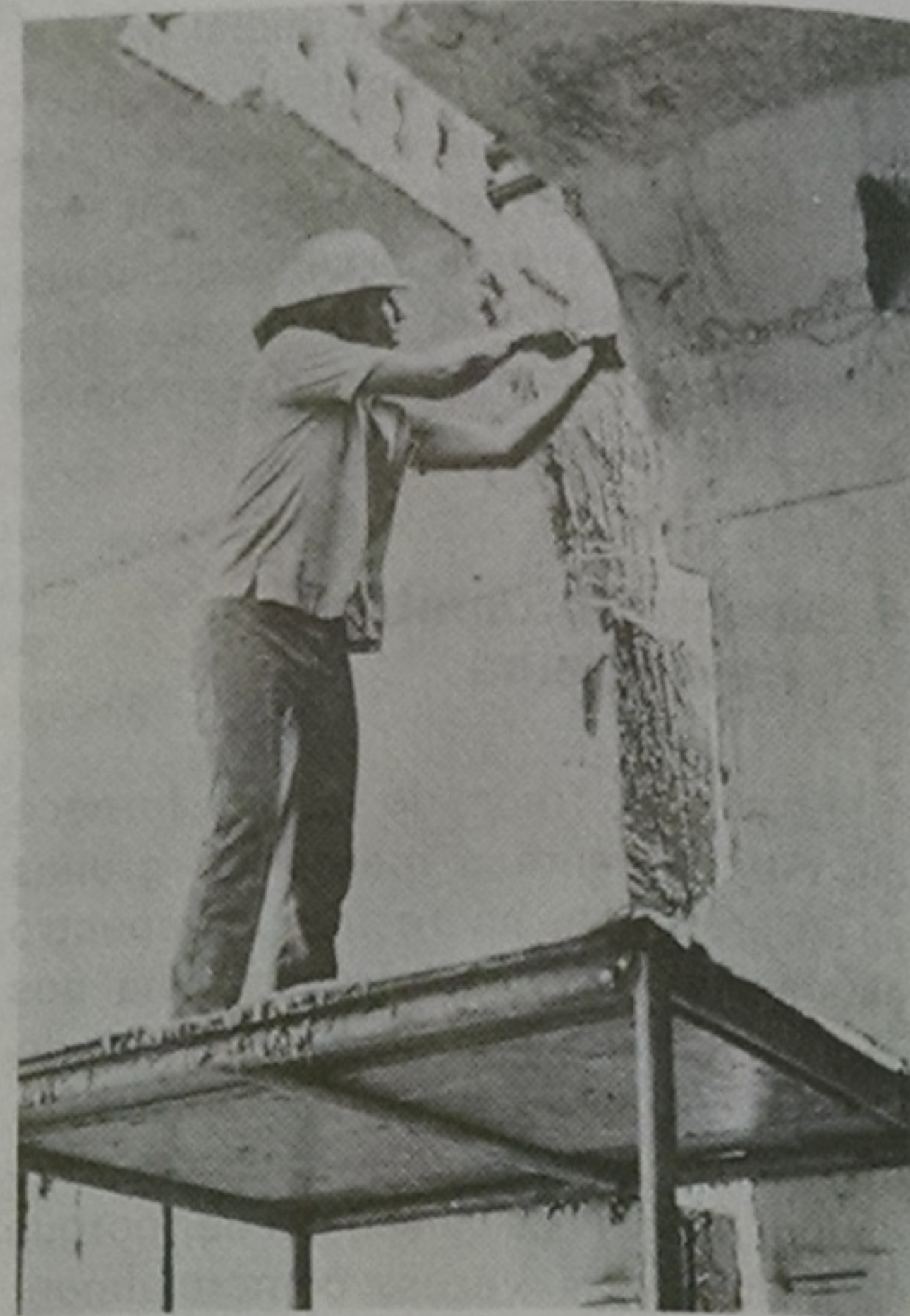
Foto 8 — Aplicação de adesivo epóxi para colagem de aduelas. Necessidade de ensaios de acompanhamento.
