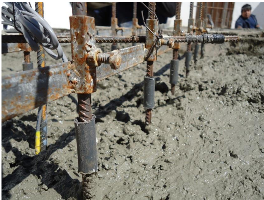
Figura 4.35 – Primeira camada de concreto colocada
