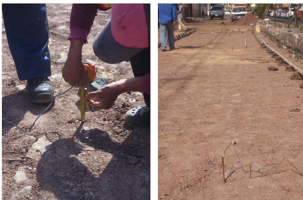
Figura 6.13 – Processo de colocação de sensores de medição da maturidade do concreto
