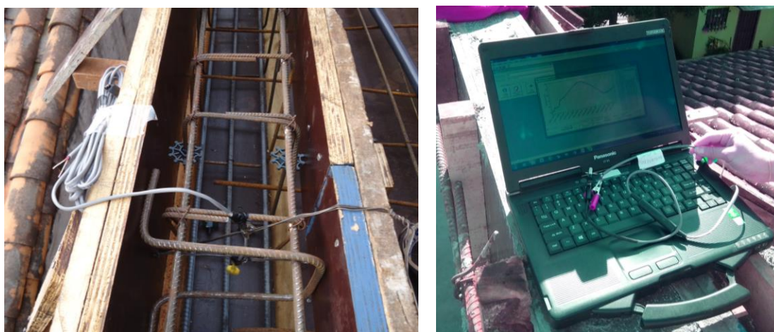
Figura 6.35 – Localização do sensor e medição da maturidade no primeiro dia
