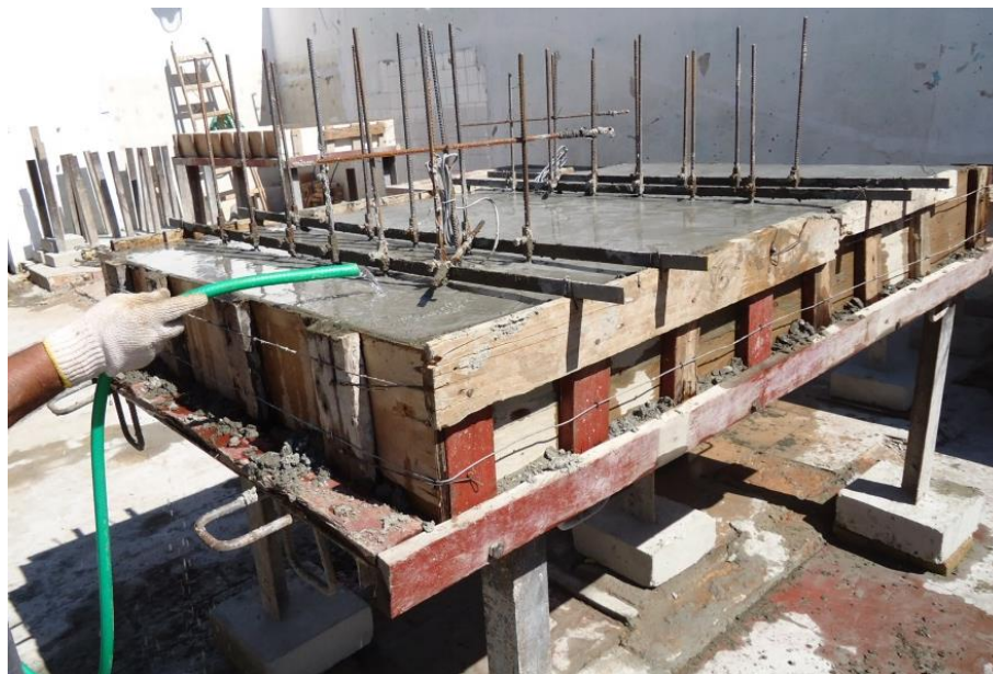
Figura 4.39 – Cura tipo CA por aspersão de água
