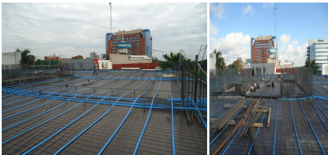
Figura 6.24 – Detalhes das cordoalhas na laje
