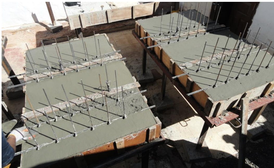
Figura 4.37 – Regularização da superfície dos painéis
