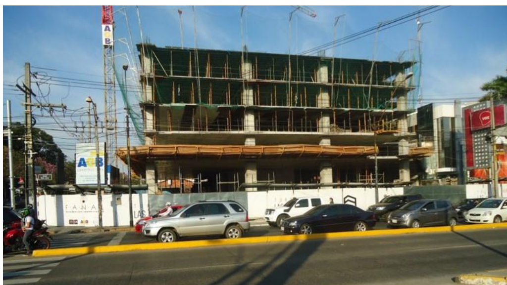
Figura 6.27 – Vista geral das diferenças no escoramento nos diferentes pavimentos
