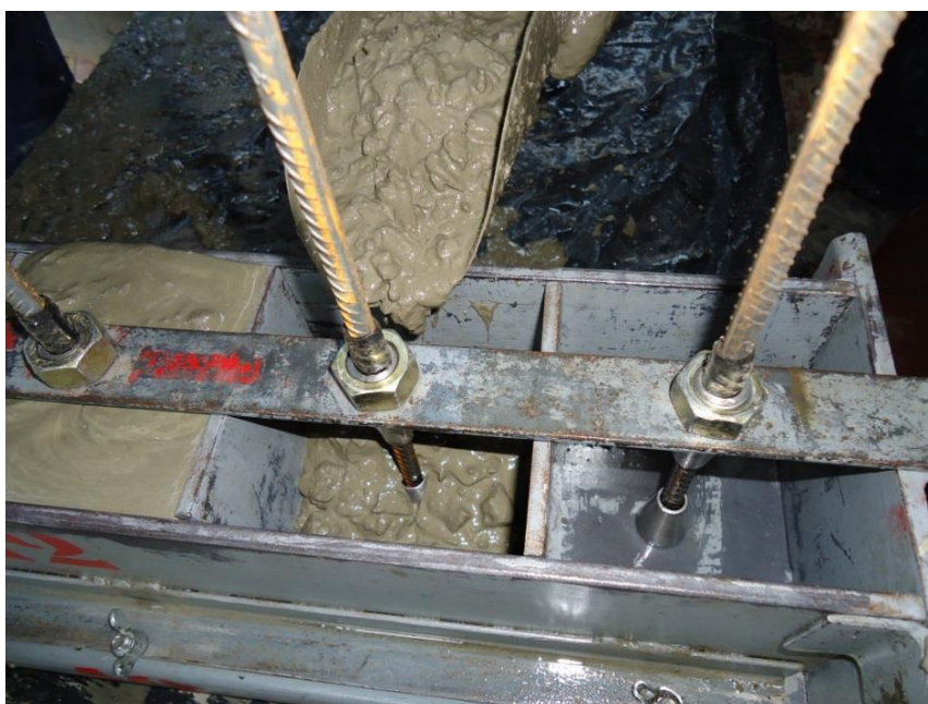
Figura 4.42 – Colocação do concreto em uma forma CAPULOT
