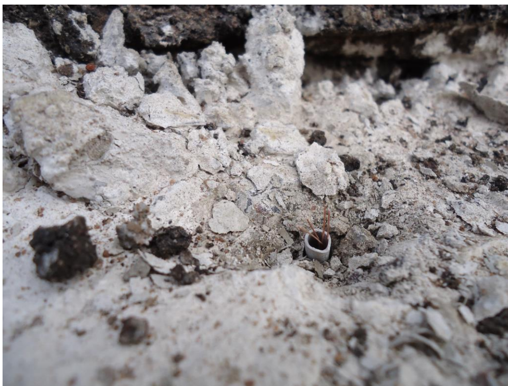
Figura 6.15 – Cabo quebrado pelo vandalismo
