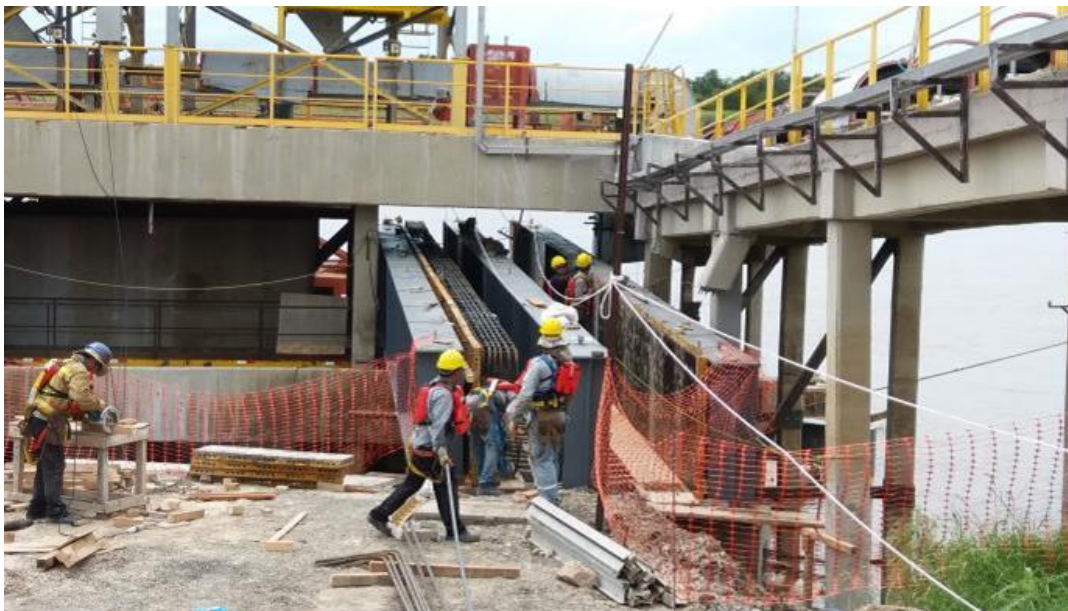
Figura 6.29 – Vista geral das vigas de reforço
