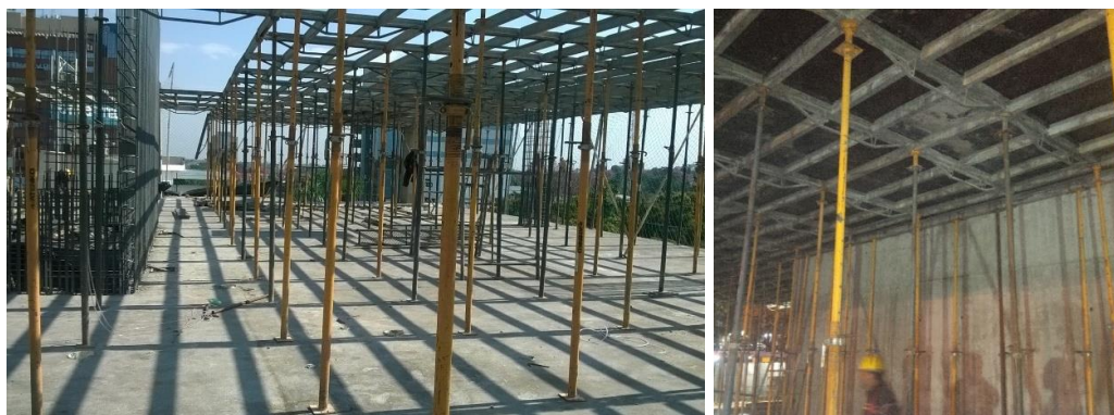
Figura 6.26 – Vista geral do escoramento
