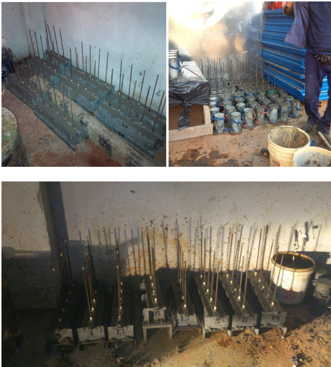
Figura 6.28 – Vista geral dos CAPULOT, CPs e medidores da maturidade do concreto
