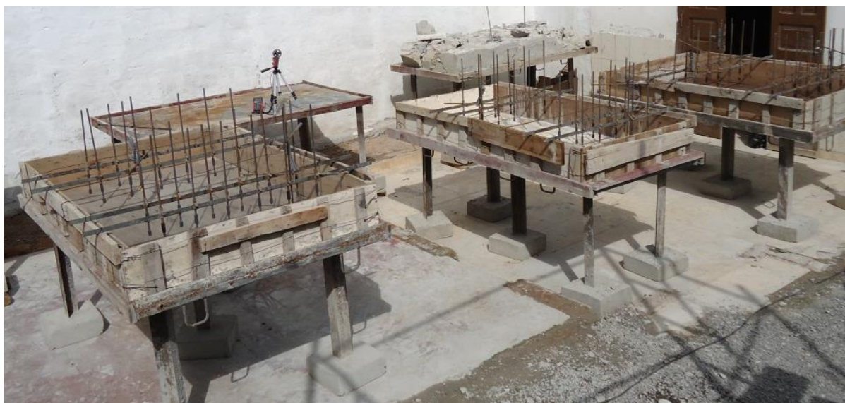
Figura 4.28 – Vista dos painéis prontos para a concretagem
