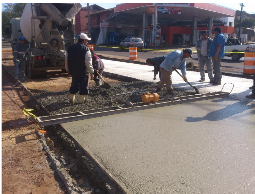
Figura 6.11 – Colocação e adensamento do concreto
