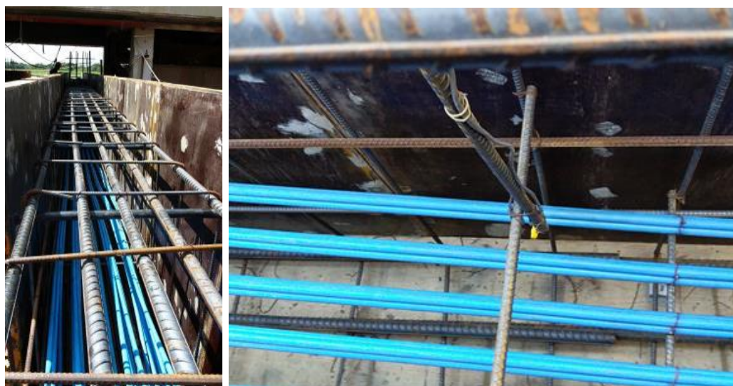
Figura 6.30 – Detalhe das vigas com cordoalhas e sensor de maturidade
