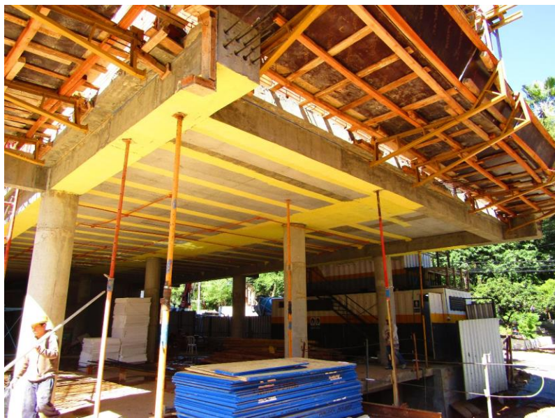
Figura 6.2 – Detalhes das vigas com cordoalhas
