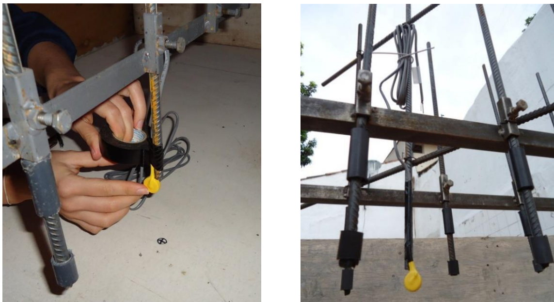
Figura 4.27 – Colocação sensores para medição da maturidade
