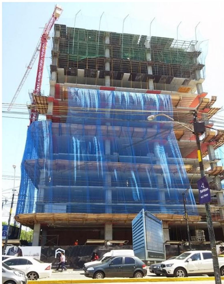
Figura 6.23 – Vista geral do prédio em construção
