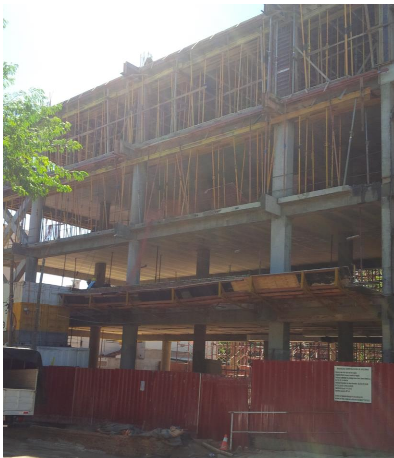
Figura 6.3 – Vista geral das diferenças no escoramento e cimbramento.
