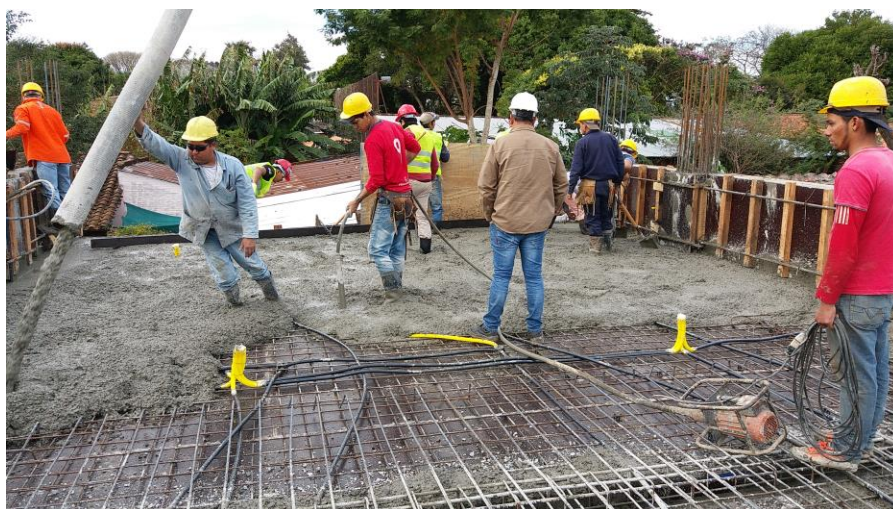
Figura 6.36 – Colocação e adensamento do concreto
