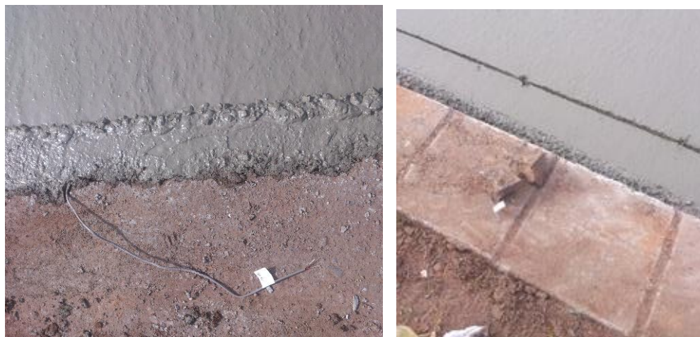
Figura 6.14 – Cabos dos sensores de maturidade
