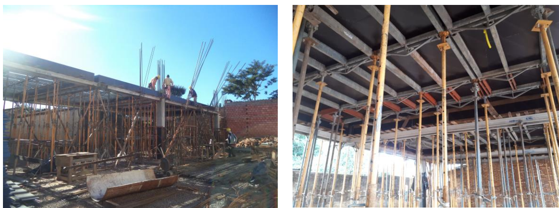
Figura 6.34 – Vista do cimbramento e escoramento
