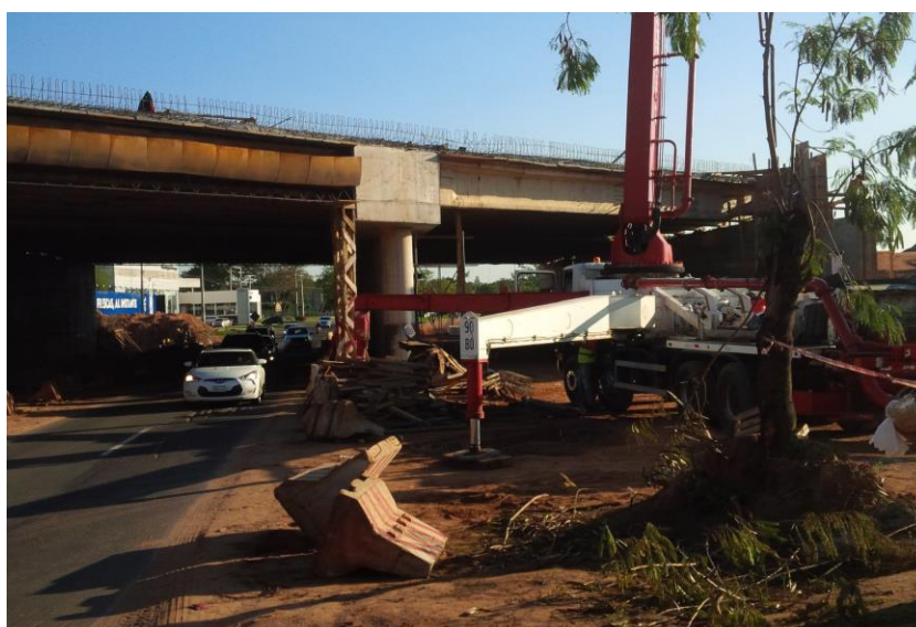
Figura 6.17 – Vista geral do viaduto
