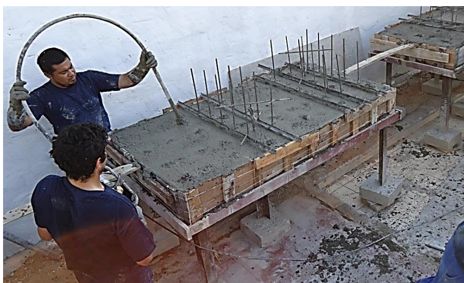
Figura 4.36 – Adensamento de segunda capa de concreto
