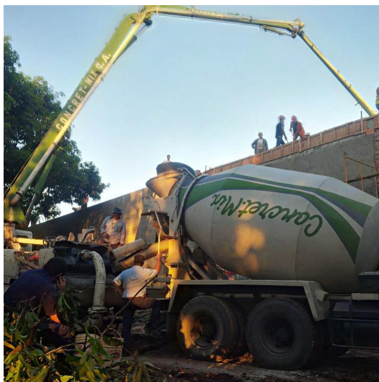
Figura 6.21 – Concretagem da estrutura
