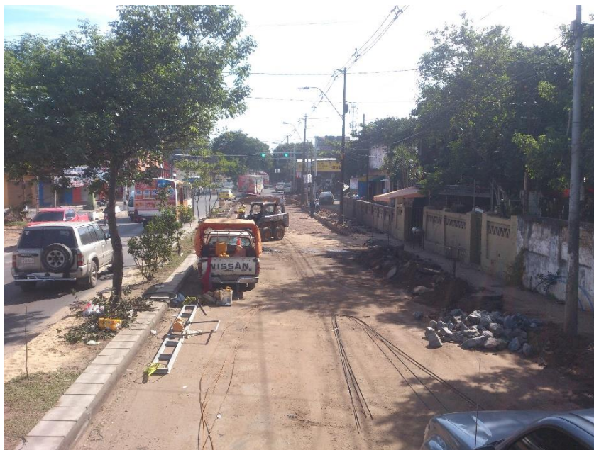
Figura 6.10 – Vista geral da avenida
