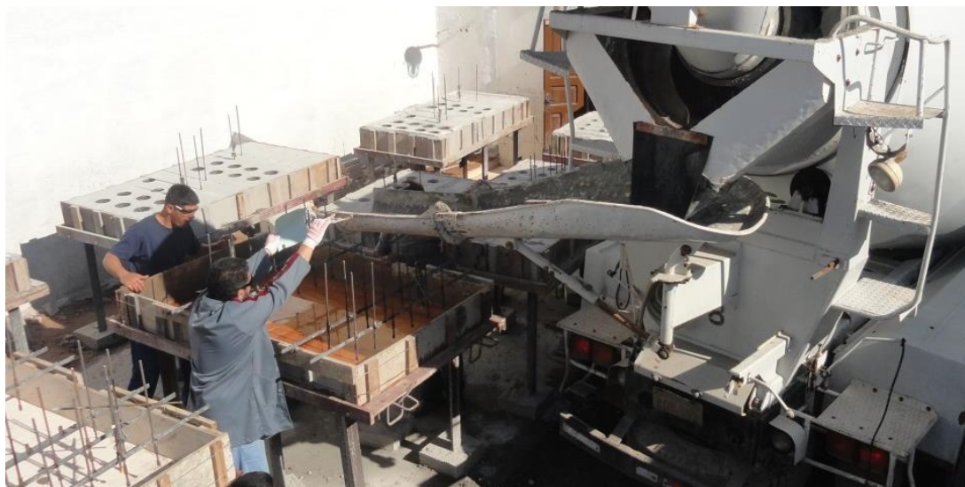
Figura 4.33 – Descarga do concreto em painéis
