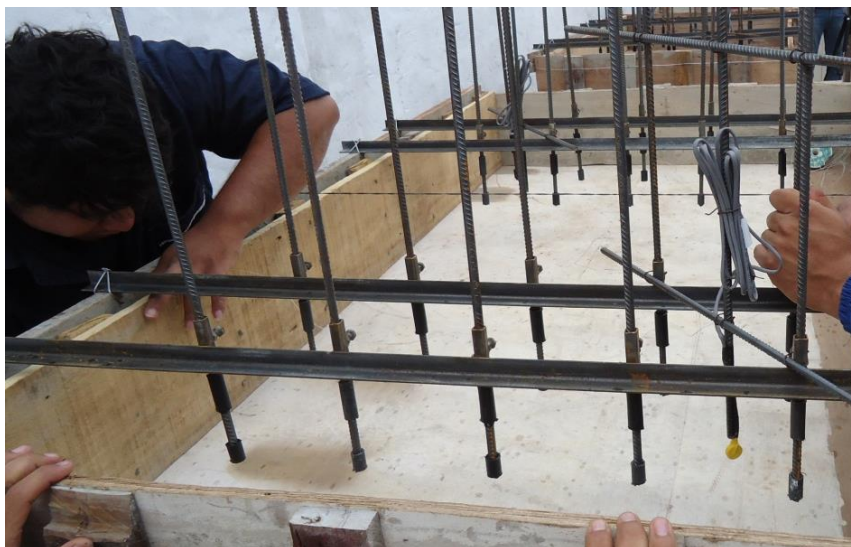
Figura 4.25 – Montagem da fôrma e colocação de suportes de barras de ensaio em painéis
