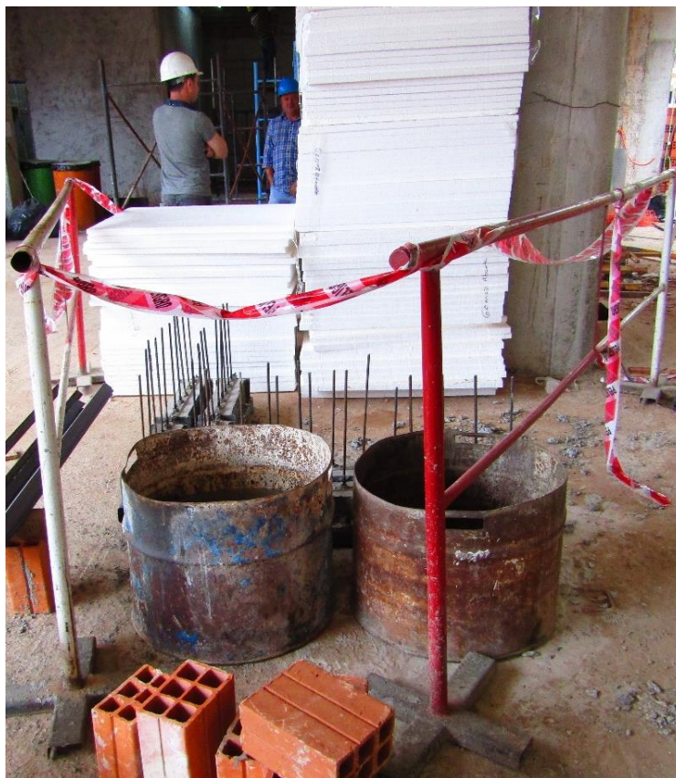
Figura 6.6 – Proteção dos CAPULOTs no prédio
