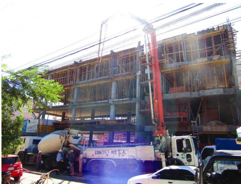
Figura 6.1 – Vista geral do prédio em construção
