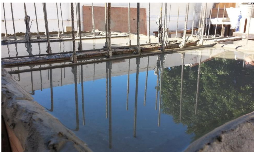
Figura 4.40 – Cura tipo CU por película de água permanente sobre o painel
