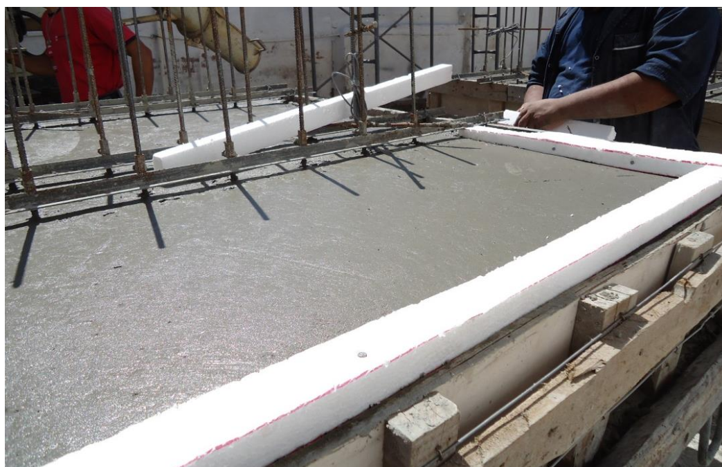
Figura 4.38 – Colocação de bordas de poliestireno expandido nos painéis para manter a água de cura
