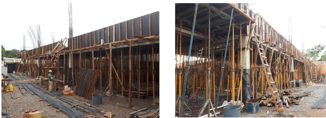
Figura 6.33 – Vista geral da estrutura em construção
