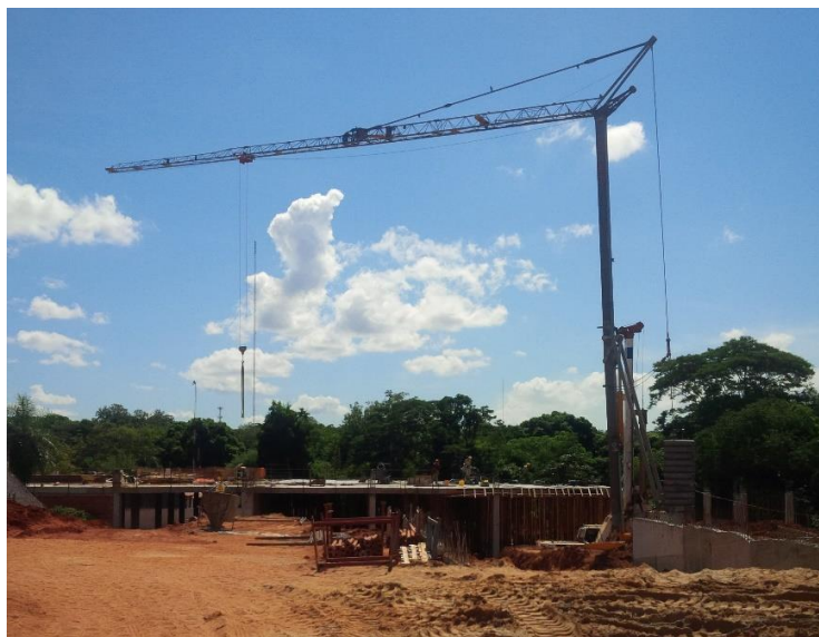
Figura 6.20 – Vista geral do canteiro
