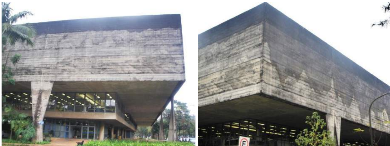
Figura 9. Detalhe da evolução do fluxo de água proveniente das chuvas pelas empenas do prédio da FAU USP.
