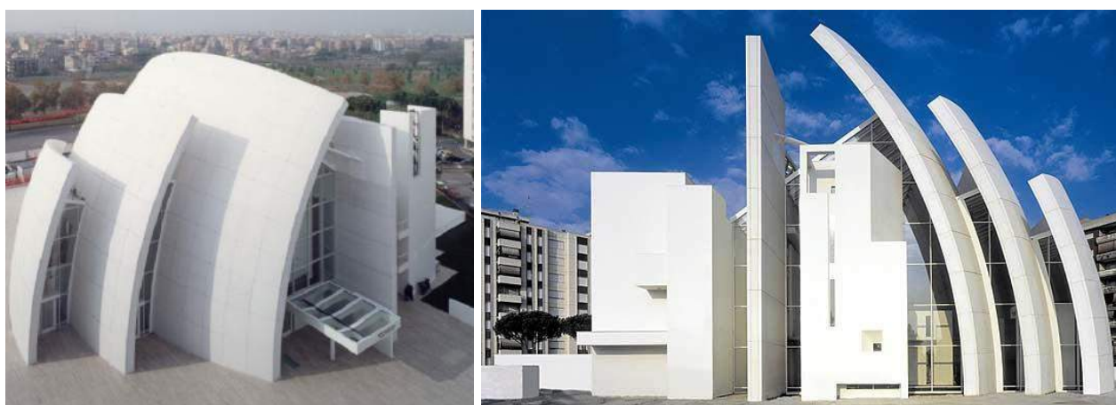
Figura 15. Igreja do Jubileu em Roma, construída em concreto branco autolimpante. (SERAPIÃO, 2004; BERNARDES, 2016)
