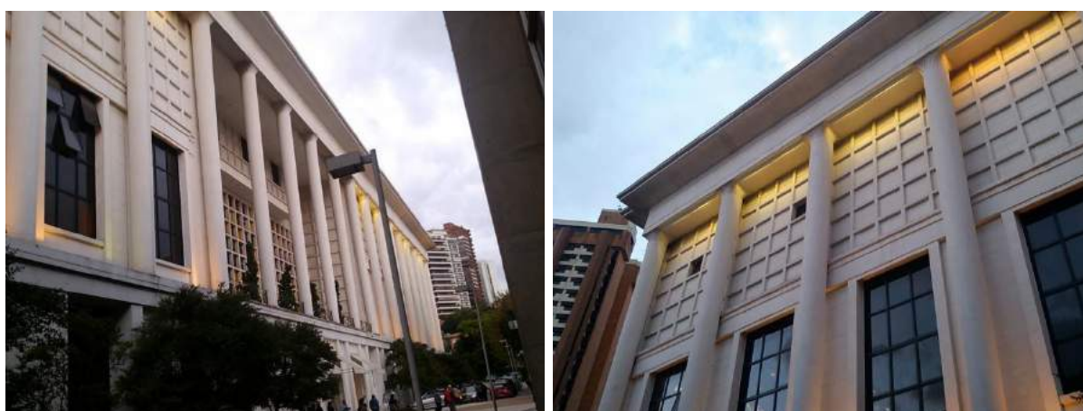
Figura 4. Detalhe do beiral prolongado adotado no prédio sede da FAAP, em São Paulo.
