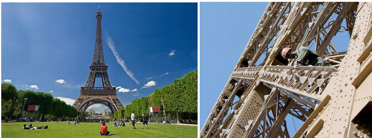
Figura 17. Vista da Torre Eiffel e detalhe do processo de pintura em execução (EUROPEAN TRIPS, 2017).
