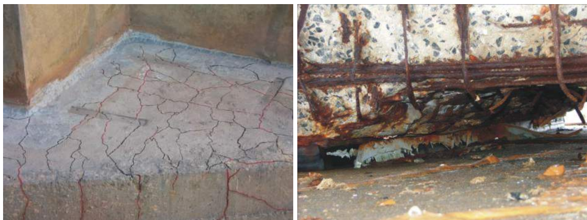
Figura 1. Exemplos de mecanismos de deterioração: reação álcali-agregado e corrosão por cloretos, respectivamente.
