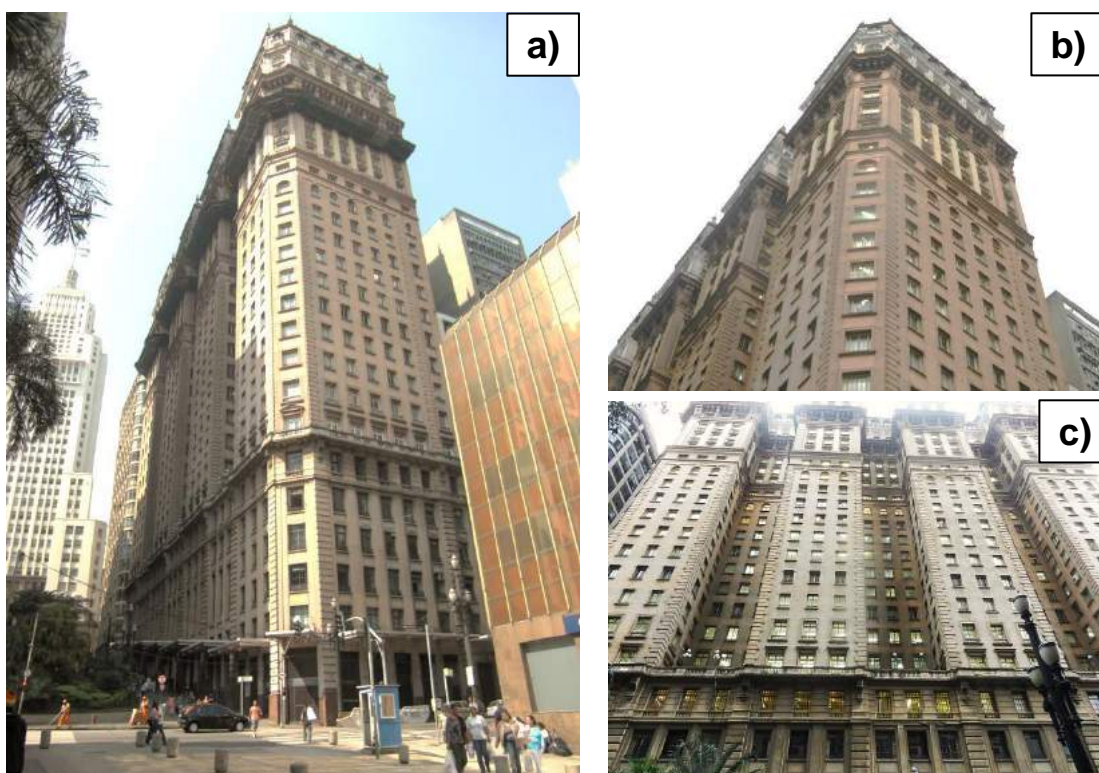
Figura 6. Edifício Martinelli: (a) vista da fachada na Av. São João; (b) detalhes arquitetônicos empregados; (c) após período chuvoso, não foram observados manchas de água na fachada (registro em abril/2017).
