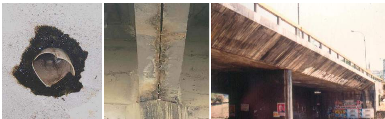
Figura 13. Exemplos de buzinote mal instalado e projetado; junta de dilatação não estanque; e manchas devido a ausência de pingadeiras em obras de arte especiais.
