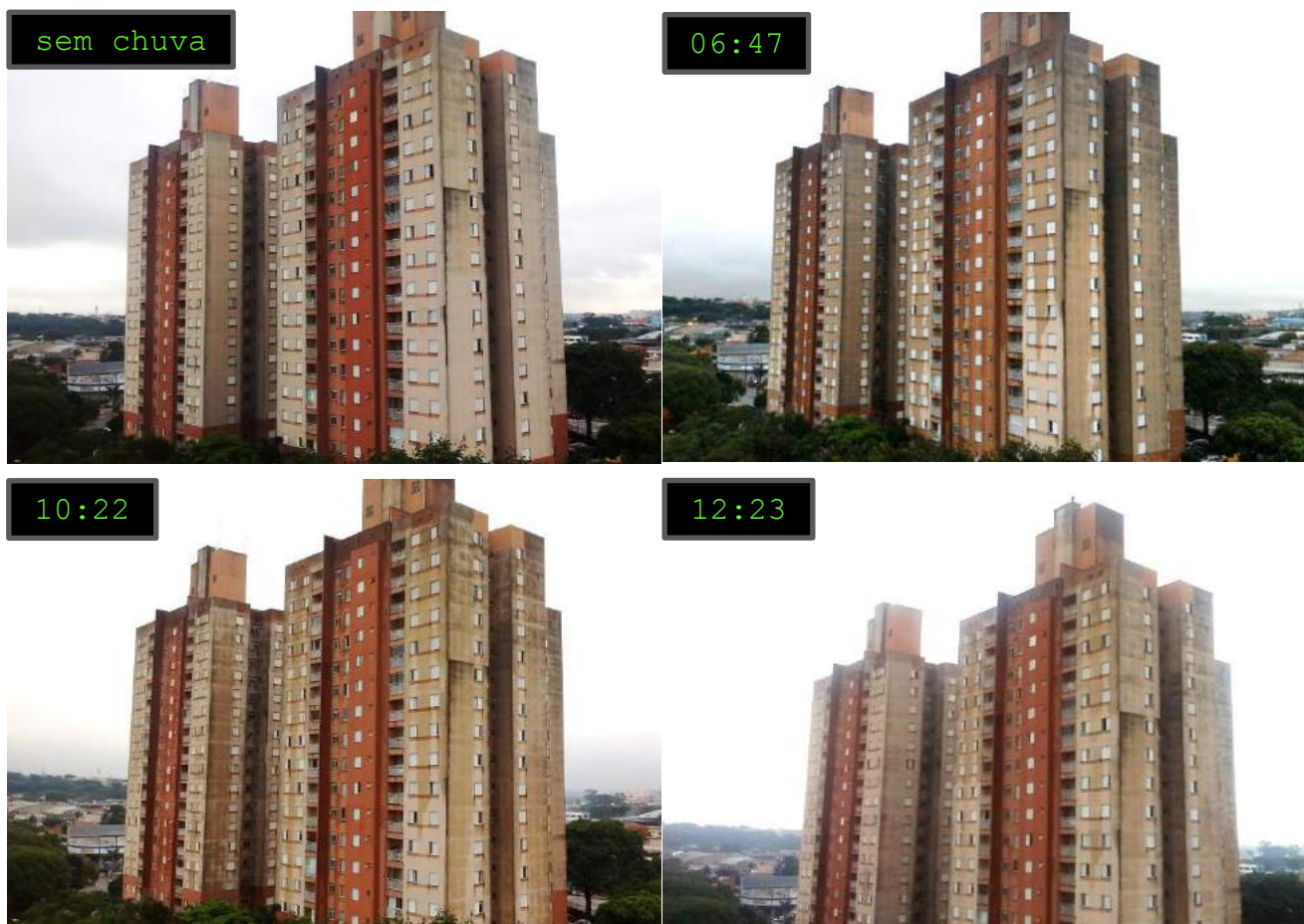
Figura 12. Manchas observadas nas fachadas das torres de um condomínio situado na Zona Norte da cidade de São Paulo.
