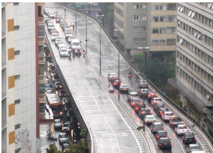
Figura 14. Exemplo de drenagem ineficiente: Elevado Costa e Silva com pontos de alagamento em 08/09/2009 (Créditos: Luciana Pinheiro Lino de Souza/VC no G1).
