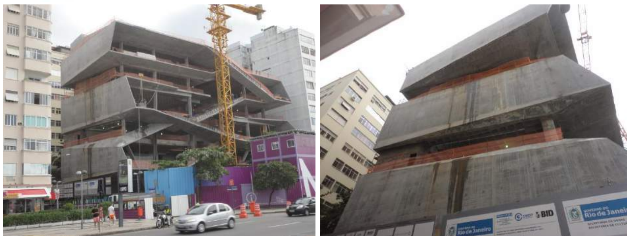
Figura 11. Detalhe dos fluxos de água observados nas empenas da fachada da nova sede do MIS RJ, após período chuvoso (registro de 20/06/2014).
