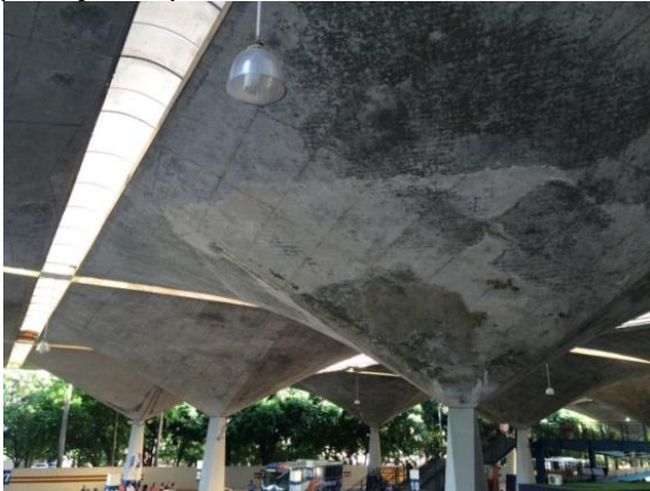
Fotografia 1 – Concreto aparente sem proteção superficial
