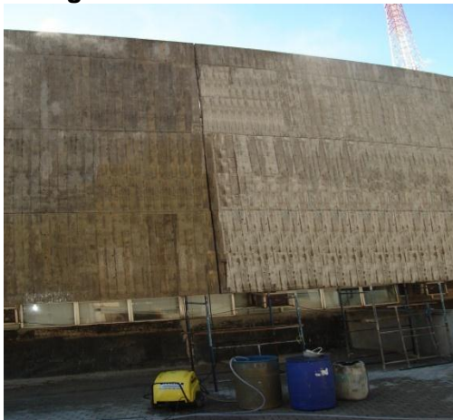
Fotografia 13 – Concreto sem tratamento
