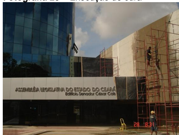
Fotografia 23 – Execução de cura
