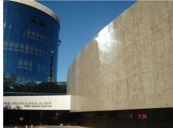
Fotografia 2 – Concreto aparente com proteção superficial
