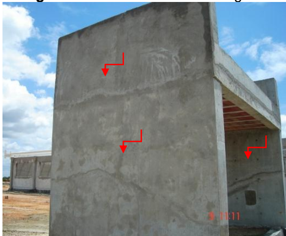
Fotografia 18 – Juntas de concretagem
