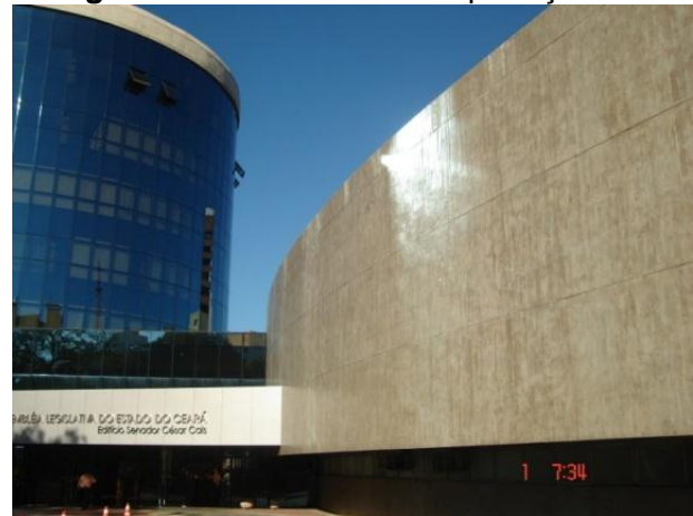
Fotografia 14 – Concreto com proteção
