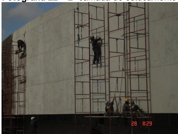
Fotografia 22 – 2ª camada de estucamento
