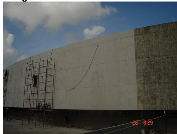
Fotografia 21 – 1ª camada de estucamento
