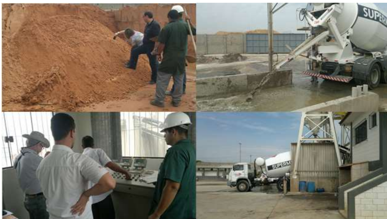
Foto 6 a 9. Controle realizado na usina para dosagem do caminhão protótipo.
