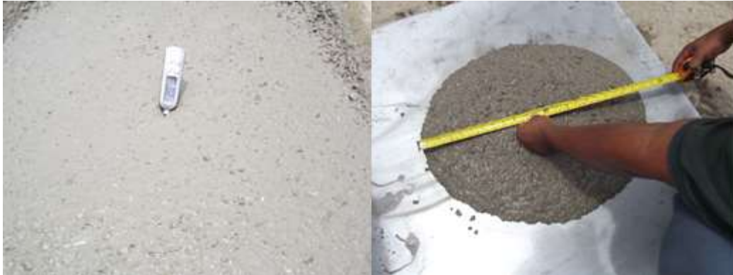
Fotos 14 e15. Controle de recebimento do concreto, temperatura e espalhamento.
