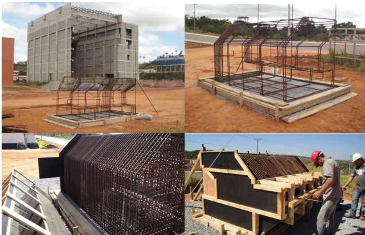
Fotos 2 a 5. Sequencia de montagem das armaduras e formas do “EES”
