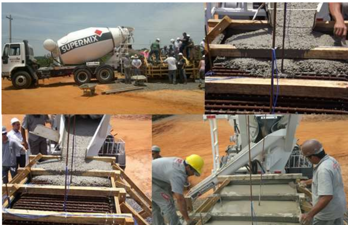
Foto 17 a 20. Aspectos da concretagem do “EES”.
