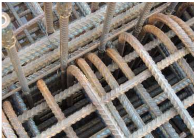
Foto 1. Aspectos da armadura do bloco de fundação
