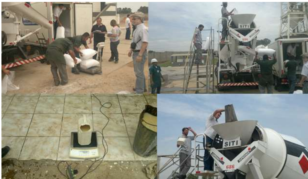
Foto 10 a 13. Controle realizado na usina para dosagem do caminhão protótipo, gelo e aditivos.
