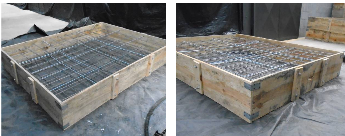
Figura 30 - Detalhe da fôrma da placa de concreto
