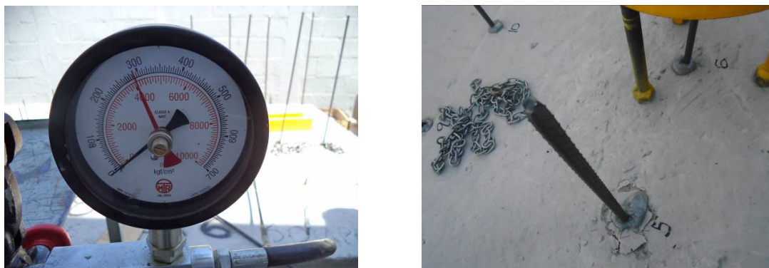
Figura 78 - Detalhe da marcação do manômetro de precisão após a ruptura do vergalhão
