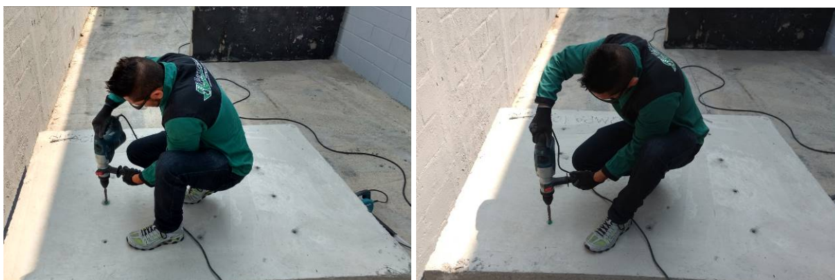
Figura 38 - Procedimento de furação das placas dispostas na direção horizontal
