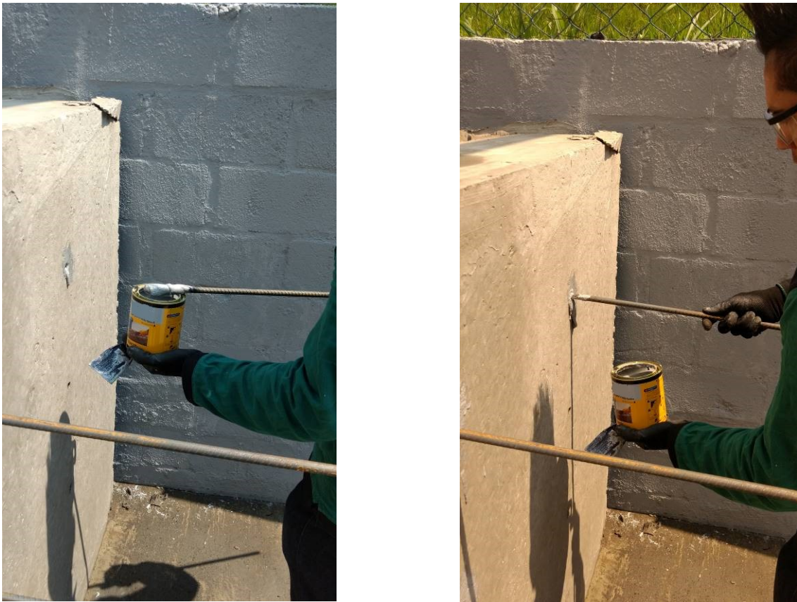
Figura 72 - Detalhe da colocação do vergalhão dentro da lata do produto B para retirada do material e posterior inserção no furo Fonte: Autor
