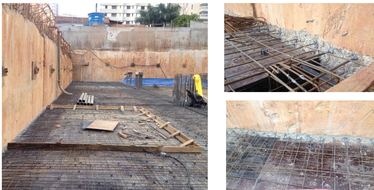
Figura 26 - Detalhe da utilização de chumbador químico de injeção em parede diafragma Fonte: Acervo Âncora (2015)
