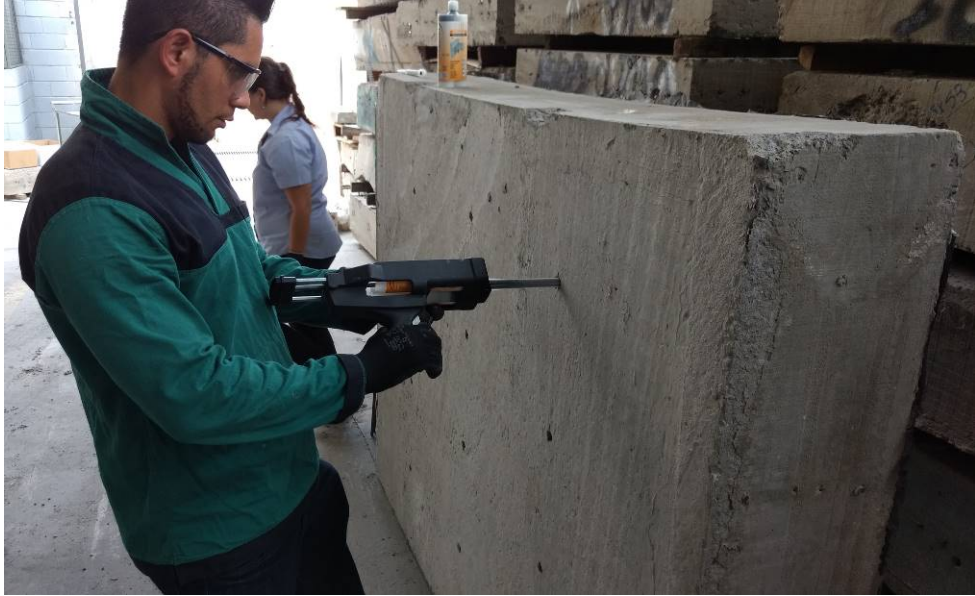
Figura 57 - Detalhe da aplicação do produto A Fonte: Autor
