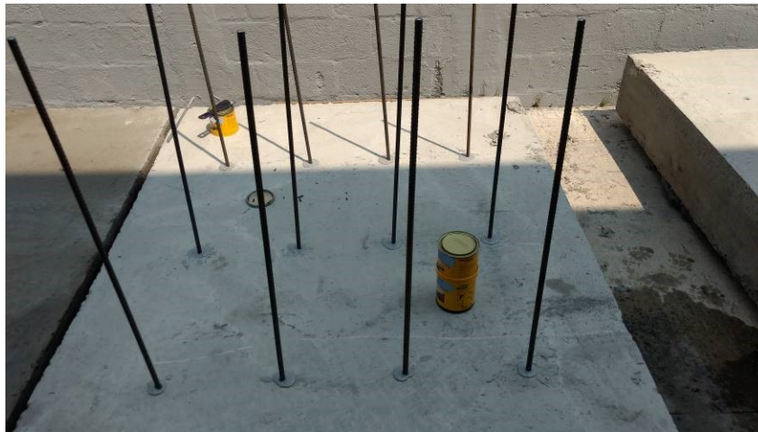
Figura 68 - Conclusão da instalação dos vergalhões em substrato seco Fonte: Autor
