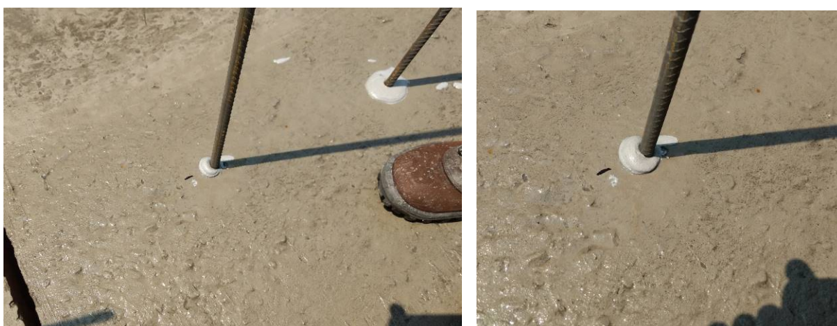
Figura 70 - Detalhe da instalação dos vergalhões em substrato úmido Fonte: Autor
