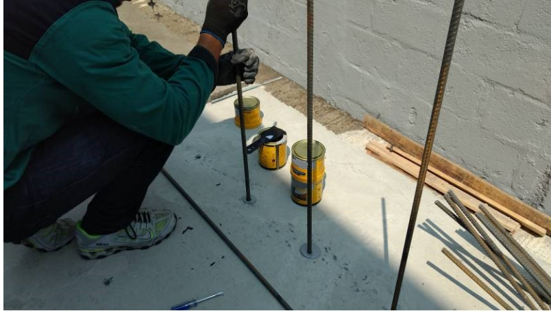
Figura 67 - Detalhe da instalação do vergalhão no sentido de rotação Fonte: Autor
