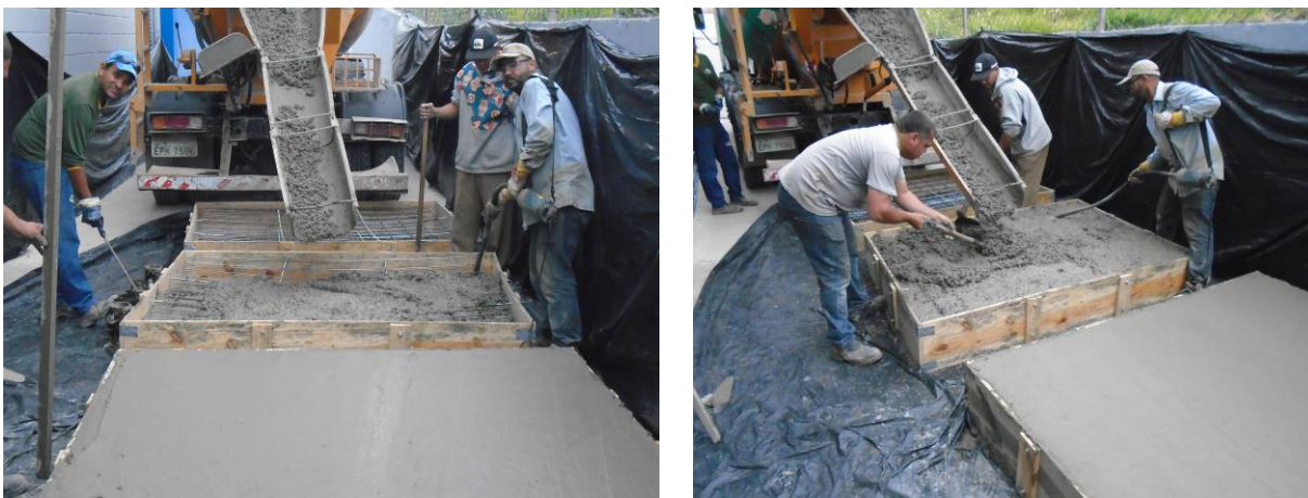
Figura 35 - Detalhe da sequência de concretagem das formas
