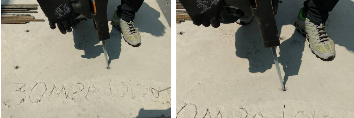
Figura 51 - Detalhe a aplicação do chumbado químico de injeção Fonte: Autor
