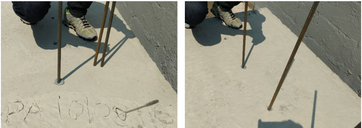
Figura 52 - Sequência de aplicação de vergalhões Fonte: Autor
