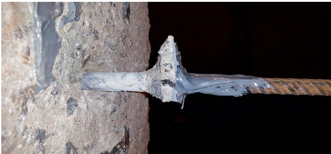
Figura 7 - Detalhe da falha por escorregamento Fonte: Acervo Âncora (2016)
