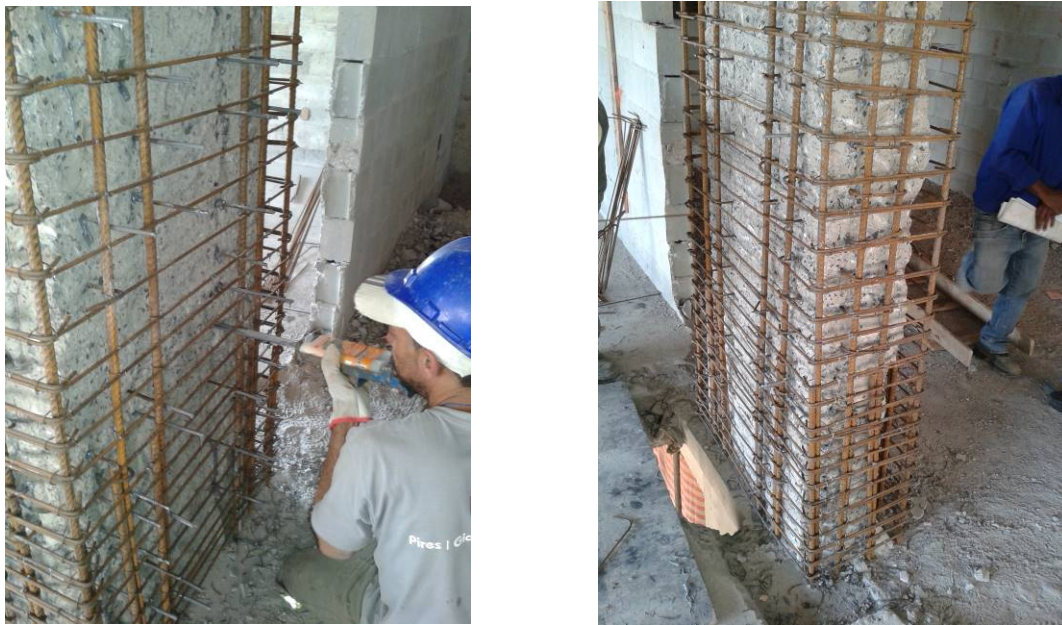
Figura 25 - Detalhe da utilização de chumbador químico de injeção em reforço estrutural Fonte: Acervo Âncora (2015)
