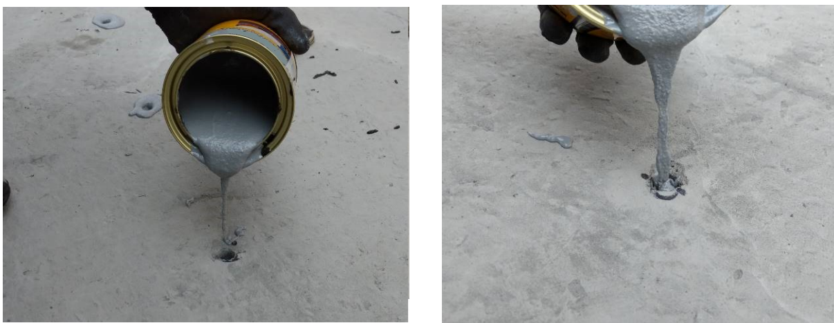
Figura 66 - Detalhe da aplicação do produto B
