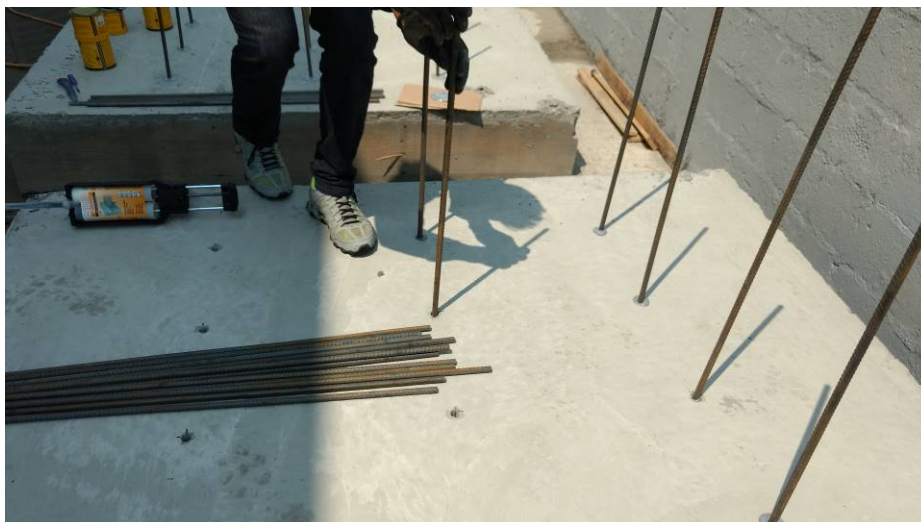
Figura 53 - Procedimento de colocação do vergalhão com movimentos de rotação Fonte: Autor
