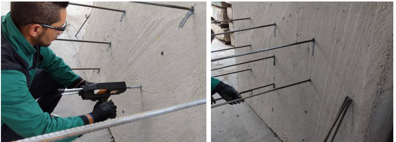
Figura 58 - Detalhe da aplicação dos vergalhões no substrato disposto na posição vertical Fonte: Autor
