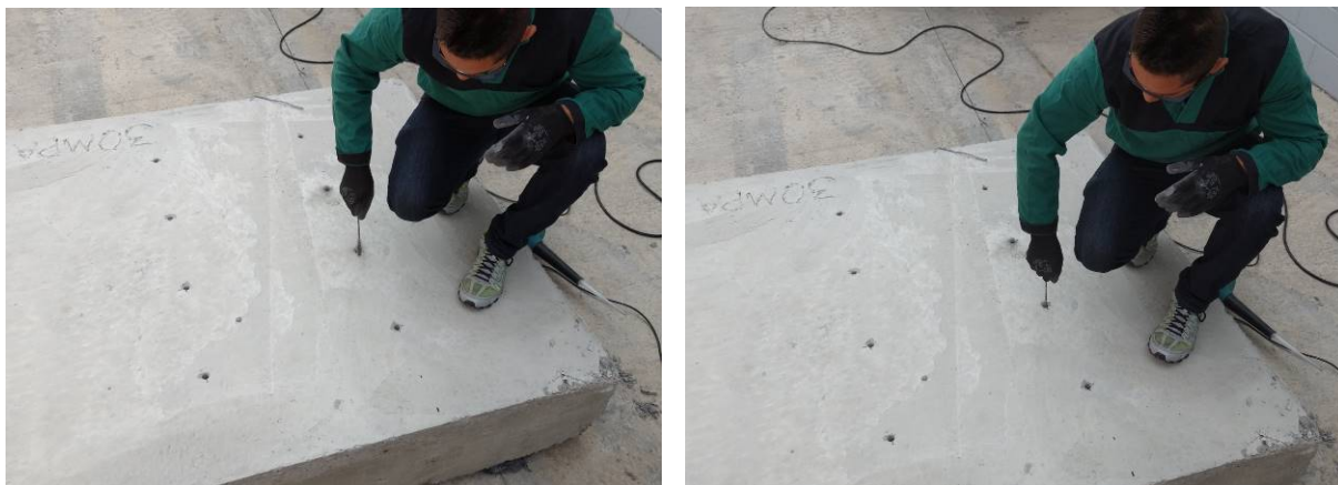
Figura 45 - Detalhe da realização de limpeza com o auxílio de uma escova Fonte: Autor
