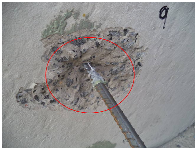
Figura 96 - Detalhe da ausência de produto sobre o vergalhão Fonte: Autor
