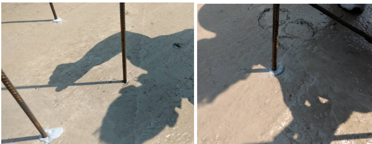
Figura 56 - Detalhe da sequência de aplicação dos vergalhões
