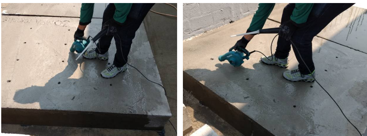
Figura 48 - Detalhe da retirada do excesso de água
