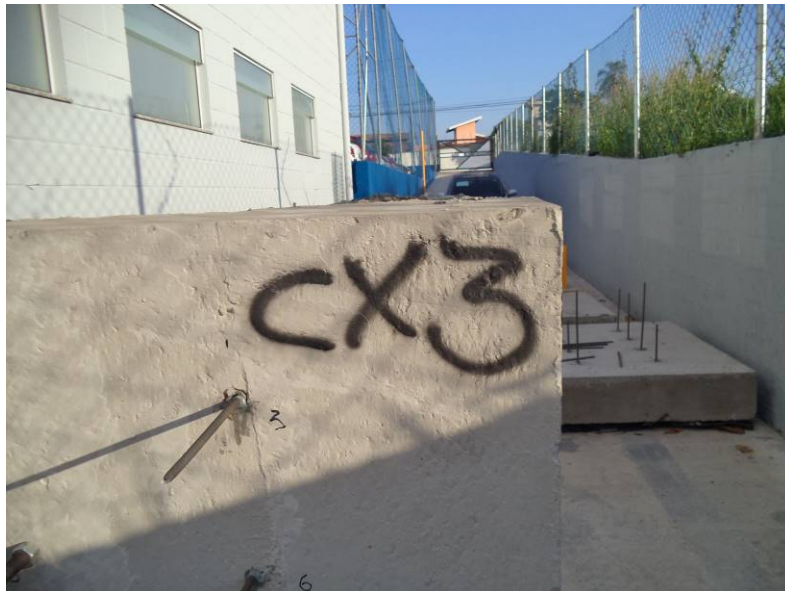
Figura 84 - Detalhe da ruptura do aço Fonte: Autor
