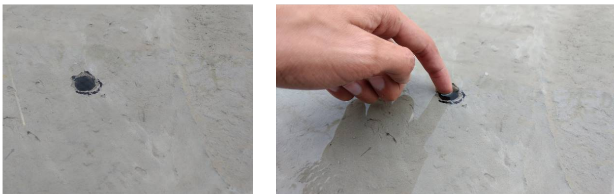
Figura 43 - Detalhe da presença de água no furo
