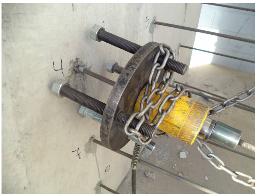
Figura 90 - Detalhe da falha por escorregamento depois de aplicada a carga de tração Fonte: Autor
