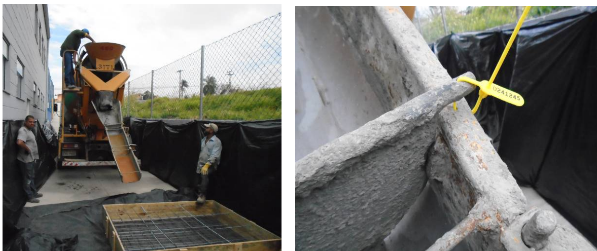
Figura 32 - Detalhe da chegada do caminhão betoneira e remoção do lacre de segurança Fonte: Autor
