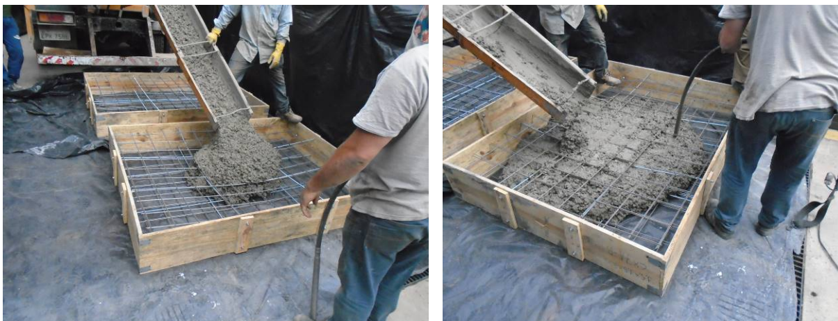
Figura 34 - Detalhe do posicionamento das formas para concretagem
