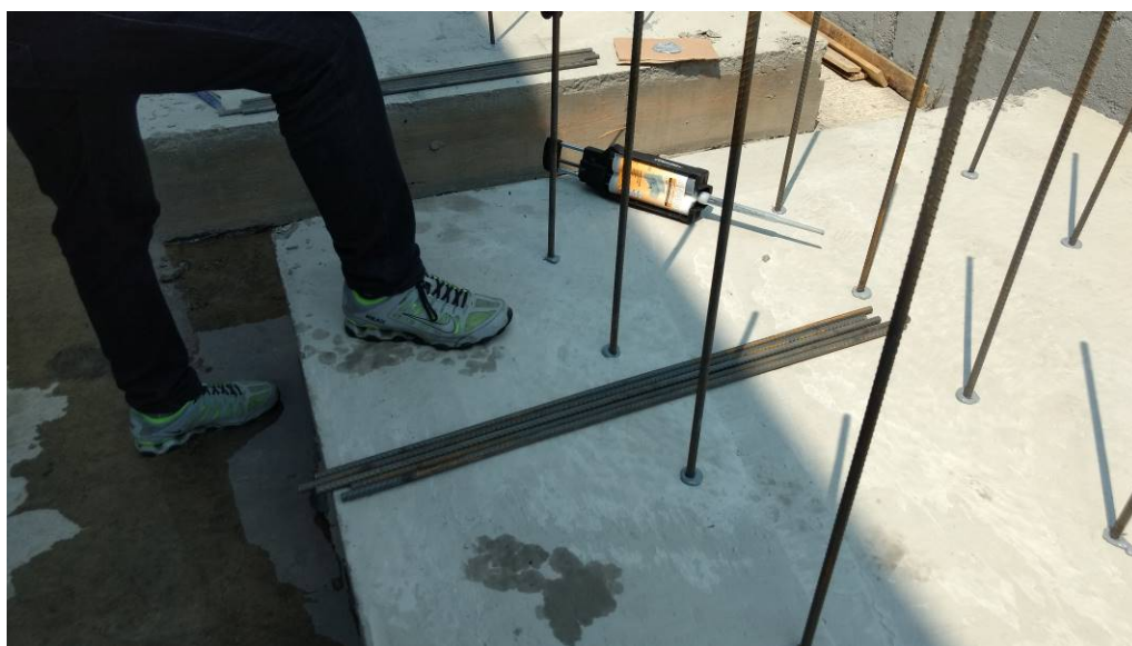
Figura 54 - Finalização das aplicações no substrato seco disposto na posição horizontal Fonte: Autor
