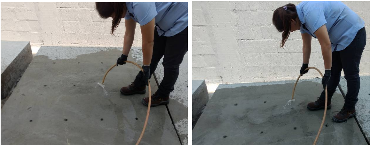
Figura 40 - Detalhe da saturação das placas dispostas na horizontal
