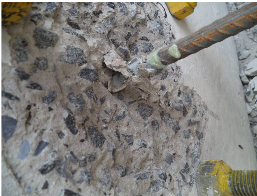
Figura 93 - Detalhe da ruptura parcial em cone de concreto combinado com a falha por escorregamento
