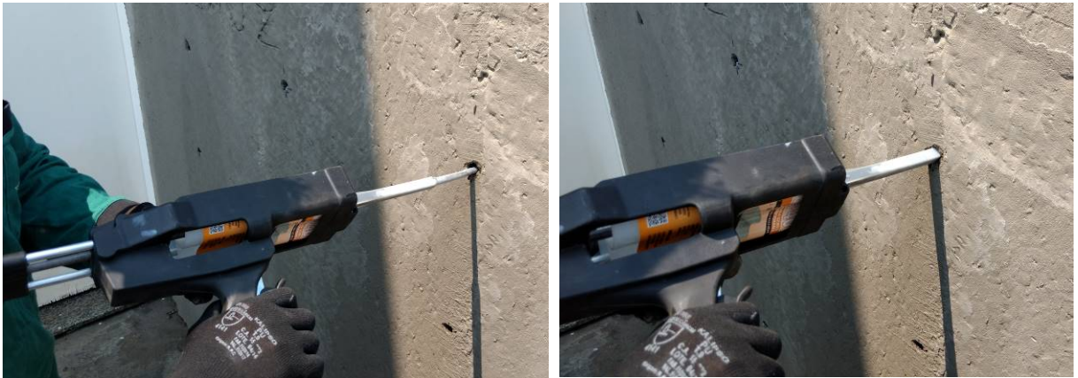
Figura 60 - Detalhe da aplicação do produto A em substrato úmido
