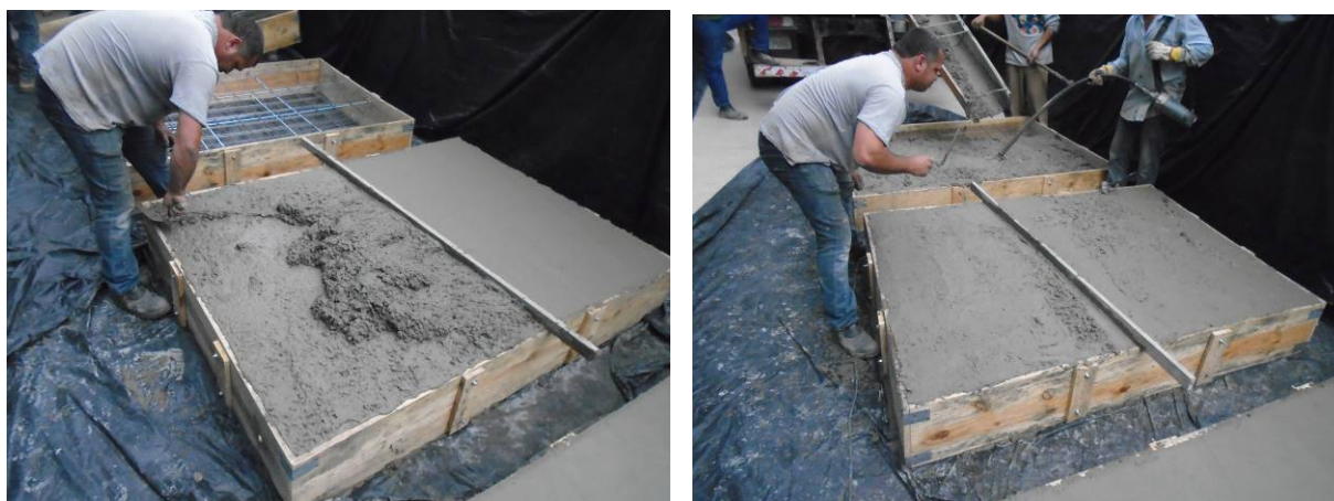
Figura 36 - Detalhe do acabamento realizado nas placas de concreto Fonte: Autor
