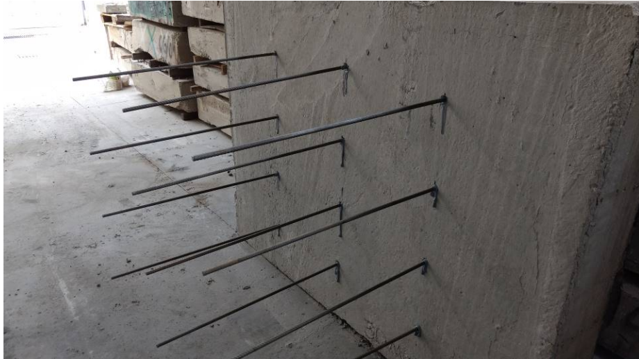
Figura 59 - Conclusão da instalação dos vergalhões
