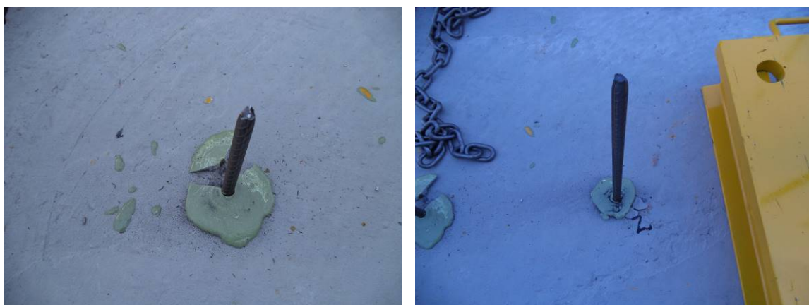
Figura 86 - Detalhe da ruptura do aço após realização do ensaio Fonte: Autor
