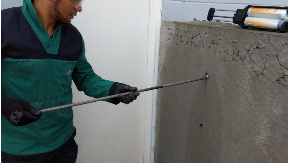
Figura 61 - Detalhe a instalação do vergalhão com movimentos de rotação Fonte: Autor
