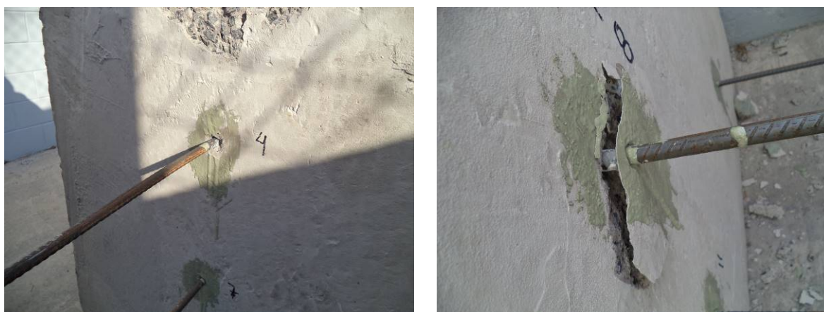
Figura 92 - Detalhe das ocorrências encontradas no ensaio em substrato úmido disposto na posição vertical
