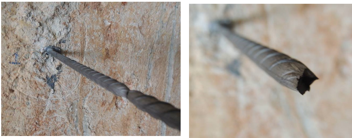
Figura 9 - Detalhe da falha do aço do chumbador Fonte: Acervo Âncora (2016)
