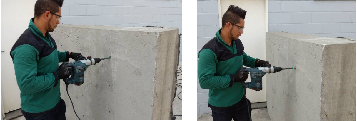
Figura 39 - Procedimento de furação das placas dispostas na horizontal
