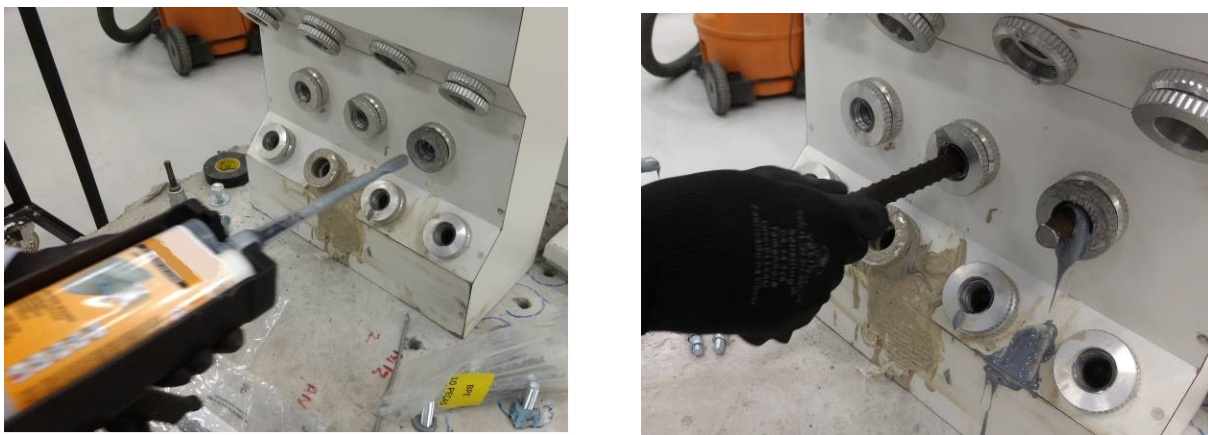
Figura 103 - Detalhe da aplicação do produto A Fonte: Autor
