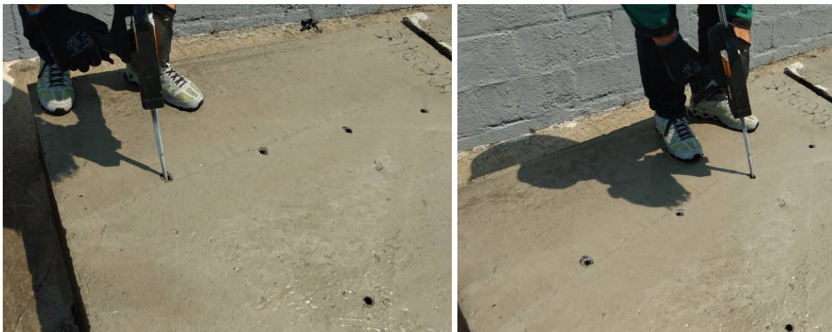
Figura 55 - Detalhe a aplicação do produto A em substrato úmido
