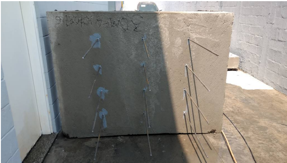
Figura 62 - Conclusão da instalação dos vergalhões em substrato úmido Fonte: Autor
