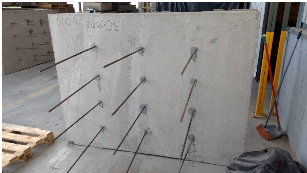
Figura 74 - Conclusão da instalação dos vergalhões em substrato seco Fonte: Autor
