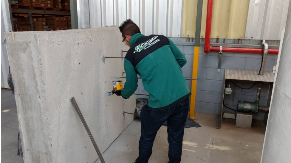
Figura 73 - Detalhe da aplicação do produto B em substrato seco Fonte: Autor
