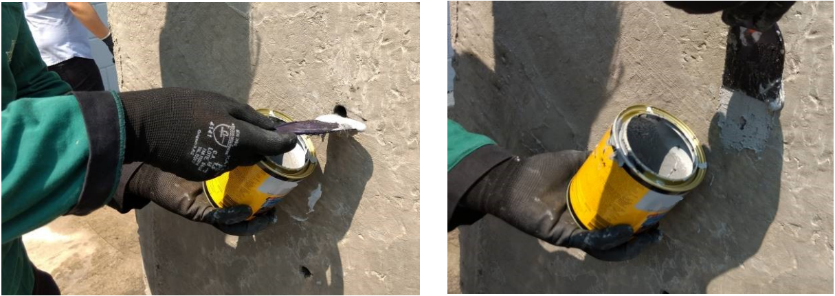
Figura 71 - Detalhe da utilização da espátula para colocar uma parte do produto na face do furo Fonte: Autor
