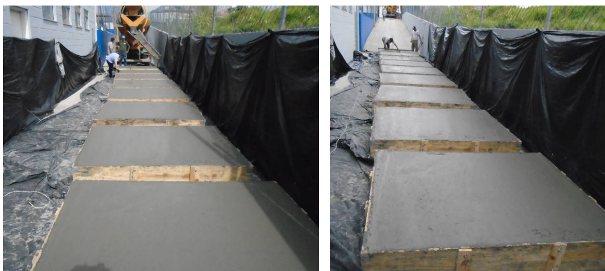
Figura 37 - Detalhe das placas de concreto finalizadas Fonte: Autor
