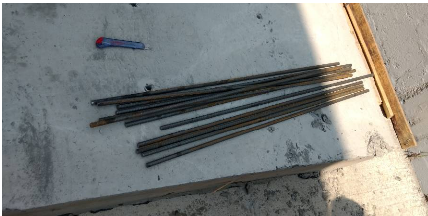
Figura 49 - Detalhe dos vergalhões utilizados
