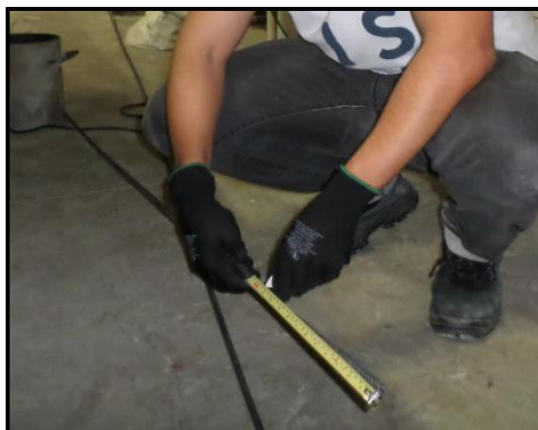
Figura 22-Marcação das barras de aço para realização do corte.
