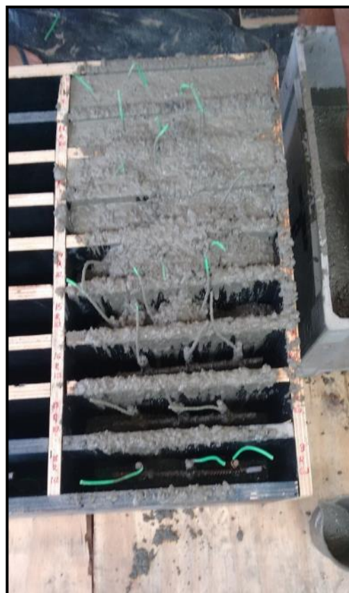
Figura 61-Outra vista da concretagem.
