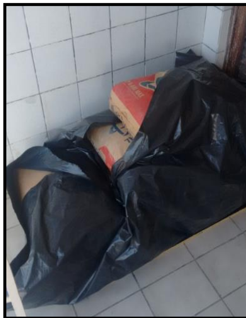
Figura 40-Armazenamento do cimento.
