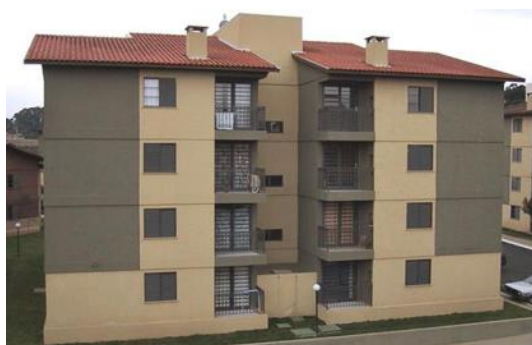
Figura 8-Curitiba –PR. Conjunto habitacional 480 unidades de apartamento.
