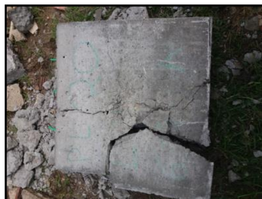
Figura 102- Forma como as placas foram quebradas
