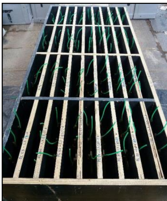
Figura 53-Vista da fôrma com as armaduras dentro.
