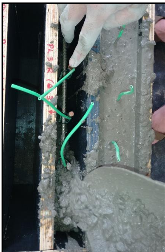
Figura 62-Detalhe da colocação do concreto na fôrma.
