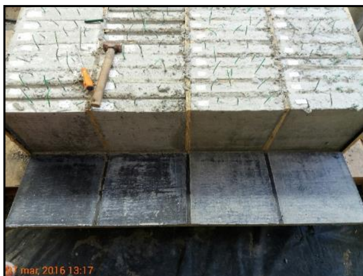
Figura 67- Outra visão da retirada das fôrmas.
