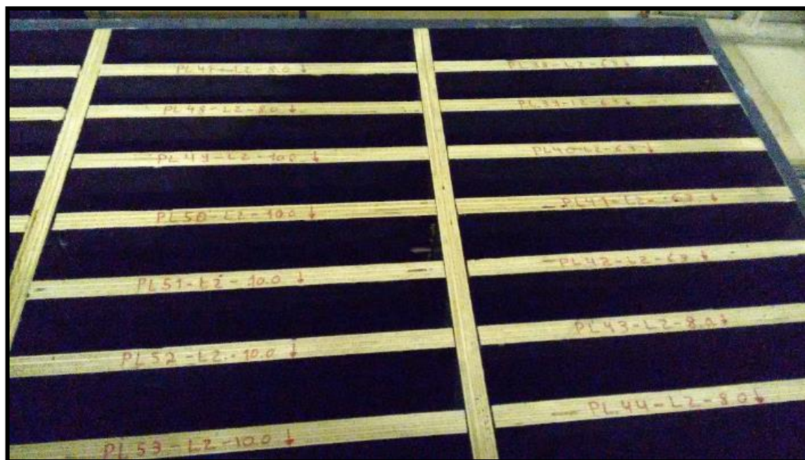
Figura 38- Detalhe das fôrmas e identificação das placas.
