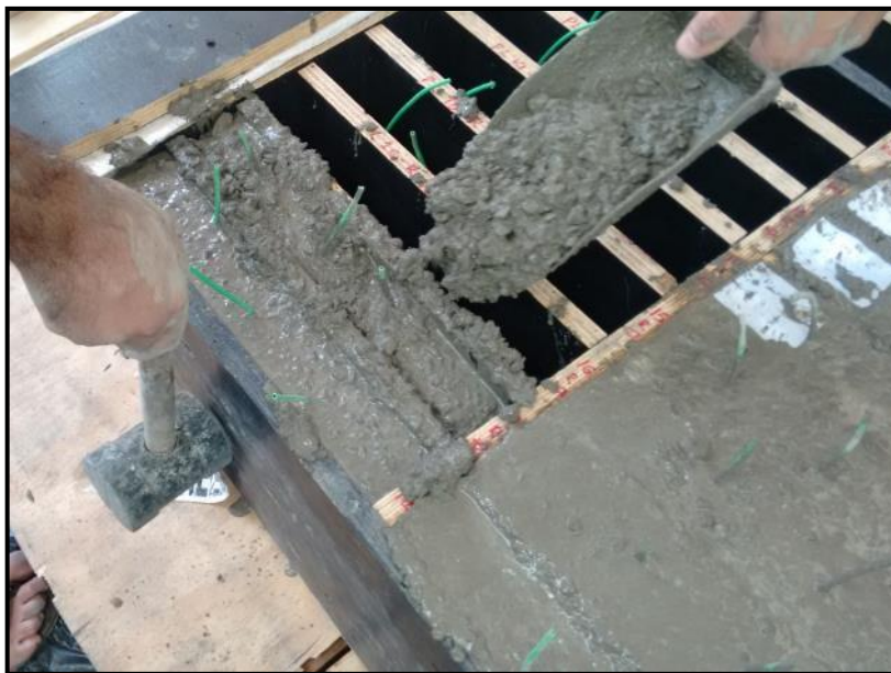
Figura 63-Adensamento feito com martelo de borracha batendo-se nas laterais e topo das fôrmas.
