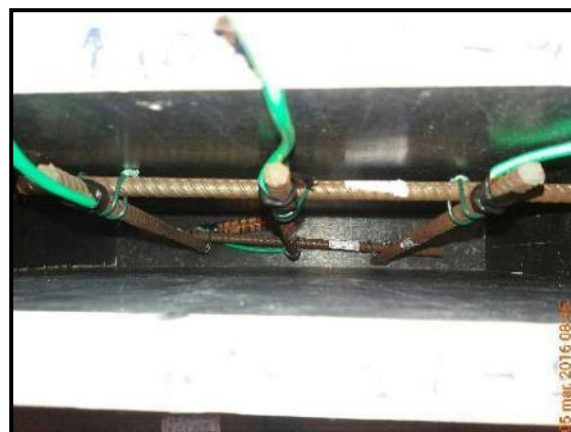
Figura 55-Detalhe da armadura dentro da fôrma.
