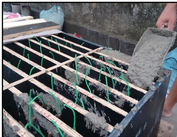
Figura 60- Processo de preenchimento das fôrmas com concreto.
