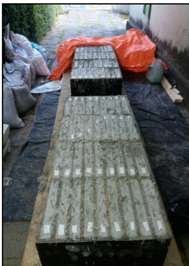
Figura 64- Visão geral no dia seguinte à concretagem
