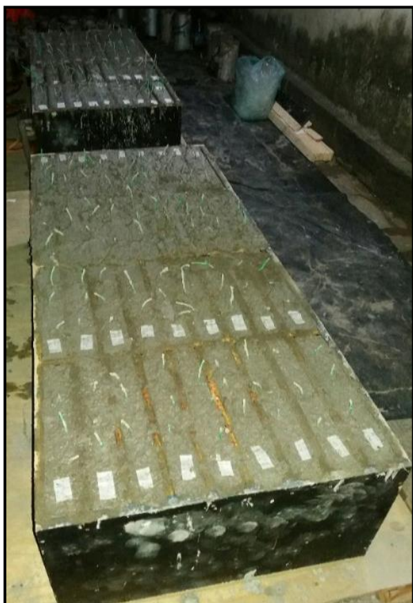
Figura 65-Foto logo após término da concretagem.
