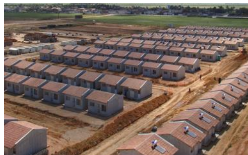
Figura 5- 812 unidades em São Miguel dos Campos-AL (2014)
