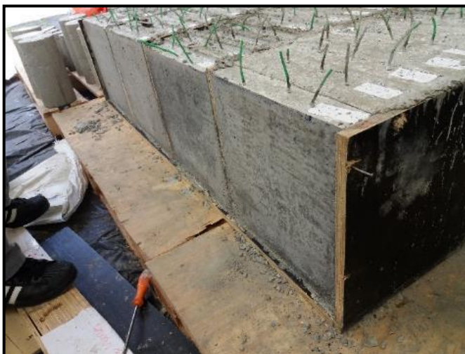
Figura 66- Retirada lateral de uma das fôrmas.
