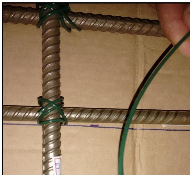
Figura 35-Detalhe da amarração com arame 18 galvanizado e plastificado.
