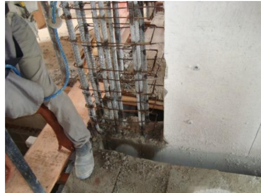
Figura 2.3 Exemplo de sistema de reforço por substituição total do concreto com demolição do pilar por etapas. (Acervo do autor)
