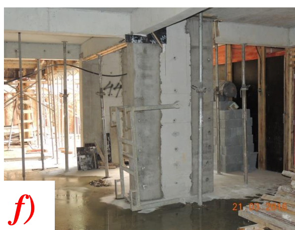
Figura 3.9 – a) Demarcação e escoramento localizado do pilar; b) Demolição do primeiro trecho do reforço; c) Primeiro trecho do reforço executado; d) Demolição do segundo trecho do reforço; e) Concretagem do segundo trecho do reforço; f) Pilar finalizado com extremidades reforçadas e núcleo mantido.
