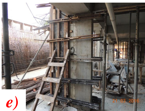
Figura 3.9 – a) Demarcação e escoramento localizado do pilar; b) Demolição do primeiro trecho do reforço; c) Primeiro trecho do reforço executado; d) Demolição do segundo trecho do reforço; e) Concretagem do segundo trecho do reforço; f) Pilar finalizado com extremidades reforçadas e núcleo mantido.
