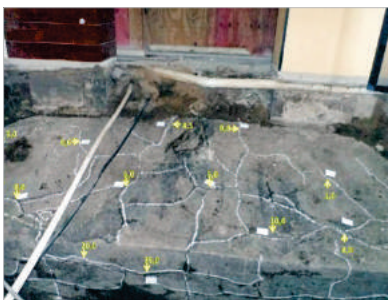
► Figura 12 Mapeamento das trincas e fissuras
