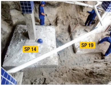
► Figura 11 Serviço de escavação das sapatas
