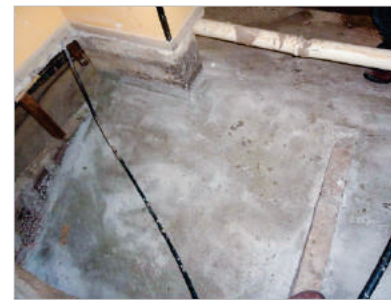
► Figura 17 Sapata concretada
