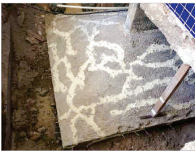
► Figura 15 Colmatação das trincas e fissuras
