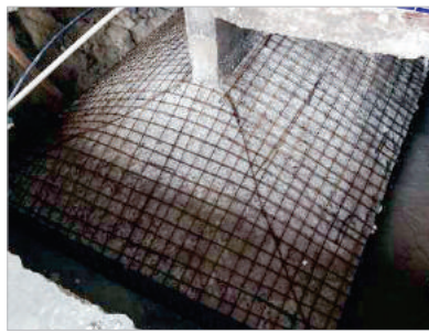
► Figura 16 Malha de aço para encapsulamento da sapata
