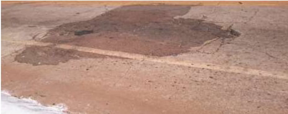
Figura 32- Buraco tapado com revestimento asfáltico no trecho 1 Fonte: Arquivo Próprio (2015).
