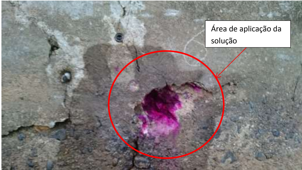
Figura 37- Ensaio de Carbonatação (2015). Fonte: Arquivo Próprio (2015).
