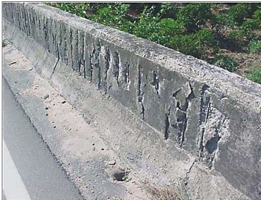
FIGURA 5 - Fissura ou trincas provocada por corrosão da armadura Fonte- DNIT (2010).
