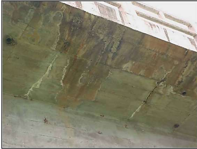
FIGURA 10 - Face inferior de laje em balanço sem pingadeira: Concreto deteriorado e armaduras aparentes com corrosão. Fonte: DNT (2010).
