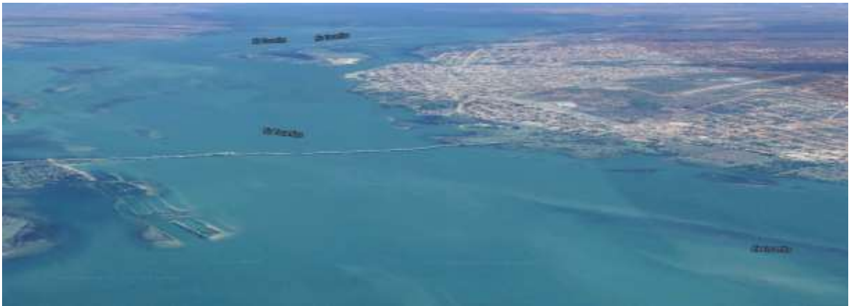
Figura 19- Vista frontal da Ponte Sobre o Rio Tocantins Fonte: Google maps (2015)
