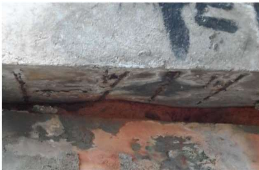
FIGURA 11 - Corrosão da armadura Fonte: Giovannetti (2014).
