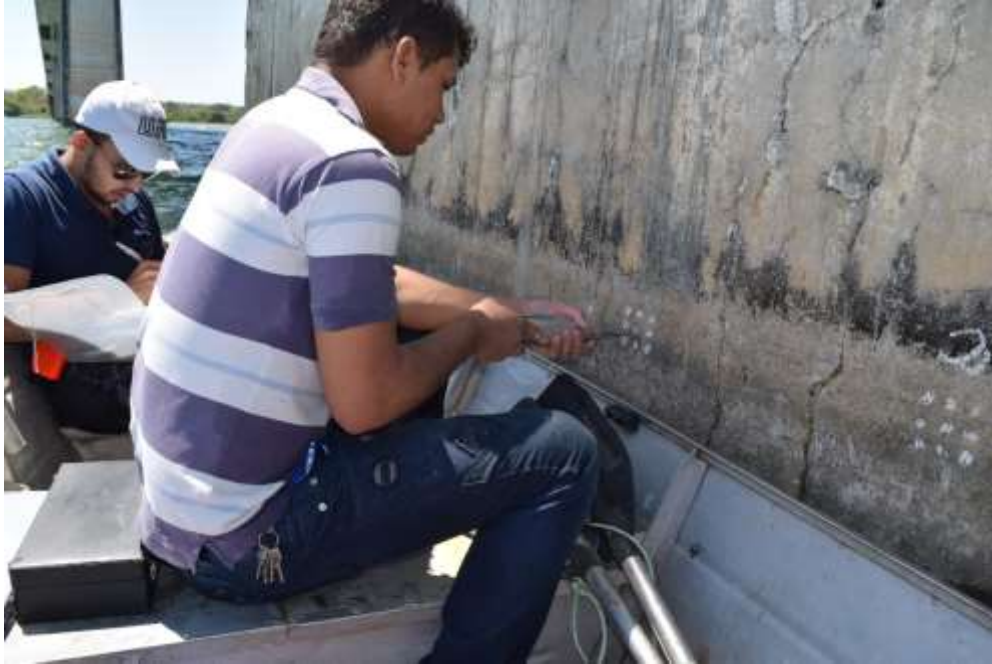
Figura 34- Realização do Ensaio de Esclerometria Fonte: Arquivo Próprio (2015).
