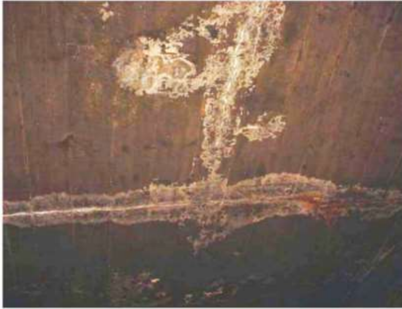
FIGURA 8 - Carbonatação do concreto e armaduras expostas. Fonte: DNIT (2004).
