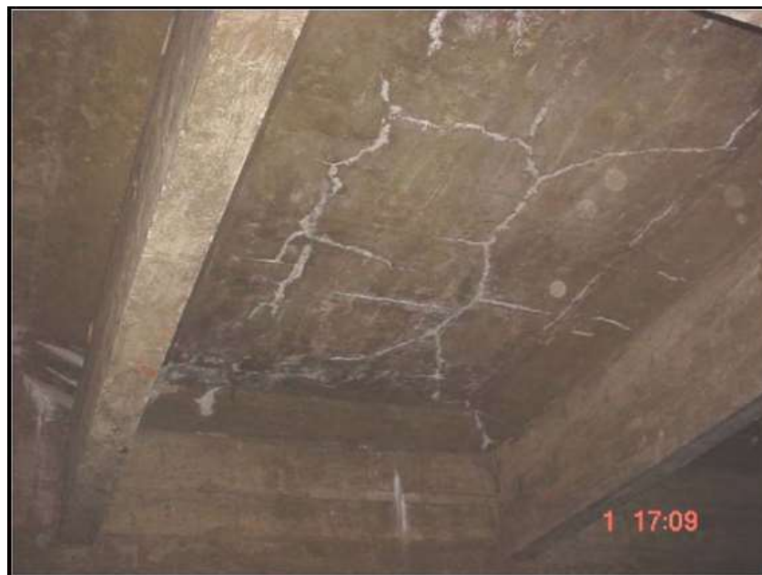
FIGURA 3 - Retração plástica do concreto e presença de eflorescência. Fonte: DNIT (2010).
