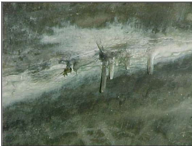
FIGURA 12 - Eflorescência na parte interna da laje da ponte. Fonte: DNIT (2010).
