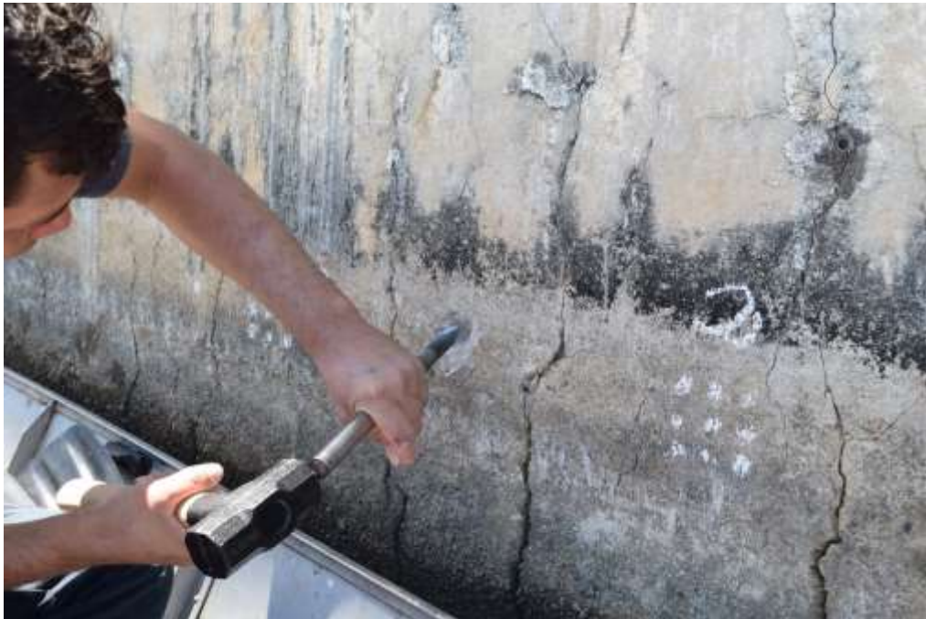
Figura 36- Abertura da Superfície para Ensaio de Carbonatação. Fonte: Arquivo Próprio (2015).
