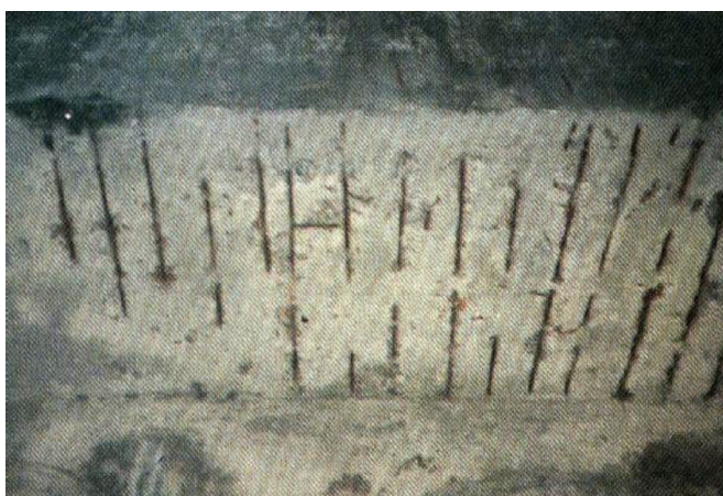
Figura 2.6 – Corrosão generalizada da armadura de uma laje devido ao ataque por cloro, com desagregação do concreto de cobertura.
