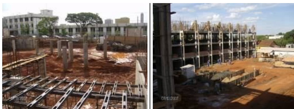
Figura 6.1 – Fotos do edifício em construção.
