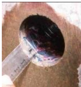
Figura 4.11 – Ensaio de carbonatação em extração de testemunho.
