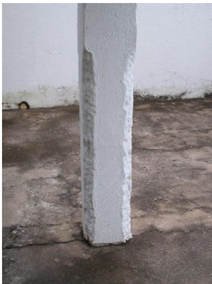
Figura 5.3 – Intervenção inadequada realizada pelo usuário.
