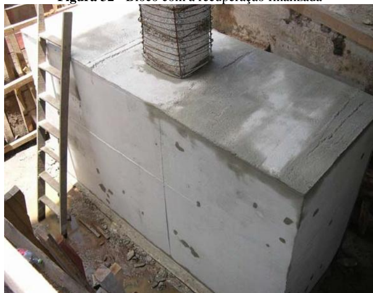
Figura 32 - Bloco com a recuperação finalizada
