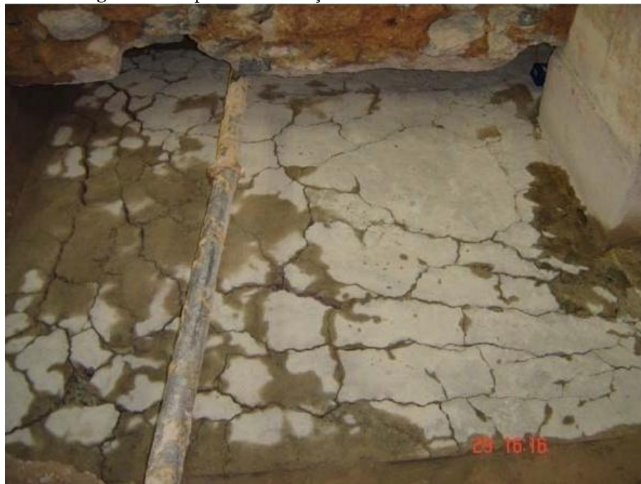
Figura 30 - Aspecto da fissuração encontrada em um dos blocos
