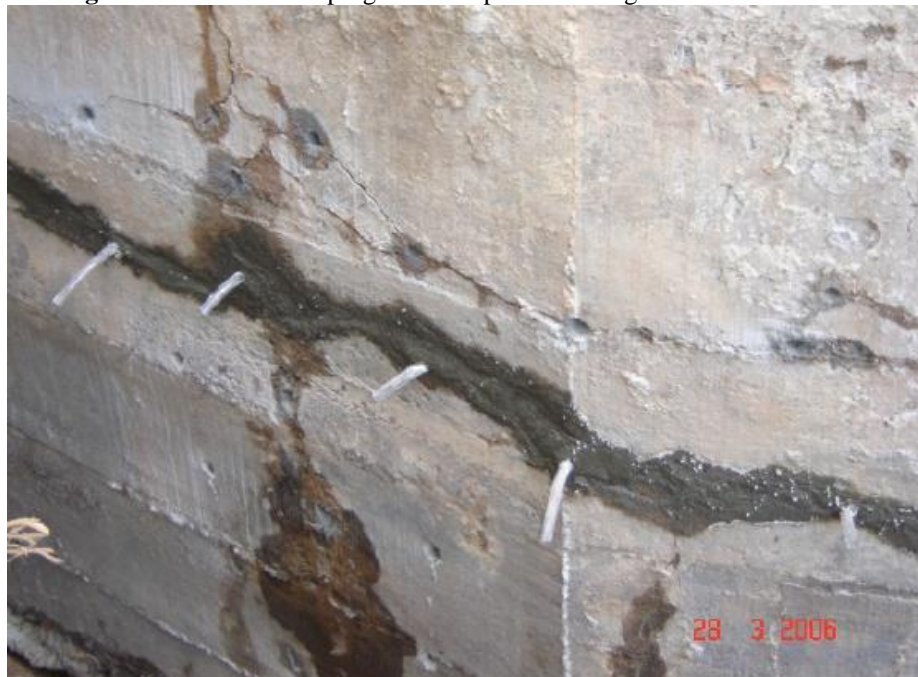
Figura 28 - Detalhe dos purgadores dispostos ao longo de uma das fissuras
