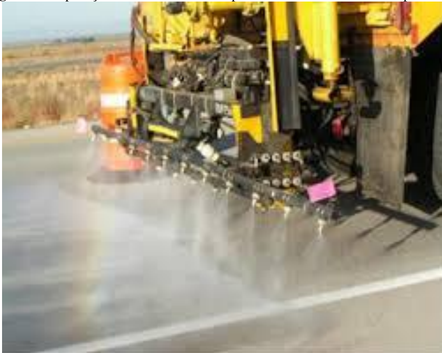
Figura 20 - Aplicação de nitrato de lítio em pavimento de concreto afetado pela RAA
