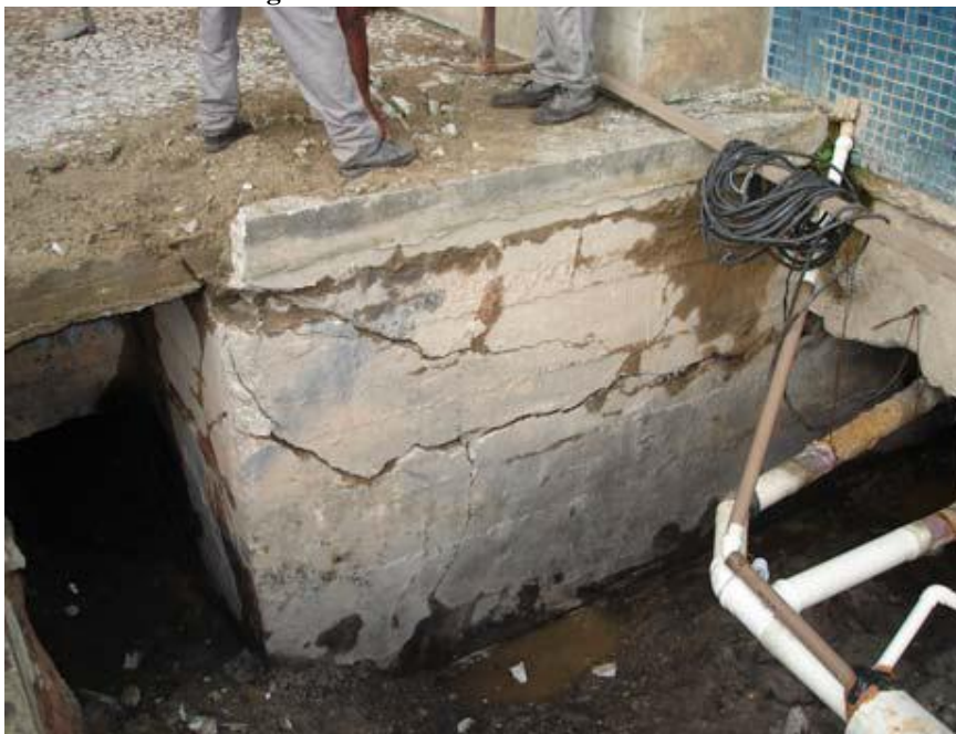
Figura 27 - Bloco fissurado lateralmente
