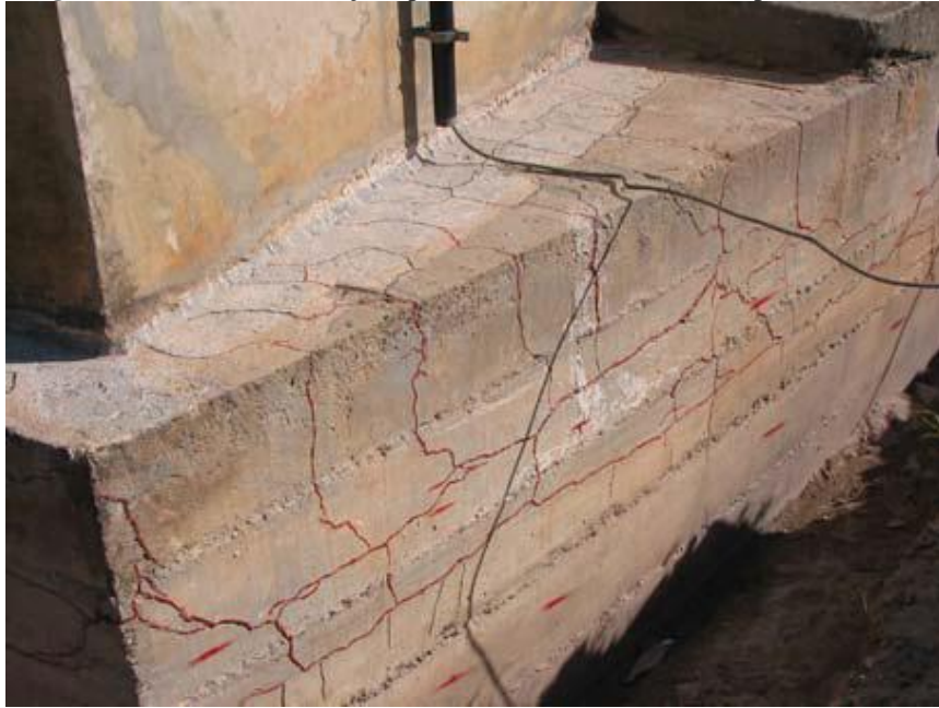
Figura 26 - Bloco de fundação apresentado fissuras na face superior e lateral
