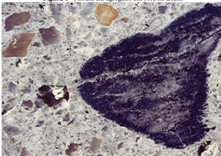
Figura 8 - Fissura em agregado em obra no Brasil
