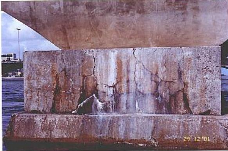
Figura 23 - Bloco apresentando lixiviação e fissuração em forma de “mapa”
