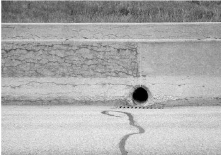
Figura 21 - Lado direito de muro tratado com pintura à base de siloxano, em Quebec-Canadá
