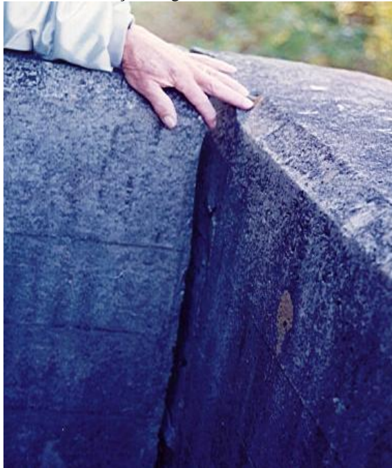
Figura 10 - Junta de contração surgida em razão da RAA, em obra nos EUA
