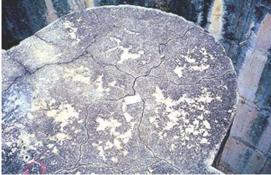
Figura 1 - Topo de pilar de vertedouro de barragem com fissuras típicas da RAA
