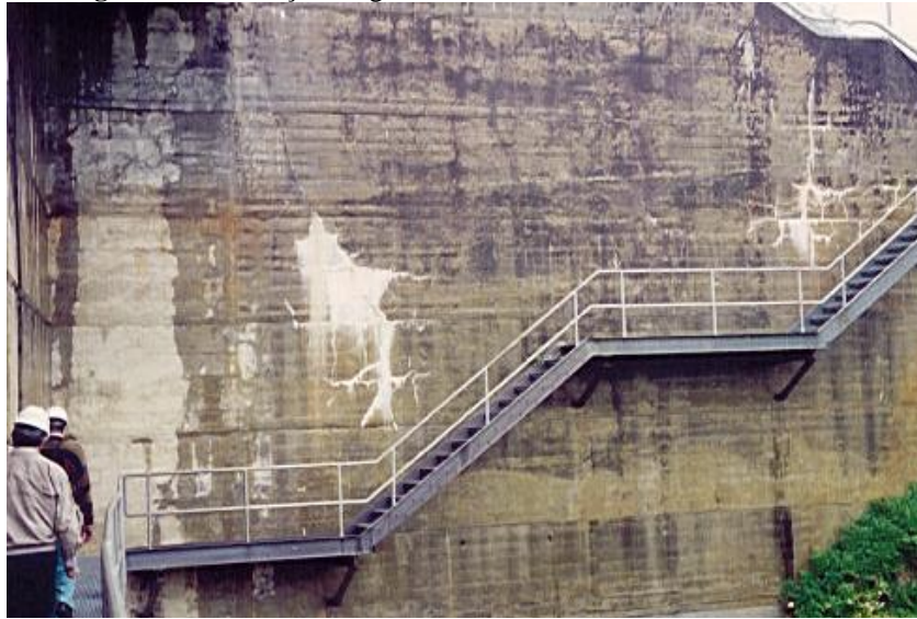
Figura 9 - Exsudação do gel através das fissuras, em obra nos EUA
