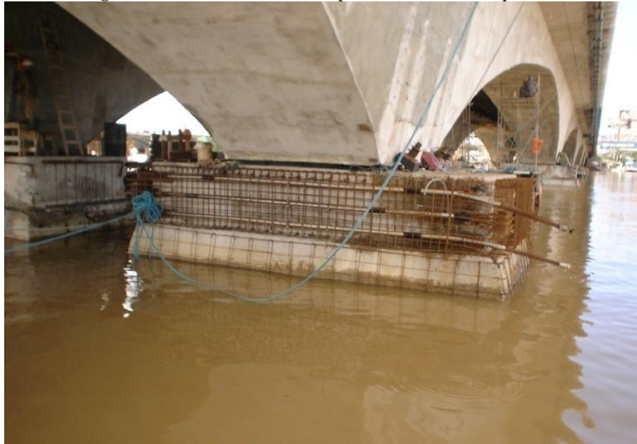
Figura 25 - Detalhe dos cabos de protensão e armadura passiva
