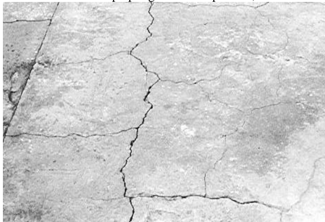
Figura 11 - Fissuras do tipo poligonais na superfície, em obra no Brasil
