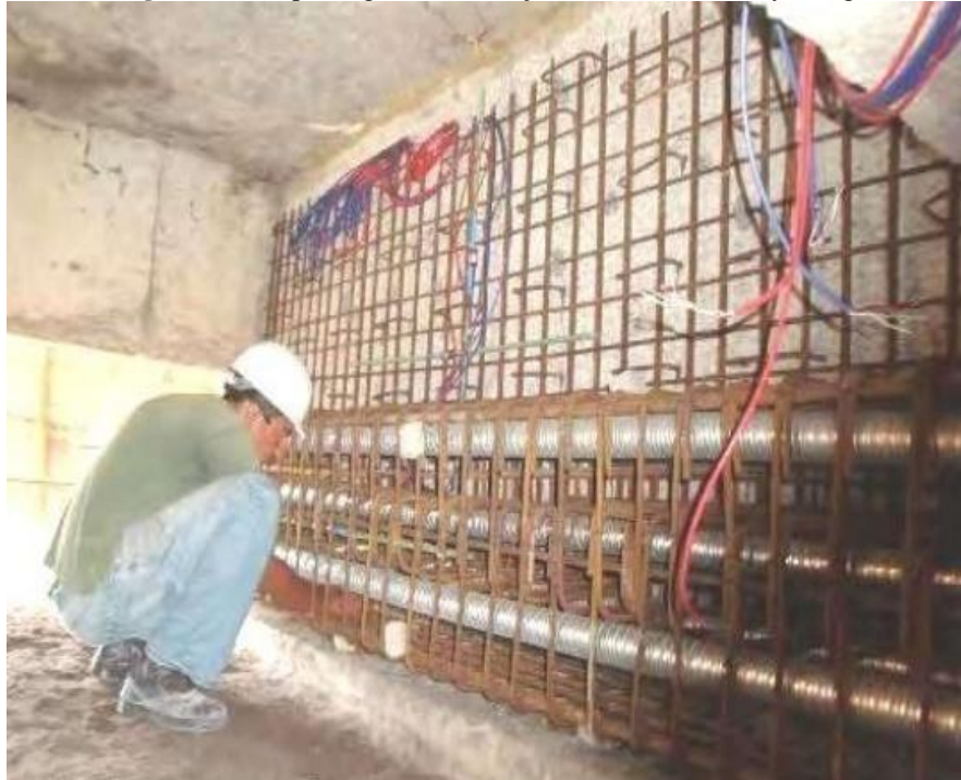
Figura 29 - Aspecto geral do reforço com as barras de dywidag
