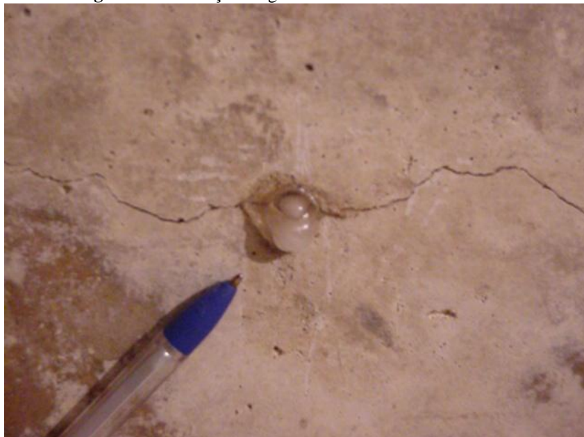
Figura 7 - Exsudação do gel através de fissura no concreto
