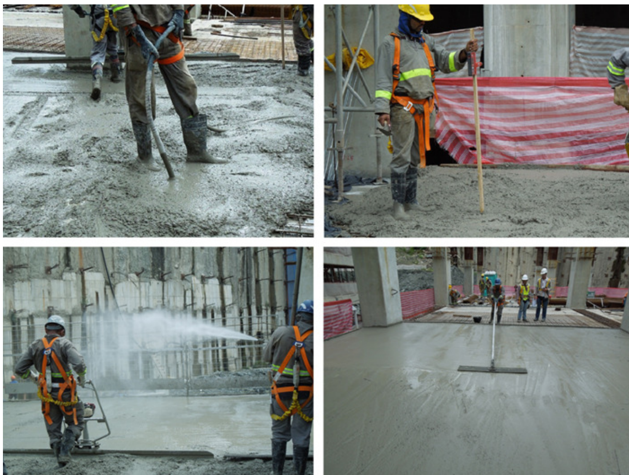
Figura 10 – Detalhe dos procedimentos de execução adotados durante o evento de concretagem no Shopping da Gleba A.
