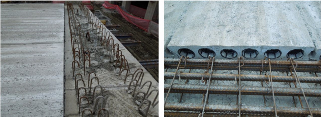
Figura 4 – Detalhe do alinhamento das lajes e da proteção dos alvéolos.
