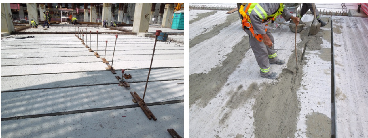
Figura 6 – Detalhe da equalização (à esquerda) e do preenchimento prévio com concreto de brita 0 das frestas entre as lajes alveolares (à direita).
