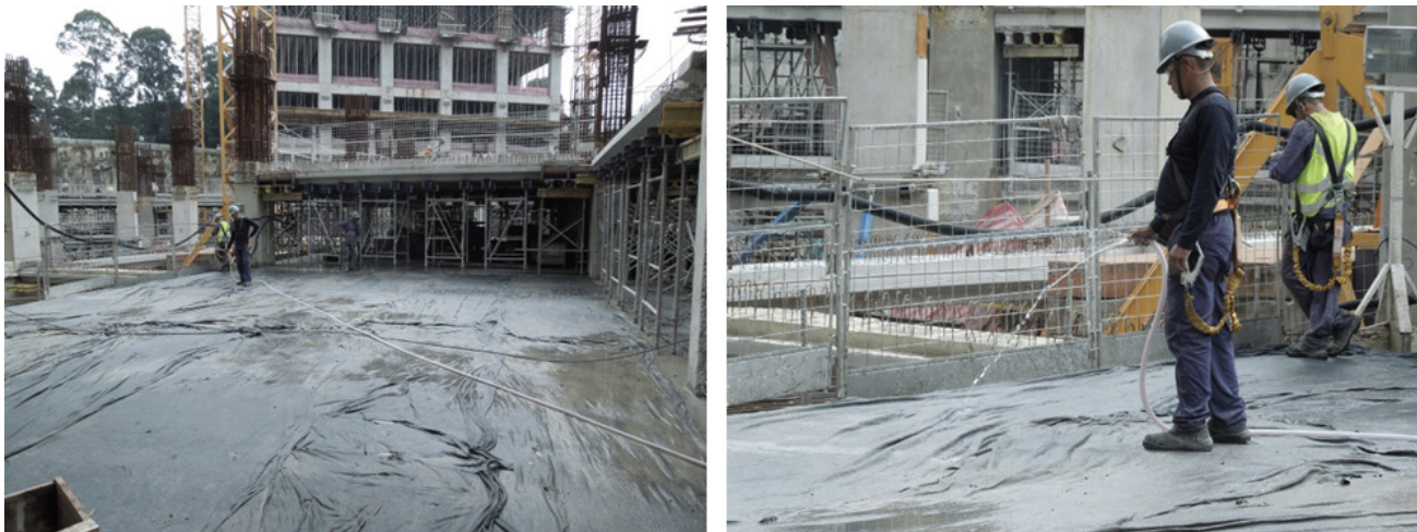
Figura 11 – Detalhe da execução da cura úmida do concreto aplicado no capeamento das lajes.
