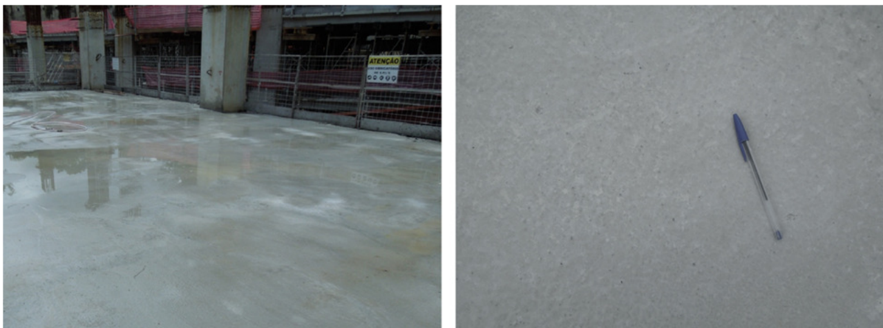
Figura 12 - Detalhe do acabamento superficial do concreto da laje do G4 do Shopping (ainda sem o polimento final).
