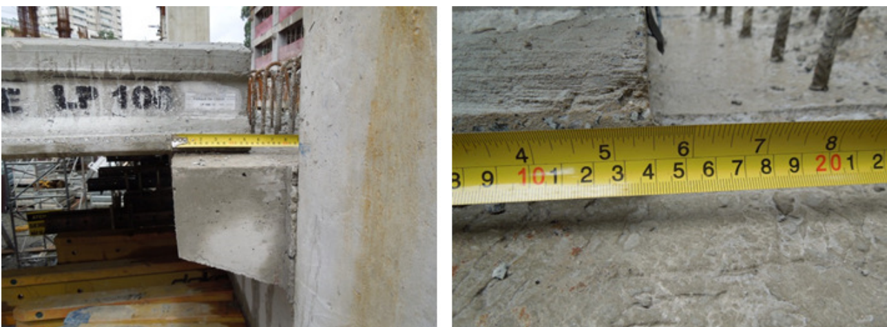
Figura 5 – Detalhe do comprimento de apoio das lajes alveolares sobre os consoles das vigas pré-fabricadas da estrutura do Shopping da Gleba A.
