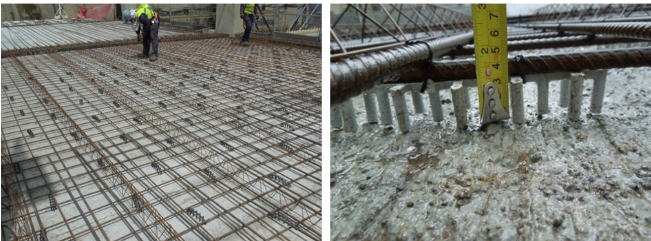
Figura 8 – Detalhe dos espaçadores plásticos utilizados nos panos de laje (região super-capas).
