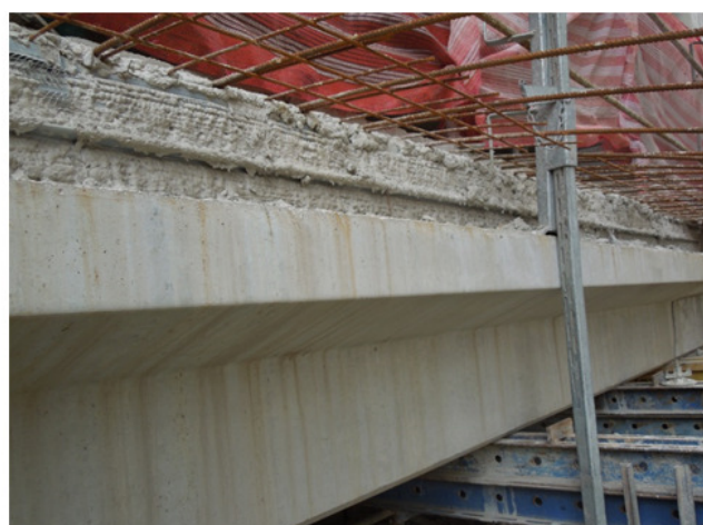
Figura 7 – Detalhe da junta de concretagem entre panos de laje contíguas executada com tela galvanizada tipo quick jet .
