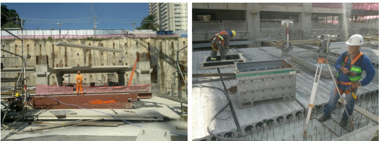
Figura 3 – Detalhe da montagem dos elementos pré-fabricados do Shopping - Gleba A (posicionamento da laje alveolar) e do acompanhamento da equipe de topografia.
