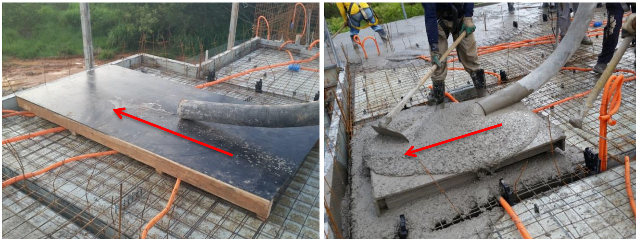
Figura 8 – Lançamento do concreto com o auxílio de plataformas de madeira. Atenta-se ao fato de que o mangote foi posicionado na direção horizontal sobre a plataforma.
