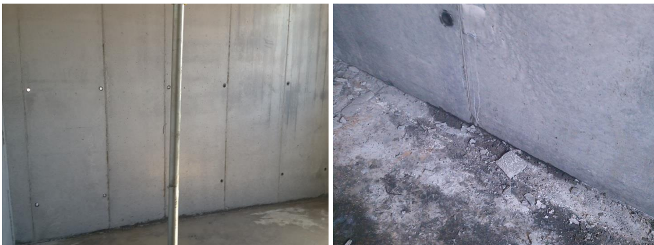
Figura 15 – Qualidade superficial das paredes de concreto do empreendimento Residencial Jardim Novo Horizonte (vista interna). Detalhe das bases, sem falhas de concretagem.
