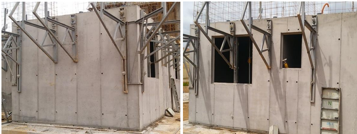
Figura 12 – Qualidade superficial das paredes de concreto do empreendimento Residencial Jardim Novo Horizonte (vista externa).
