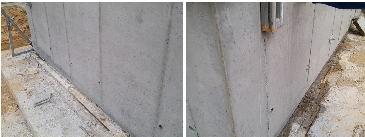
Figura 13 – Qualidade superficial das paredes de concreto do empreendimento Residencial Jardim Novo Horizonte (vista externa). Detalhe das bases, sem falhas de concretagem.
