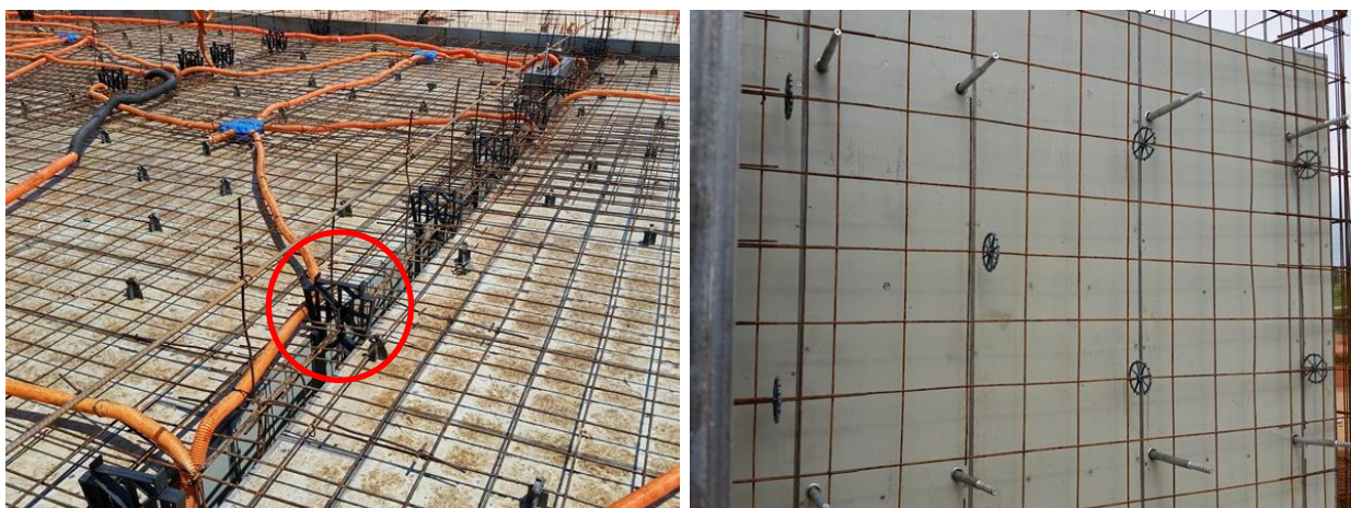
Figura 6 – Detalhe do gabarito de espessura do tipo galga e dos espaçadores do tipo circular.
