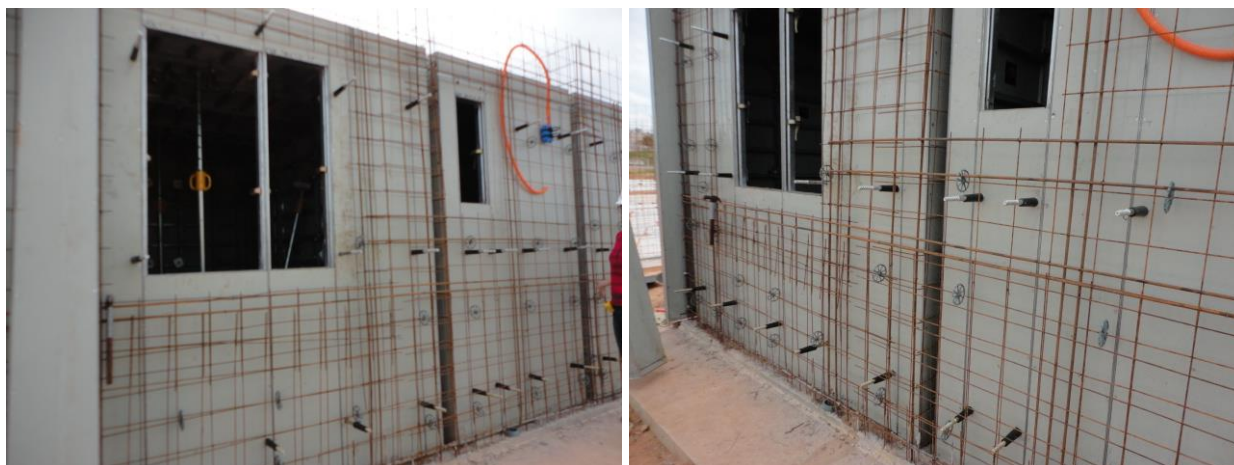
Figura 5 – Detalhe das fôrmas empregadas, com revestimento interno de polipropileno.
