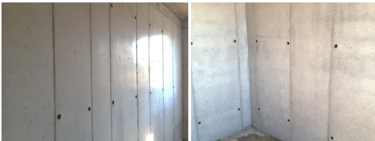
Figura 14 – Qualidade superficial das paredes de concreto do empreendimento Residencial Jardim Novo Horizonte (vista interna).
