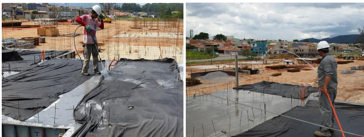
Figura 11 – Execução de cura com manta encharcada sobre as lajes do Residencial Novo Horizonte.
