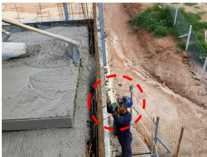
Figura 9 – Aplicação de impactos na face externa das fôrmas durante a concretagem, com o uso de martelo de borracha.
