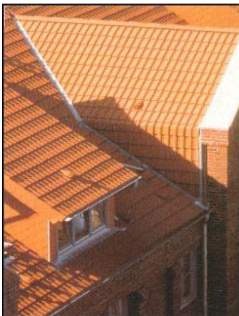
Figura 1.5 Vista de cubierta de techo realizada con tejas de hormigón coloreado
