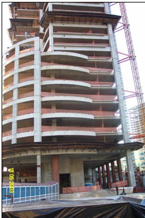
Figura 1.1 Vista del edificio "e-Tower" y columnas de hormigón coloreado
