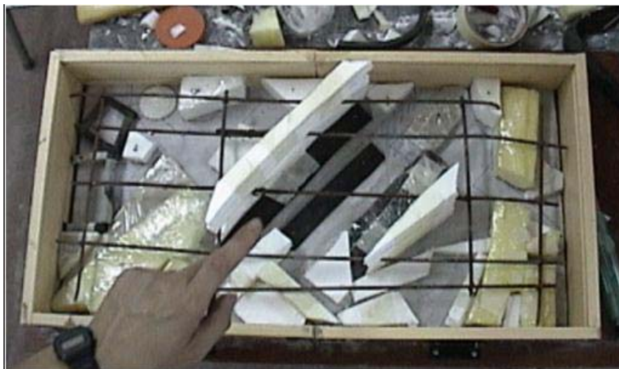
Fig. 3 Construcción del encofrado, armado y transferencia del dibujo, agregando volúmenes (Año 2002)
