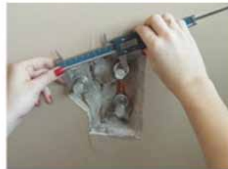
Figura 18 – Detalhe da medição da distância entre pinos com auxílio de paquímetro digital.
