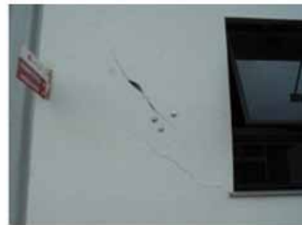
Figura 16 – Vista da instrumentação instalada.
