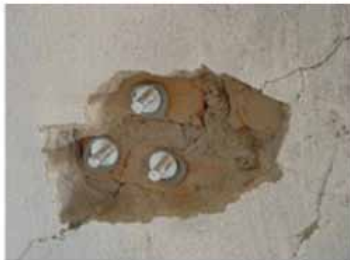
Figura 17 – Detalhe do sistema de instrumentação com pinos.
