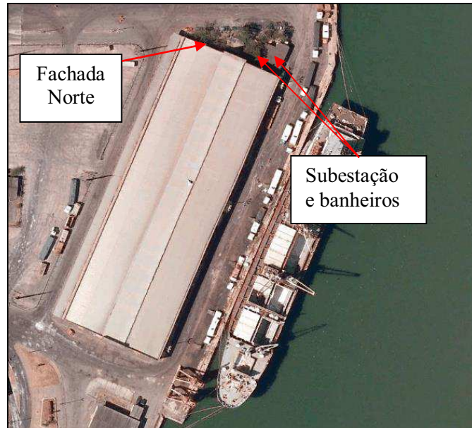
Foto 4.7 – Situação da Fachada Norte.
