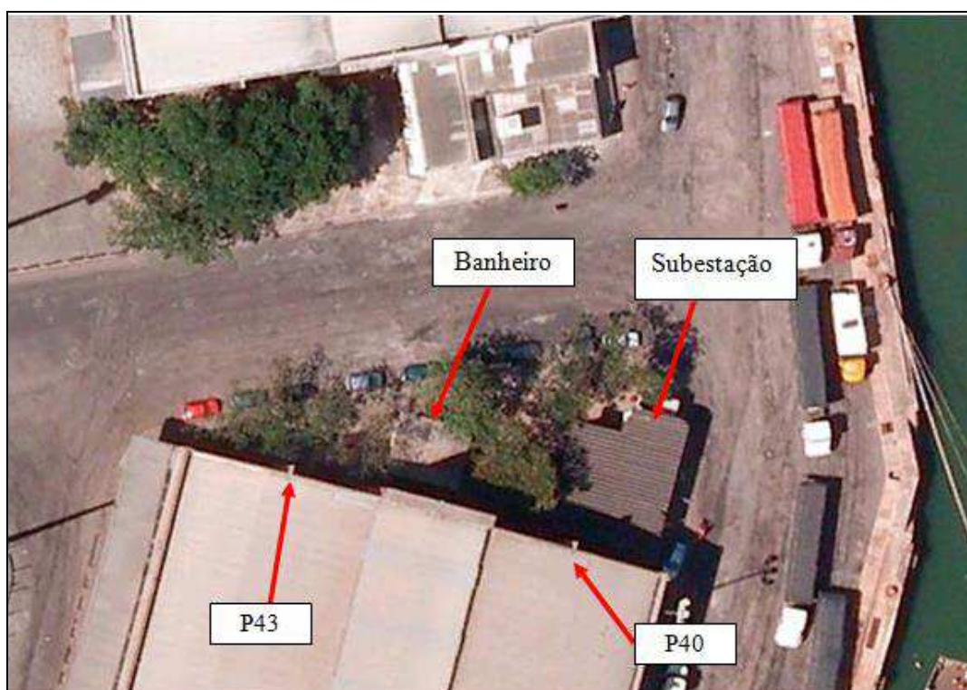
Foto 4.38 – Posicionamento dos Pilares P43 e P40 e da subestação elétrica e banheiros.
