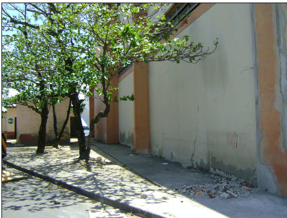
Foto 3.7 – Vista da Fachada Norte.
