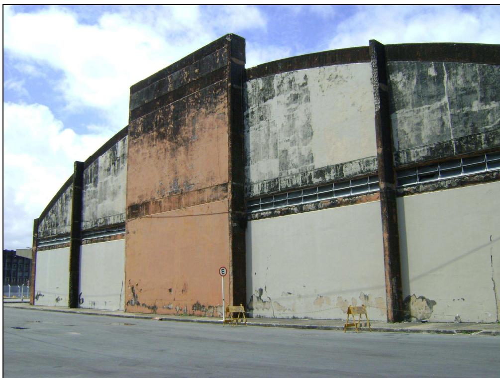
Foto 3.8 – Fachada Sul, dois cavaletes isolam a área com risco de queda de material.
