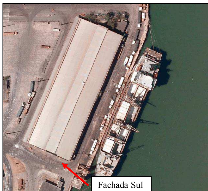
Foto 4.12 - Situação da Fachada Sul.
