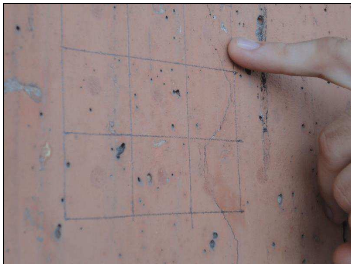
Foto 4.26 – Região descartada por conter fissuras superficiais.
