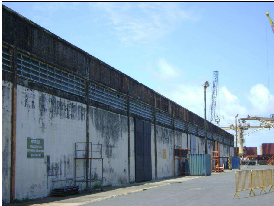
Foto 4.16 – Vista da Fachada Leste do Armazém 6 do Porto do Recife.
