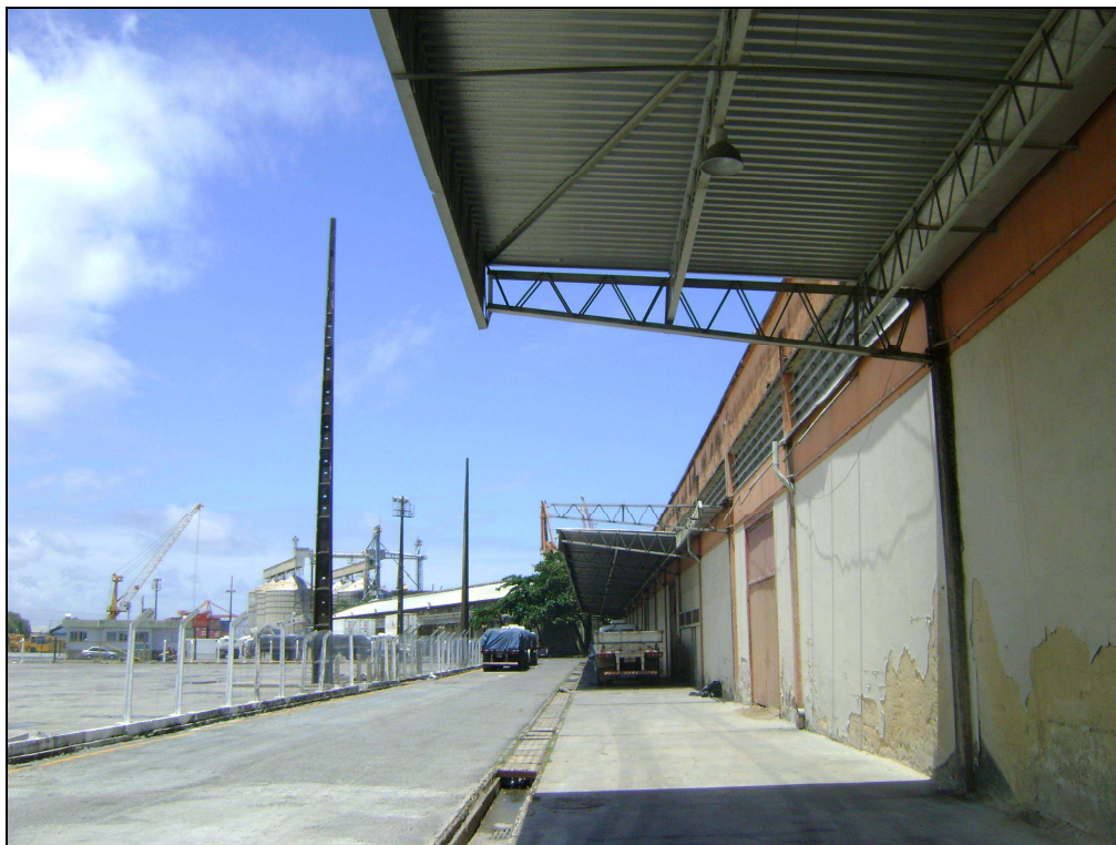
Foto 3.9 – Fachada Oeste, marquise em alumínio e o tráfego de caminhões.
