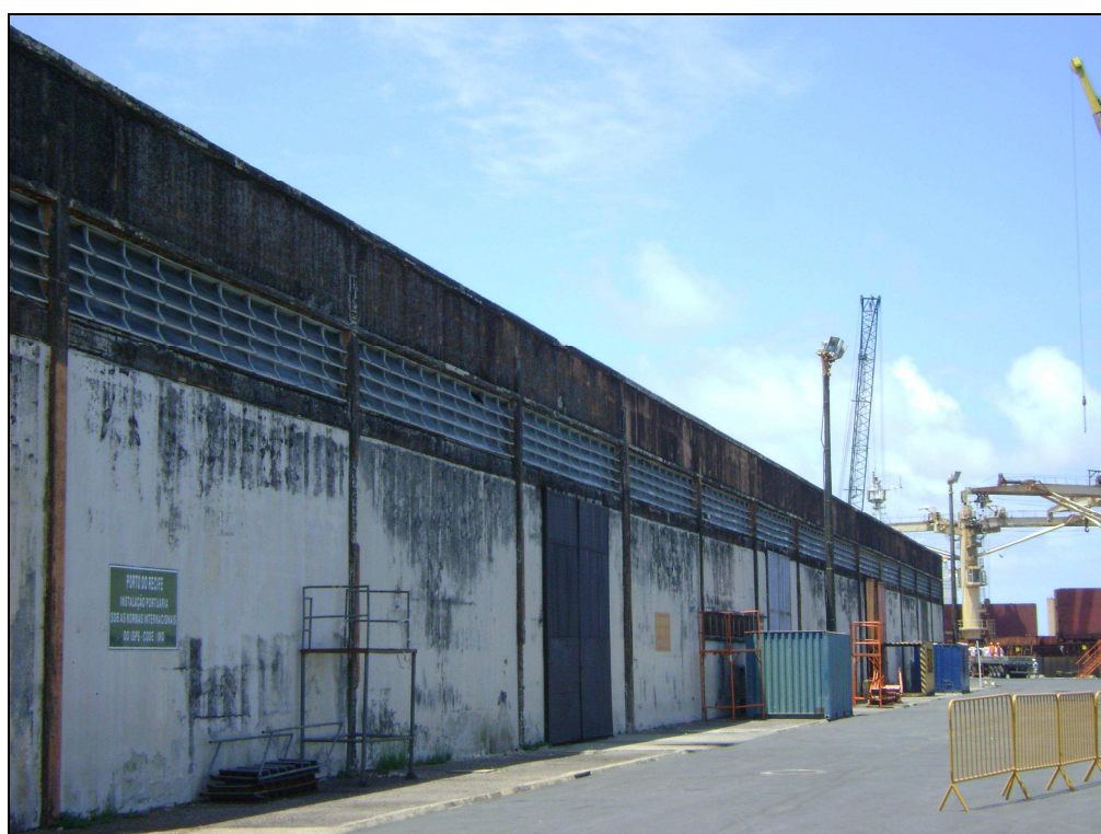
Foto 3.6 - Fachada Leste do Armazém 6.
