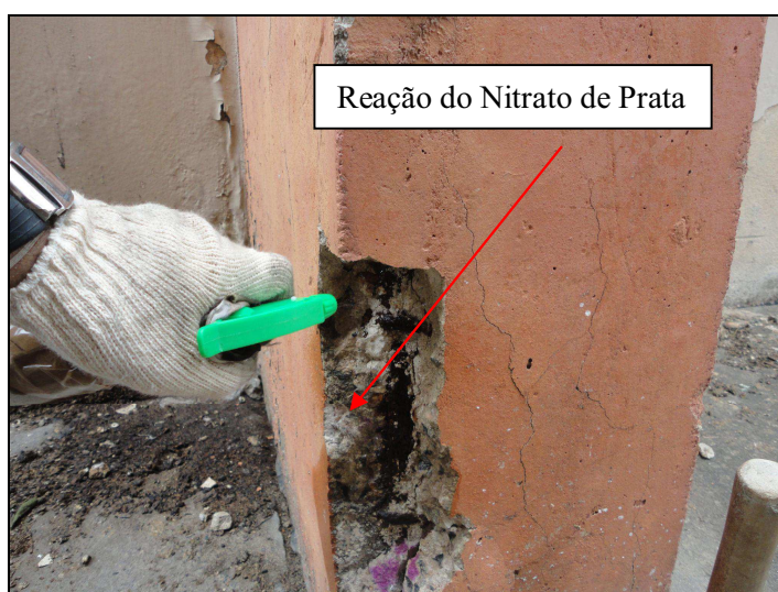
Foto 3.12 – Concreto após aplicação de solução de nitrato de prata.
