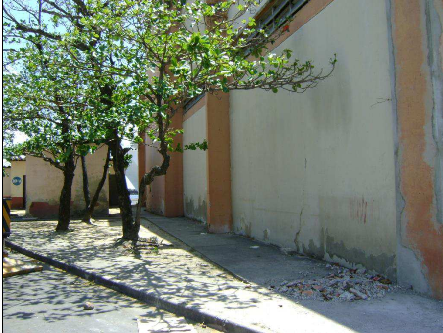
Foto 4.5 - Panorama da Fachada Norte.
