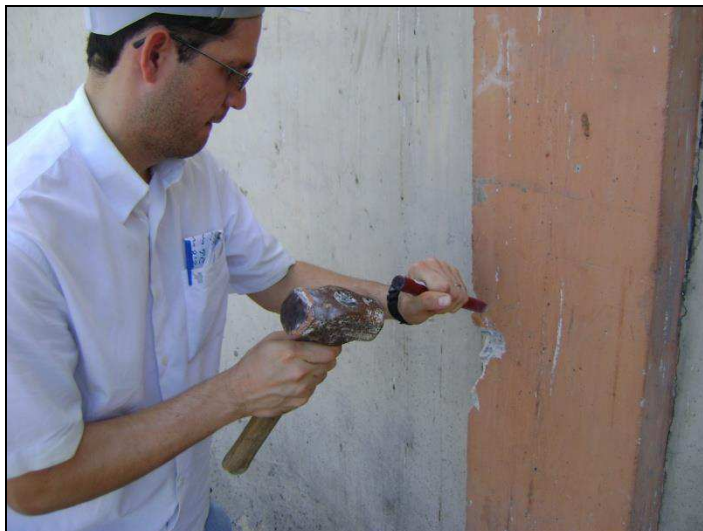
Foto 4.27 – Procedimento de abertura dos furos no Pilar P04.
