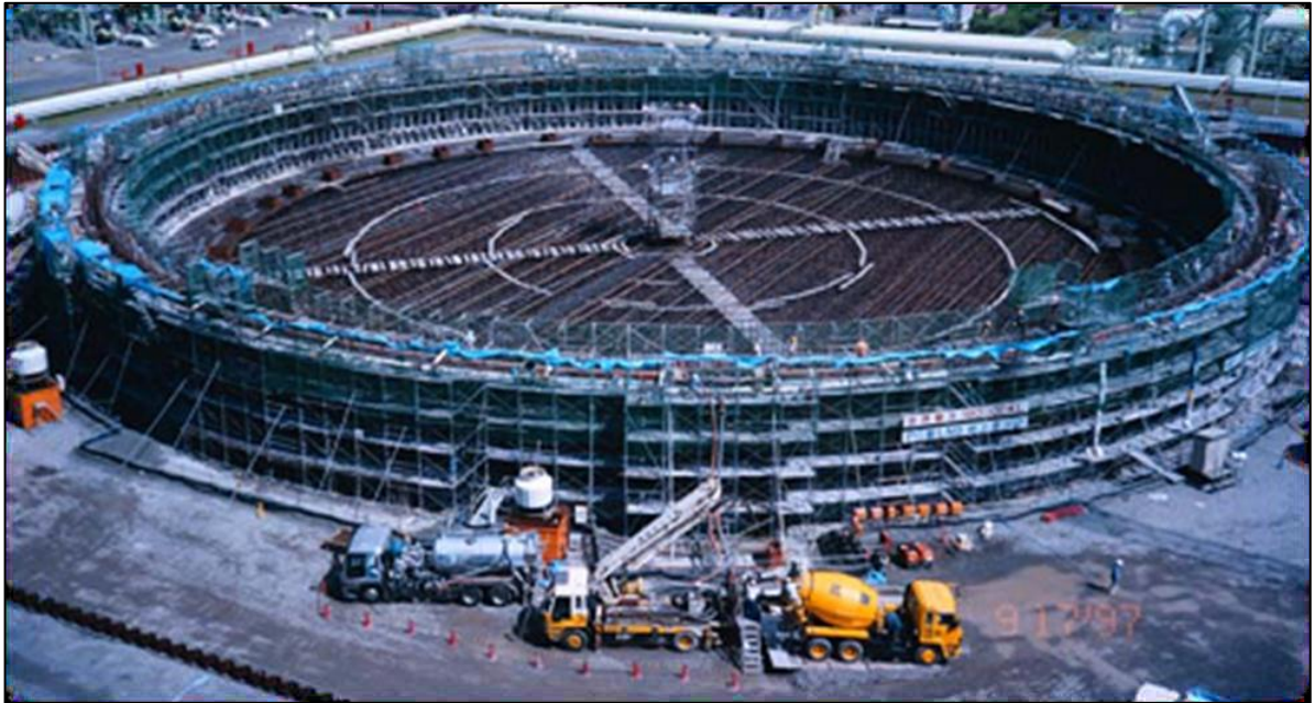
Figura 10 – Paredes do tanque para depósito de metano liquefeito sendo concretadas (“Osaka Gas Company”)
