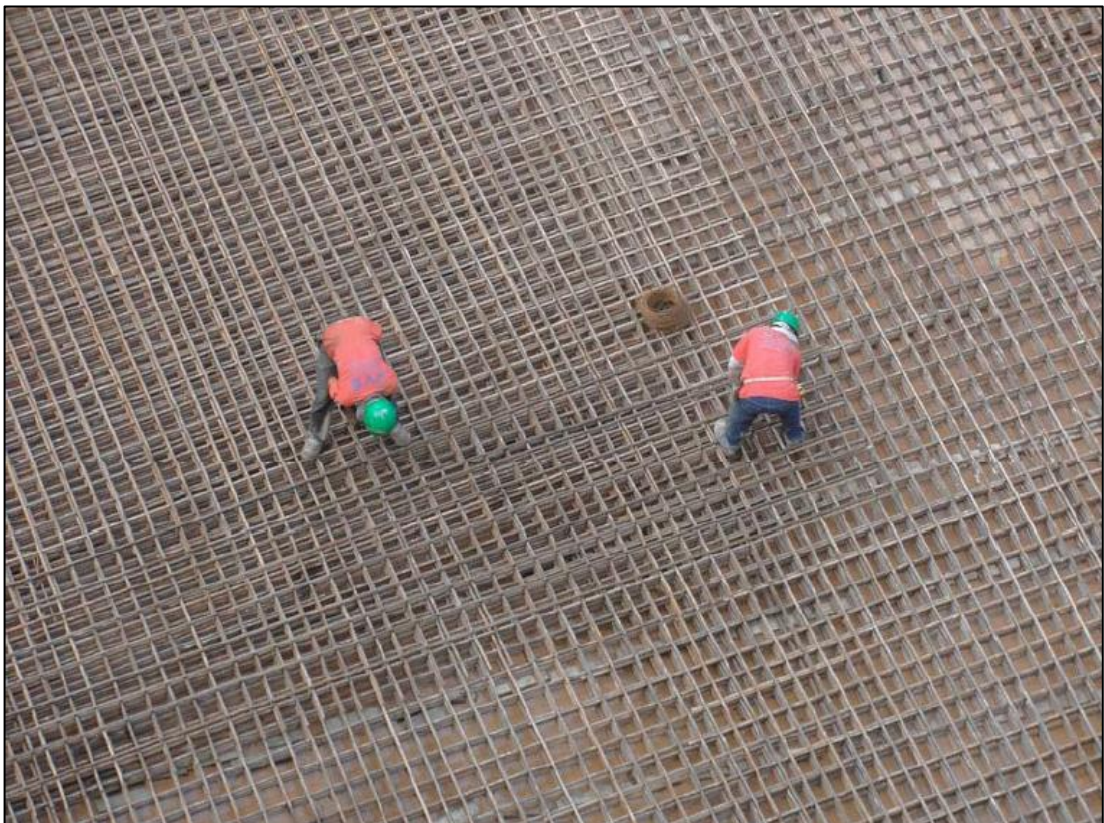
Figura 17 – Detalhe da armação da sapata central do edifício Infinity Tower
