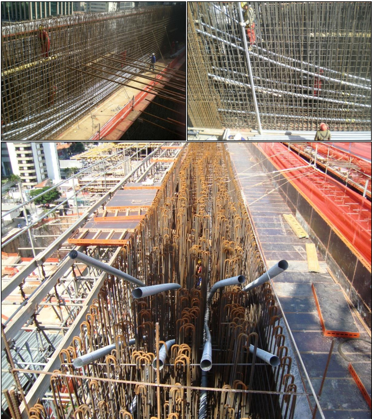
Figura 14 – Armação da Viga “T” do edifício Brookfield Malzoni
