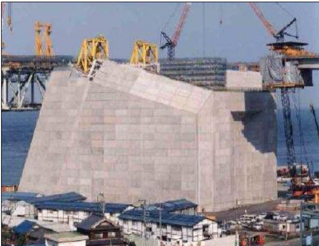
Figura 3 – Detalhe do bloco de ancoragem da ponte Akashi-Kaikyo
