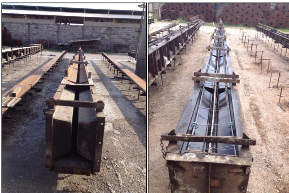
Figura 112– Detalhe da seção do poste a ser concretado com o CAA
