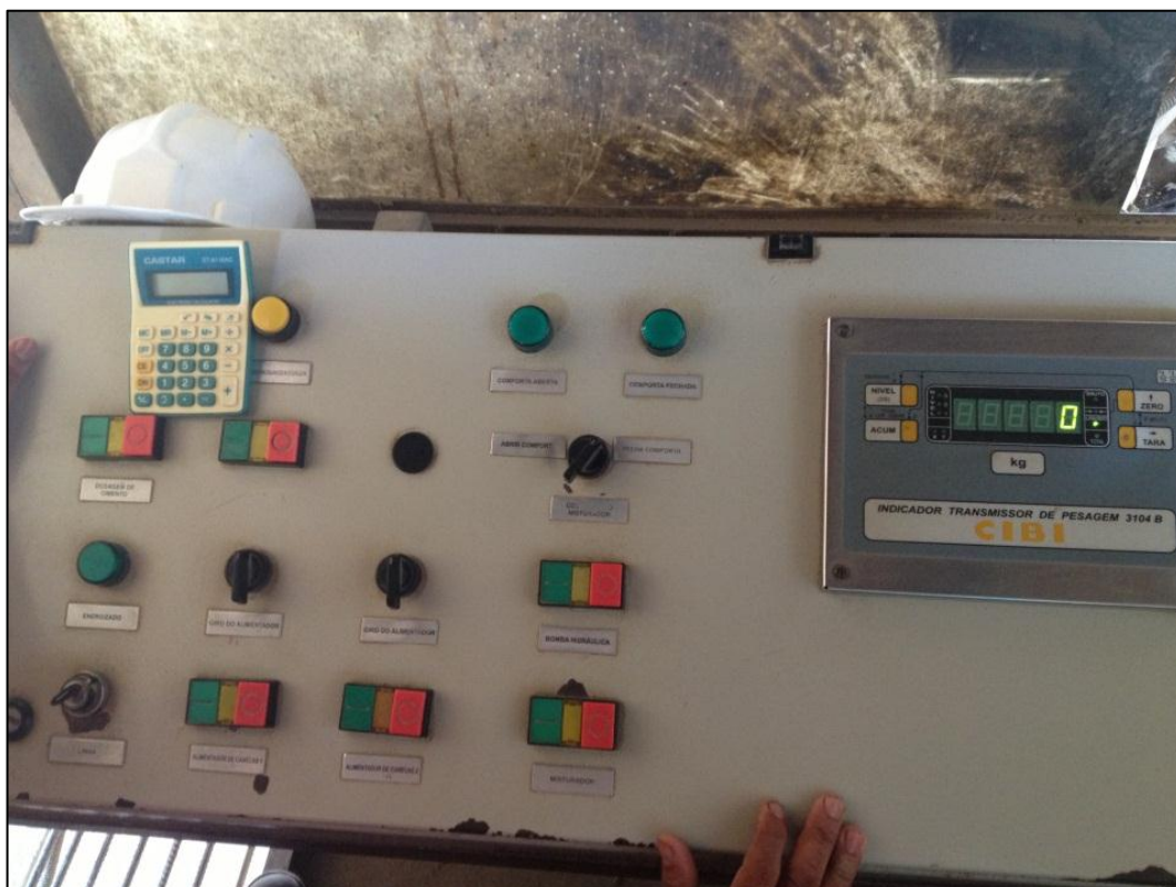
Figura 115 – Cabine do misturador para controle da pesagem dos materiais
