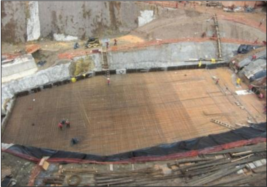
Figura 16 – Vista da sapata central do edifício Infinity Tower
