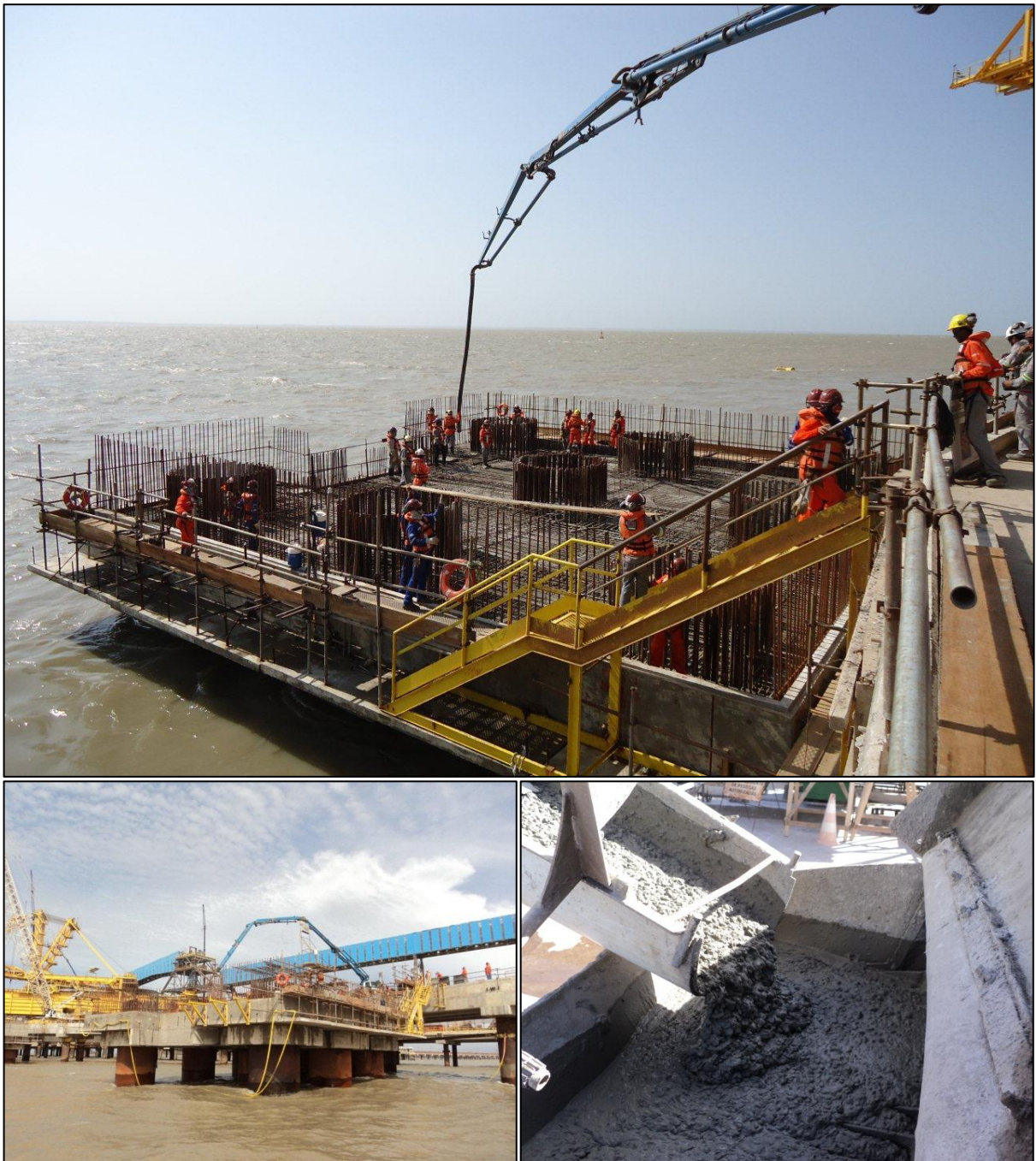
Figura 27 – Bloco e Estacas dos Dolphins de atracação do Píer IV
