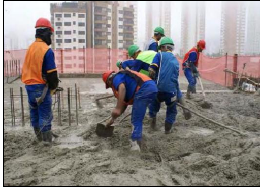
Figura 24 – Concretagem de uma laje com o CCV
