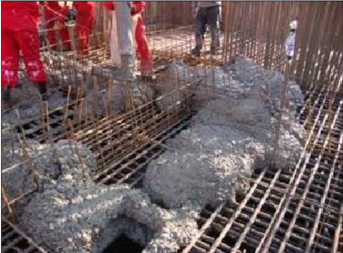
Figura 18 – Dificuldade de concretagem de um bloco de fundação feito em CCV
