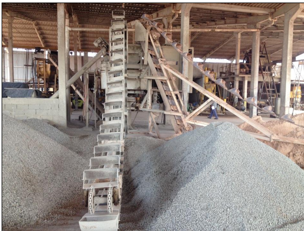
Figura 114 – Misturador de concreto
