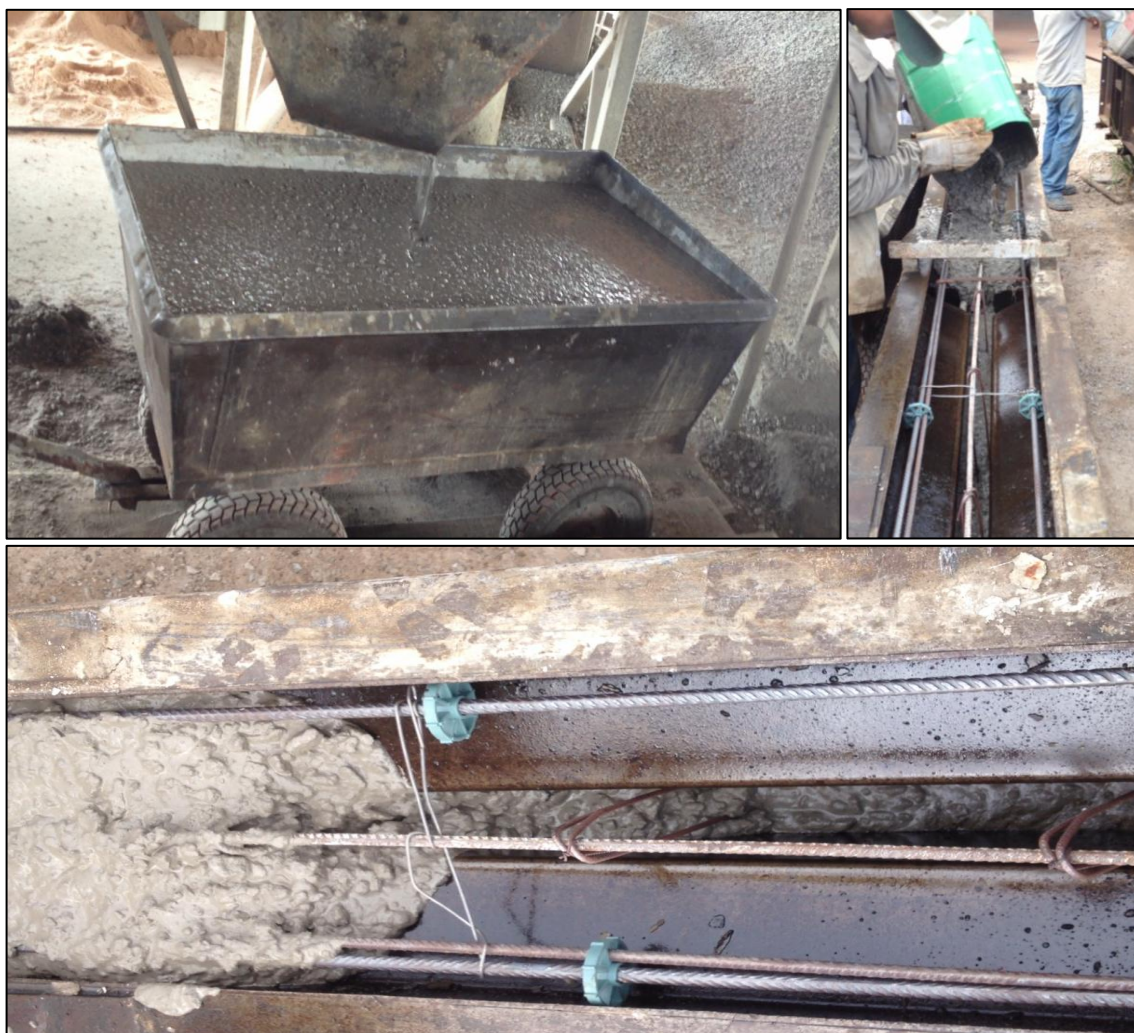
Figura 117 – Aplicação do CAA no poste
