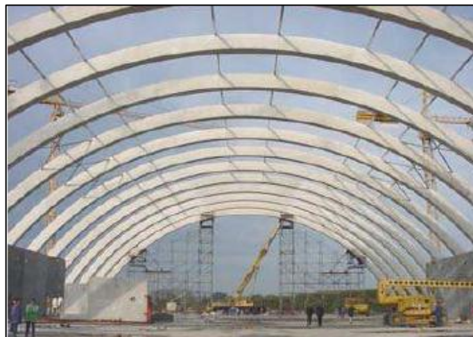
Figura 8 – Arcos compostos por cinco peças executadas em CAA
