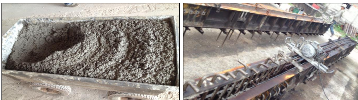
Figura 118 – Aspecto visual e tipo de adensamento usado para o CCV
