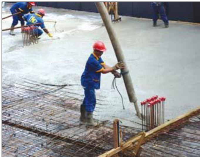
Figura 23 – Concretagem da laje do residencial Pateo São Paulo com utilização do CAA
