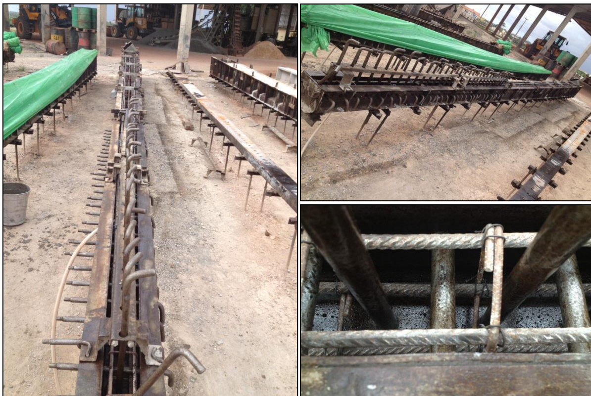
Figura 113 – Detalhe da armação do poste a ser concretado com o CAA
