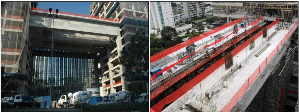
Figura 12 – Vigas “T” do edifício Brookfield Malzoni
