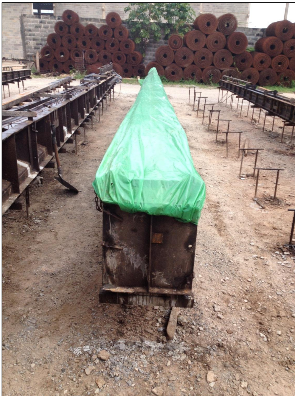
Figura 119 – Poste coberto após concretagem
