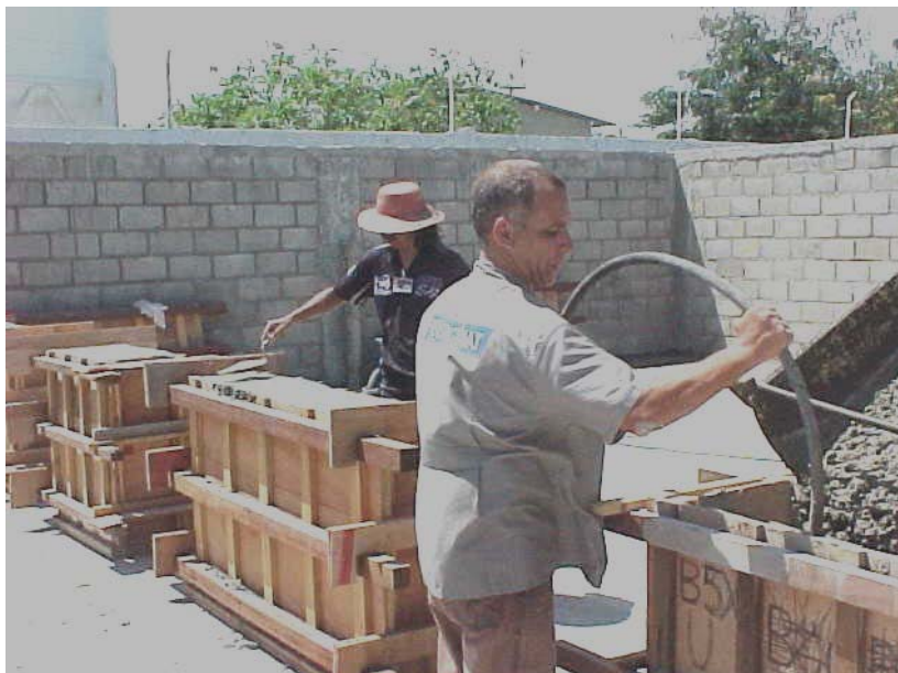
Figura 3.7 - Adensamento dos blocos no pátio da central dosadora da MARE CIMENTO Ltda. - POLIMIX (foto de 2004)
