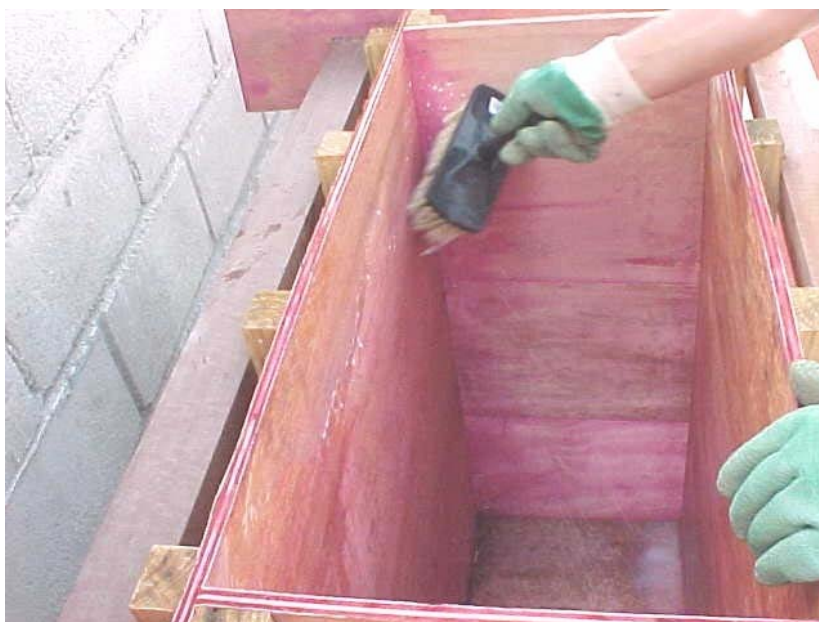
Figura 3.4 – Aplicação do desmoldante na forma no pátio da central dosadora da MARÉ CIMENTO Ltda. - POLIMIX (foto de 2004)
