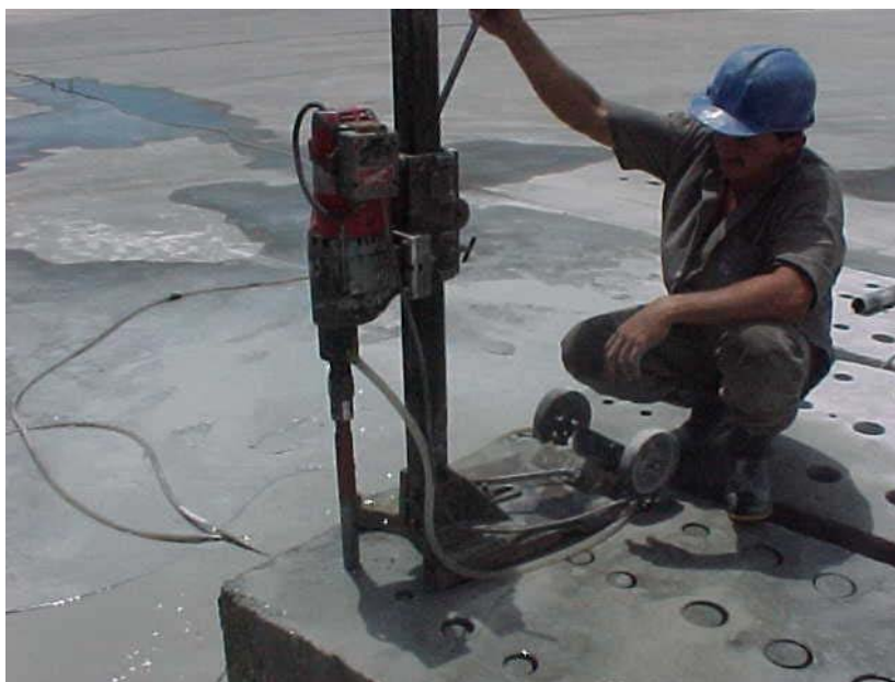
Figura 3.18 – Detalhe da extração dos testemunhos no pátio da central dosadora da MARÉ CIMENTO Ltda. - POLIMIX (foto de 2004)
