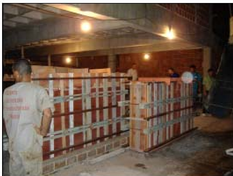
Figura 3.9 – Formas para moldagem dos 2 blocos no canteiro-de-obras do edifício Sansara (foto de 2005)
