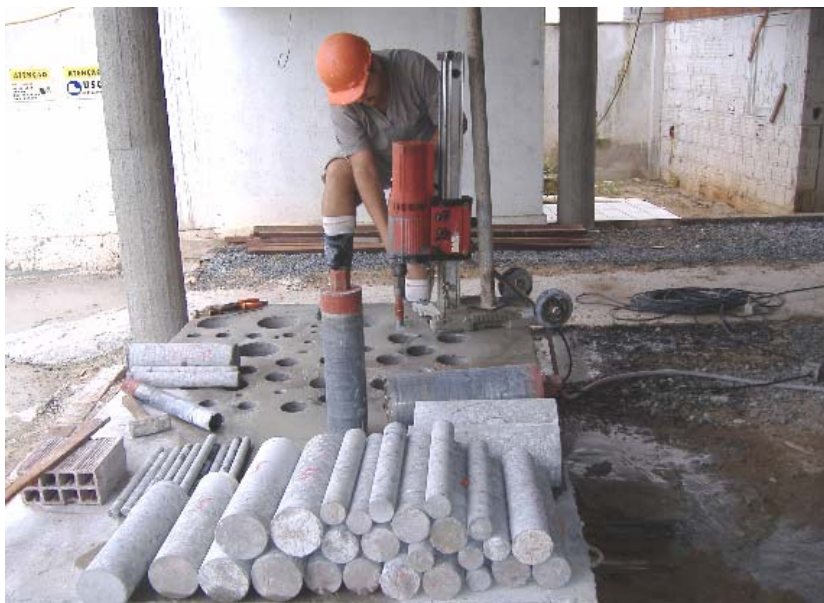
Figura 3.20 – Testemunhos de diversos diâmetros após a extração no canteiro-de-obras do edifício Sansara (foto de 2005)
