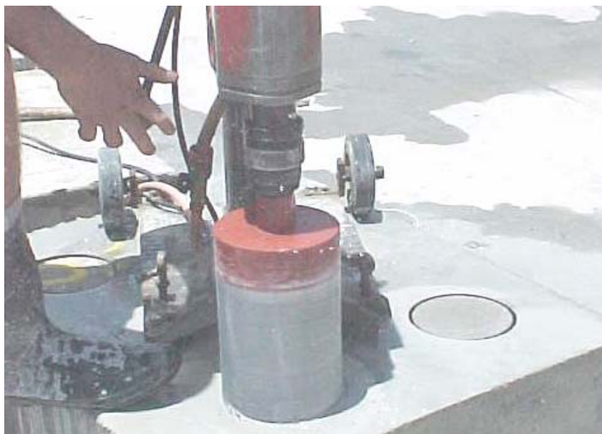
Figura 3.16 – Extração por sonda rotativa com coroa diamantada em bloco, no pátio da central dosadora da MARÉ CIMENTO Ltda. - POLIMIX (foto de 2004)
