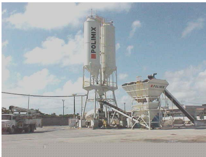
Figura 3.5 – Central dosadora da MARÉ CIMENTO Ltda. - POLIMIX localizada em Olinda/RMR (foto de 2004)
