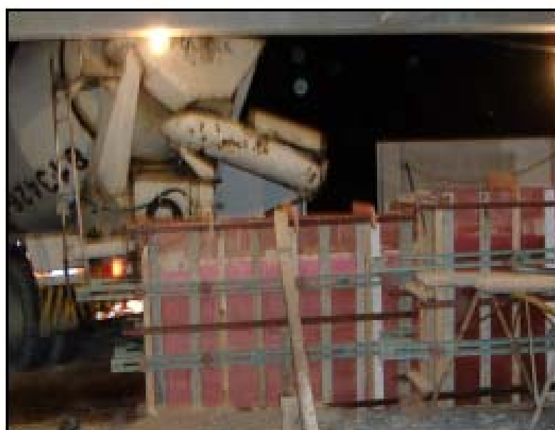
Figura 3.10 – Lançamento do concreto nos blocos no canteiro-de-obras do edifício Sansara (foto de 2005)
