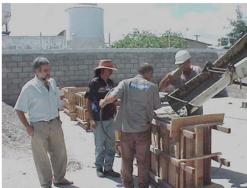
Figura 3.6 - Moldagem dos blocos no pátio da central dosadora da MARÉ CIMENTO Ltda. - POLIMIX (foto de 2004)
