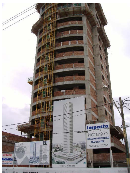
Figura 3.8 – Canteiro-de-obras do edifício Sansara - Av. Ministro Marcos Freire – Olinda/PE (foto de 2005)
