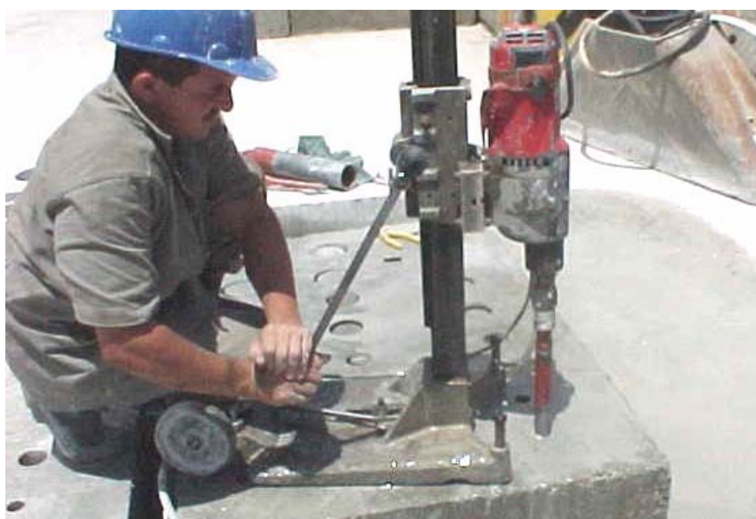
Figura 3.17 – Extração por sonda rotativa com coroa diamantada no pátio da central dosadora da MARÉ CIMENTO Ltda. - POLIMIX - (foto de 2004)
