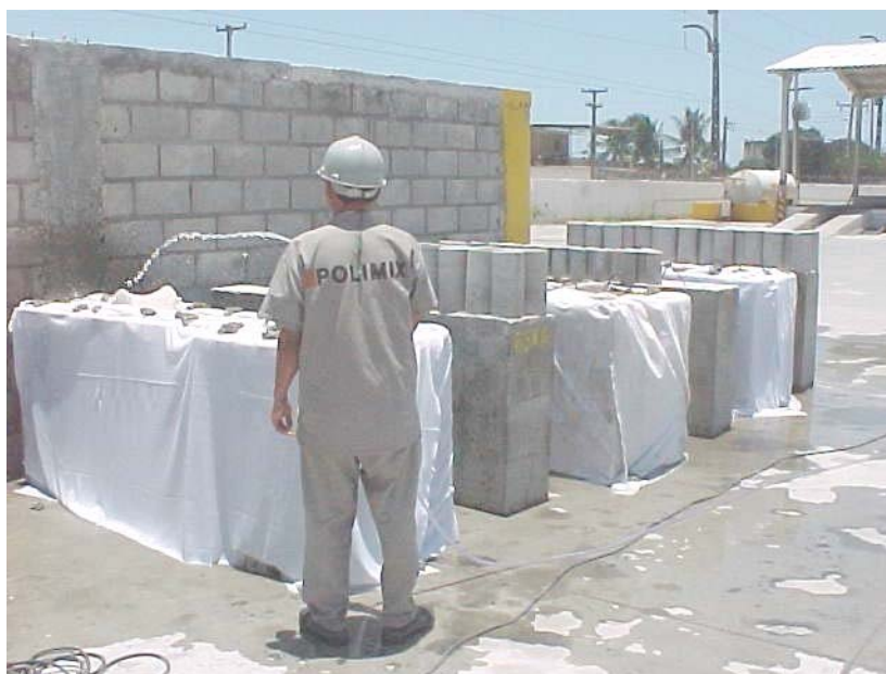
Figura 3.11 – Umedecimento dos blocos no pátio da central dosadora da MARÉ CIMENTO Ltda. - POLIMIX (foto de 2004)
