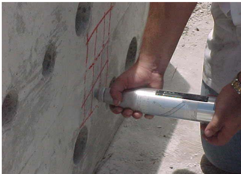
Figura 3.27 – Ensaio de dureza esclerométrica em bloco no pátio da central dosadora da MARÉ CIMENTO Ltda. - POLIMIX – equipamento SOILTEST - Model CT-320AM do Laboratório da Universidade Católica/PE (foto de 2004)
