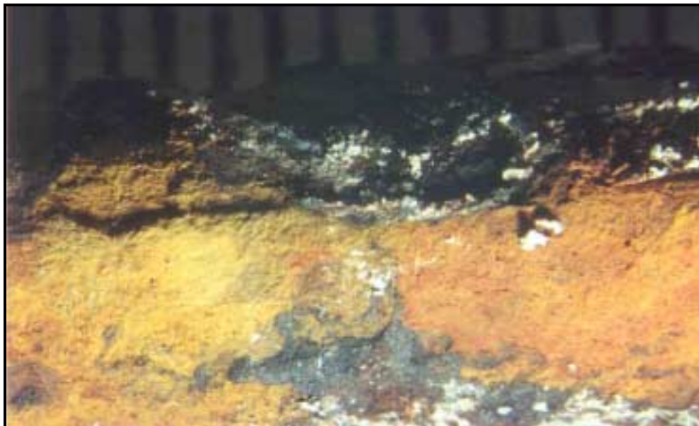
Figura 5.54- Fotografia do Detalhe C da armadura na lupa estereoscópica após o tratamento com o método de extração de íons cloreto das Séries Beta. Observa-se uma superfície irregular com produtos de corrosão em tom amarelado e alaranjado que pode significar a presença de goetita e lepidocrocita.
