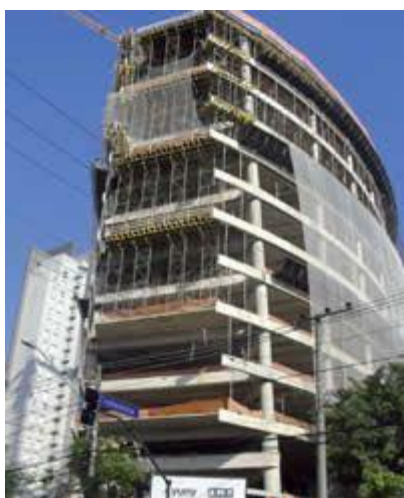
Vigas são nervuradas e laje maciça tem 10 cm de espessura
