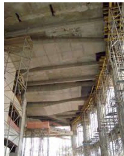
Vigas de transição do primeiro pavimento e dos pilares periféricos
