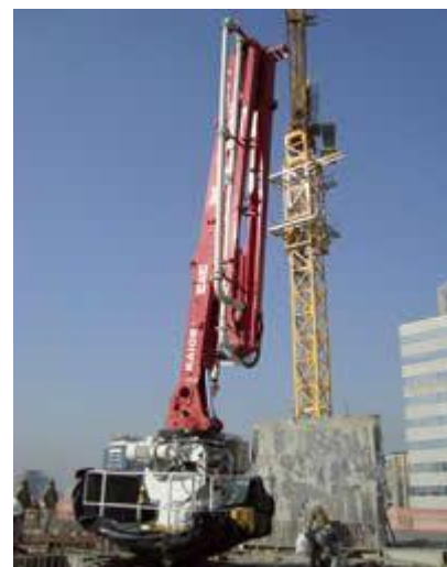
Equipamento "place and boom" foi utilizado para a execução das lajes
