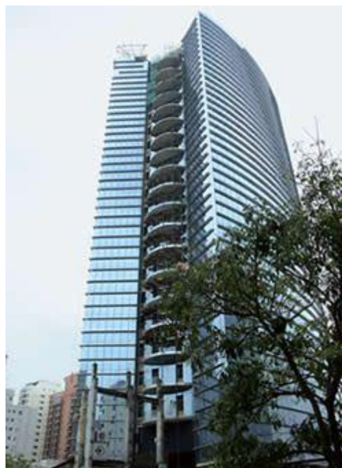
Empreendimento comercial Triple A tem fachada curva, inclinada e revestida com pele de vidro
