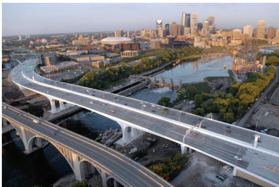
Figura 6. Nova ponte I-35W (à direita da foto).
