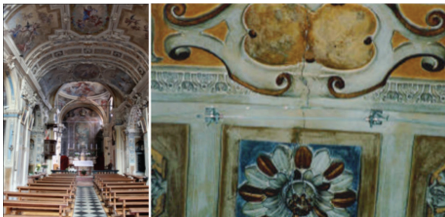
Figura 10. Esquerda - vista geral do interior da igreja; Direita - detalhe da fissura com sensor instalado (INAUDI; CASANOVA; GLISIC, 2001).
