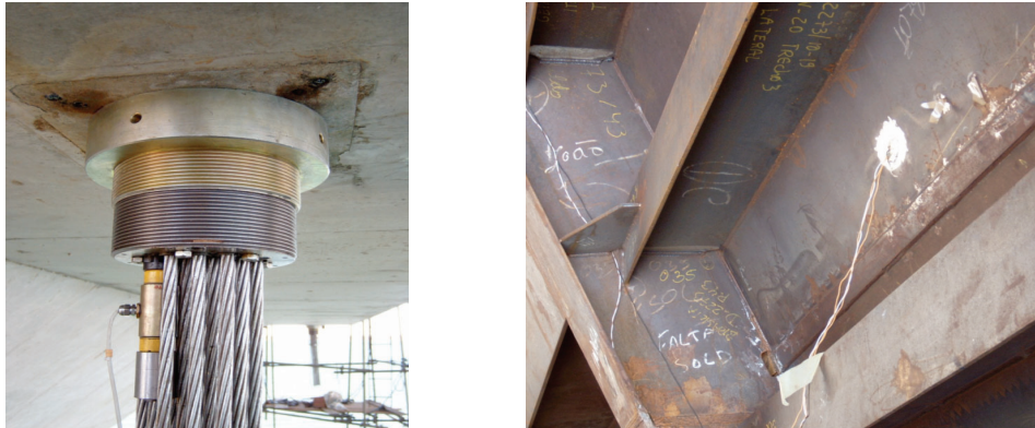
Figura 14. Célula de carga instalada num dos cabos e os strains gauge aplicados na seção do arco (ALMEIDA et. al. , 2006).
