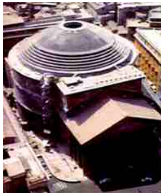
Figura 6. Cúpula del Panteón de Roma construido en concreto en masa, utilizando áridos ligeros, puzolana y cal 118-125 A.D.
