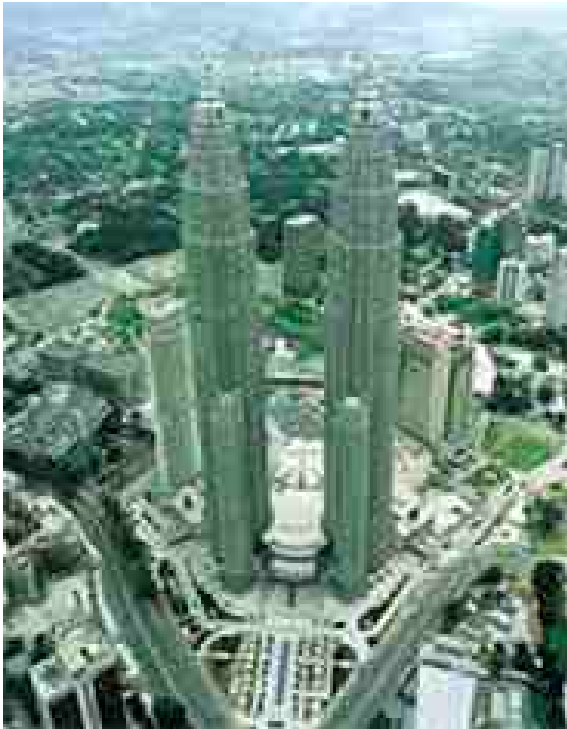
Figura 10. Torre Petronas en Kuala Lumpur, Malasia, el primer edificio en la parte superior de concreto de alto desempeño que superó los edificios de metal altura de 1997.
