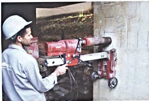
Figura 9 – Extração de testemunhos cilíndricos de concreto da estrutura para avaliação da resistência potencial equivalente do concreto à compressão
