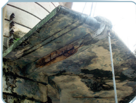
Foto 6 – Consolo com armaduras corroídas e lajes fissuradas apresentando infiltração generalizada
