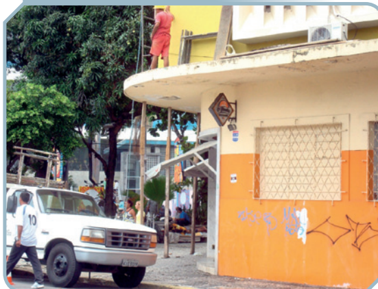
Foto 3 – Escoramento incorreto da M2 no centro do Recife
