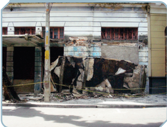
Foto 4 – Colapso total de parte da marquise M3
