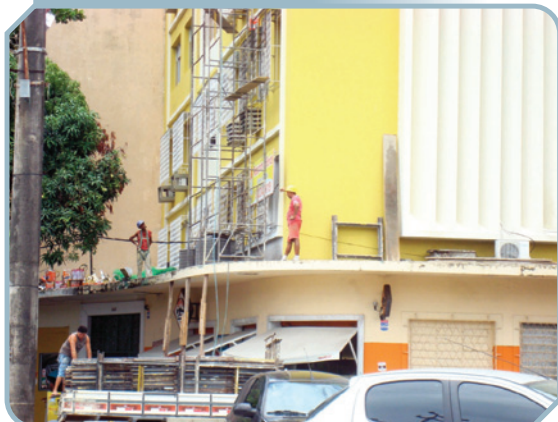
Foto 2 – Detalhe da reforma com homens, andaimes e materiais de construção sobre a M2 no centro do Recife
