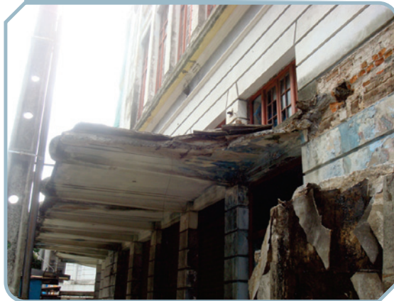
Foto 5 – Trecho da marquise M3 que colapsou
