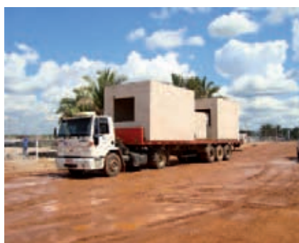
Fig. 1: a) desmoldagem do módulo; b) transporte até a obra; c) montagem da casa
