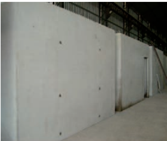
Fig. 5: a) lançamento do CAA; b) desempenho do concreto fresco; c) módulo de CAA
