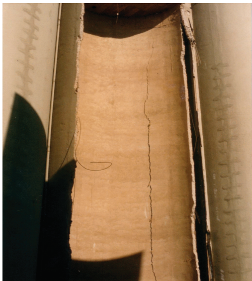
Figura 1. Fissuras verticais em silos por efeito da tração tangencial por erro de projeto, verifica-se que o esforço foi de tal magnitude que um dos silos rompeu.
