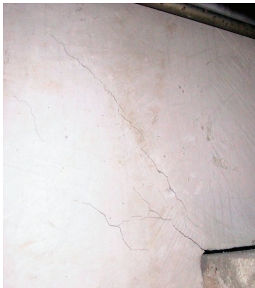
Figura 2. Fissuras em viga pré-moldada provocada por insuficiência de armadura de suspensão.
