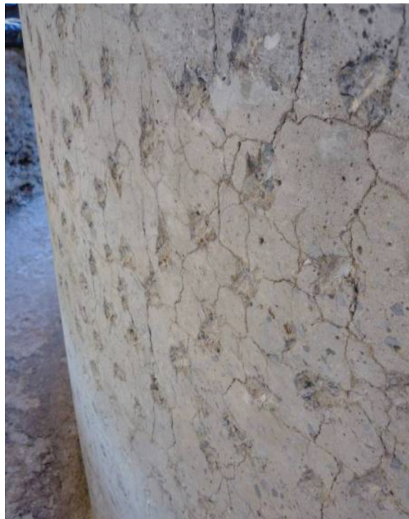
Figura 8. Fissuração intensa e comprometedora em coluna de apoio de grandes dimensões provocada por efeito duplo de expansão por sulfatos e reação álcali-agregado.
