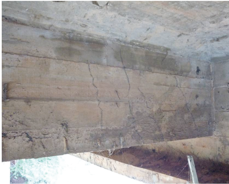
Figura 3. Fissuras de cisalhamento em ponte provocada pela passagem de veículos com carga excessiva, não prevista em projeto.
