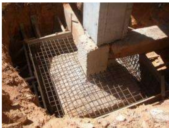
Figura 5.2 Aumento da área de contato da base da sapata.
