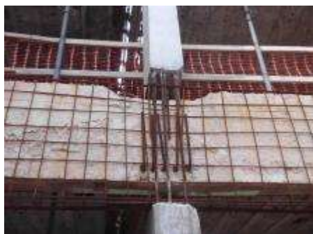
Figura 5.5 Armadura de ancoragem horizontal em laço.
