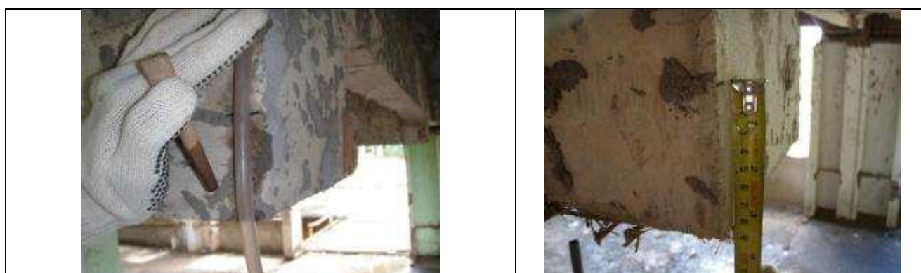
Figura 3.6 Medição de flecha em viga em balanço com auxílio de mangueira de nível.
