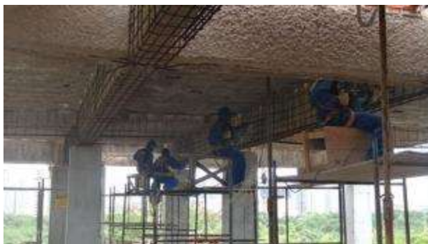
Figura 5.1 Escarificação de vigas no 1º Pavimento do prédio.
