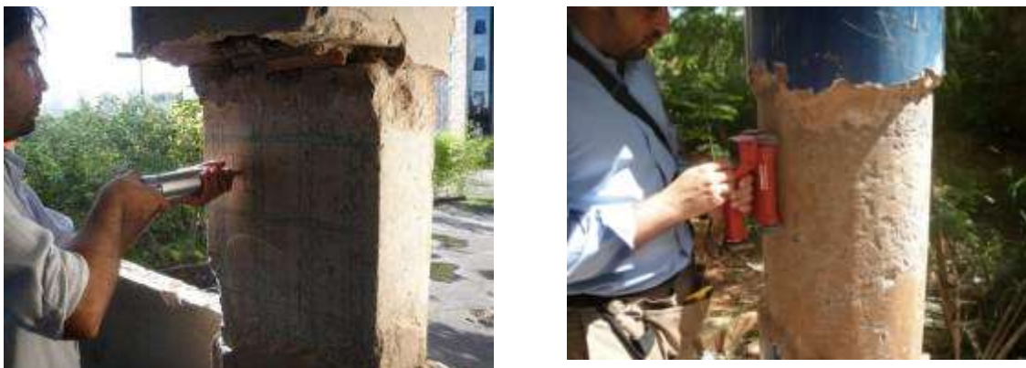
Figura 3.1 Ensaio de esclerometria e utilização de pacômetro para identificação das armaduras.
