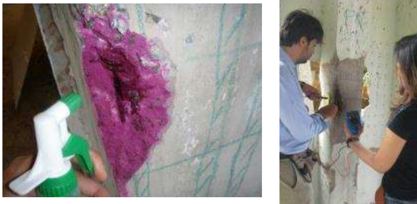
Figura 3.4 Medições da profundidade de carbonatação e do potencial de corrosão.
