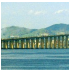
Ponte Rio-Niterói: exemplo emblemático de estruturas de concreto resistentes às reações químicas e físicas impostas pelo mar.
