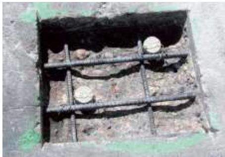
Figura 2 - Comparação do remédio da medicina com o reparo com uso de pastilhas para proteção catódica das armaduras da engenharia civil
